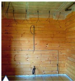
Инженерная подготовка влажной зоны
