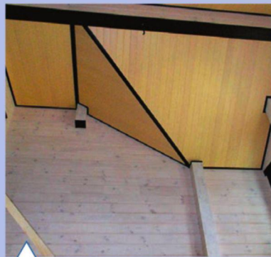
Финишная отделка стен и потолка
