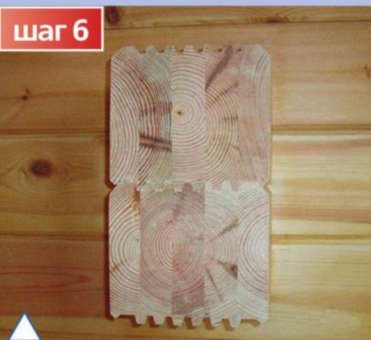
Вид стен сразу после сборки сруба
