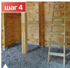
Устройство чернового пола
