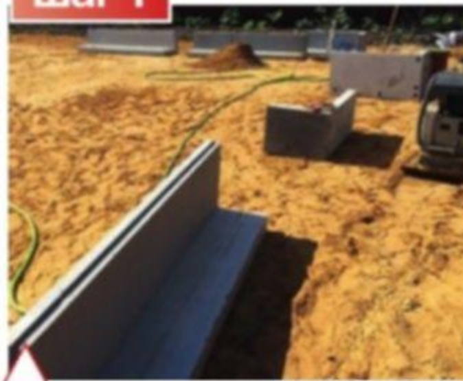
Монтаж опалубочных фундаментных панелей
