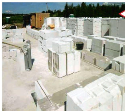
Укладка первых рядов блочных стен
