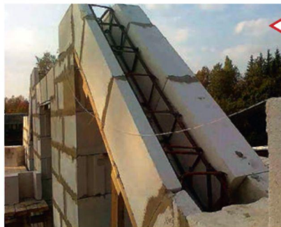
Армирование наклонной перемычки
