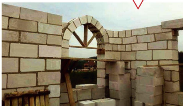
Арочная перемычка из газобетонных блоков
