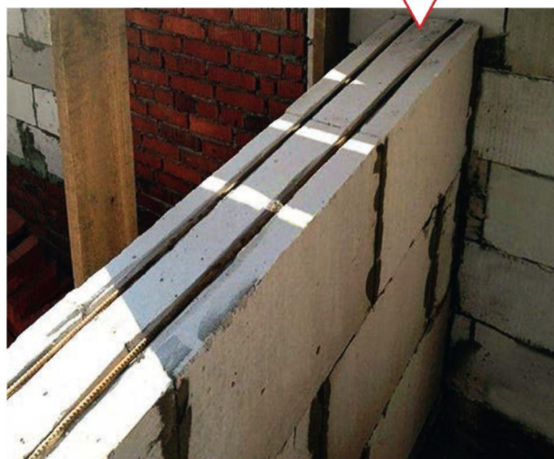
Примыкание перегородок к блочным стенам
