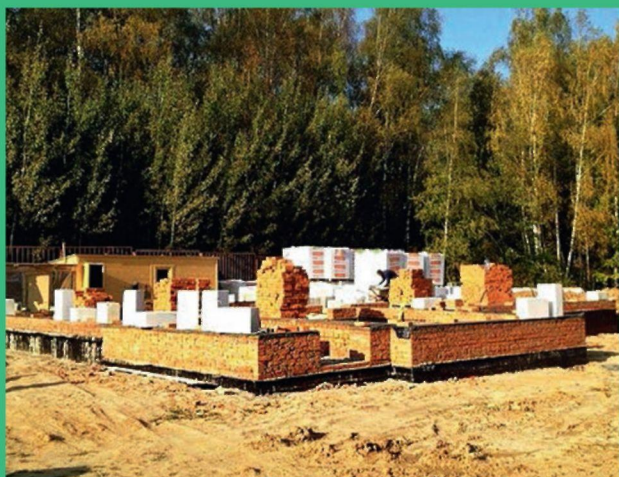
На плите возвели кирпичный цоколь и складировали газобетонные блоки
