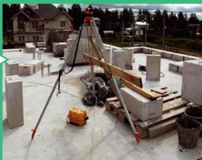
Приступили к возведению стен мансардного этажа
