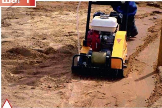
Уплотнение песчаной подушки электромеханической трамбовкой
