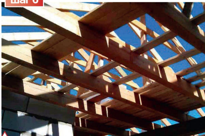
Чердачное перекрытие в составе стропильной конструкции крыши
