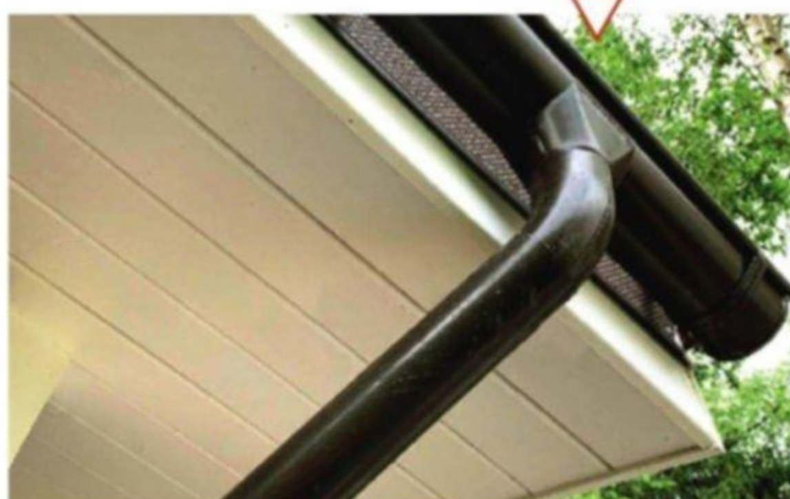
Подшивка свесов белой вагонкой и фрагмент водосточной системы
