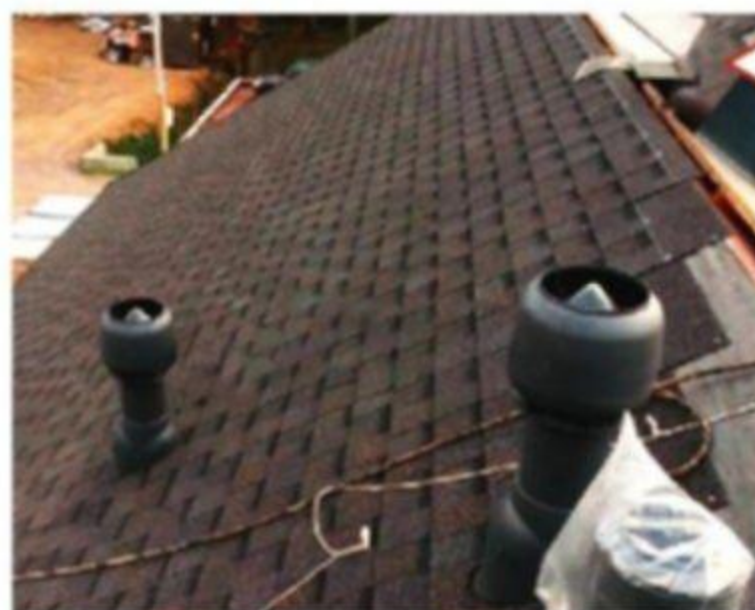
Укладка битумной черепицы
