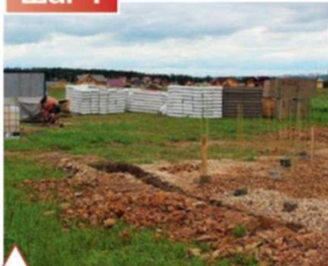
Сверление скважин под буронабивные сваи
