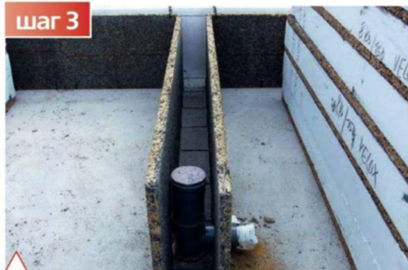
Прокладка инженерных коммуникаций внутри несъемной опалубки
