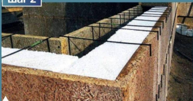
Монтаж опалубки стен первого этажа
