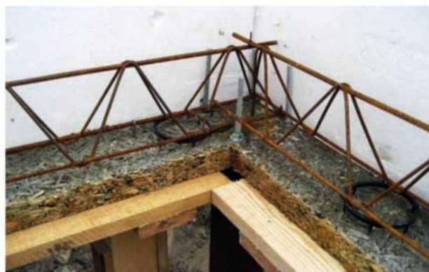
Прокладка инженерных коммуникаций внутри несъемной опалубки
