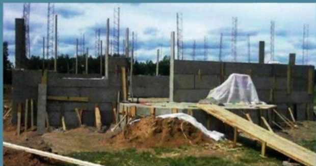
Установка арматурных каркасов перед заливкой бетона в опалубку
