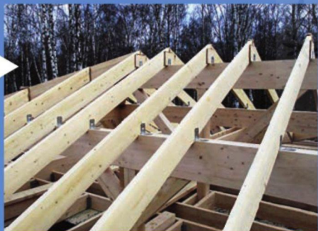
Сооружение стропильной конструкции
