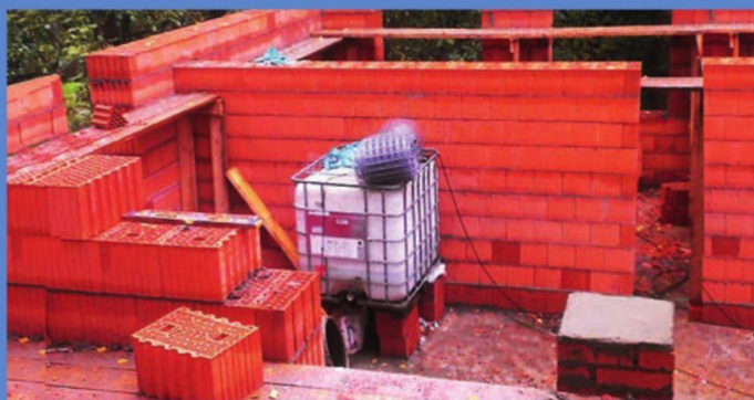
Складирование керамических камней на перекрытии технического этажа
