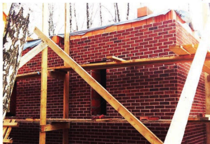
Облицовка наружных стен декоративным кирпичом
