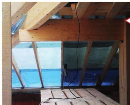
Монтаж подкровельной гидроизоляции
