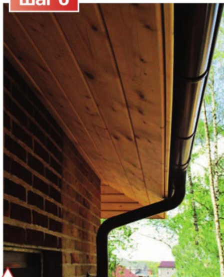
Подшивка карнизных свесов
