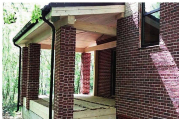
Облицовка колонн крыльца декоративным кирпичом
