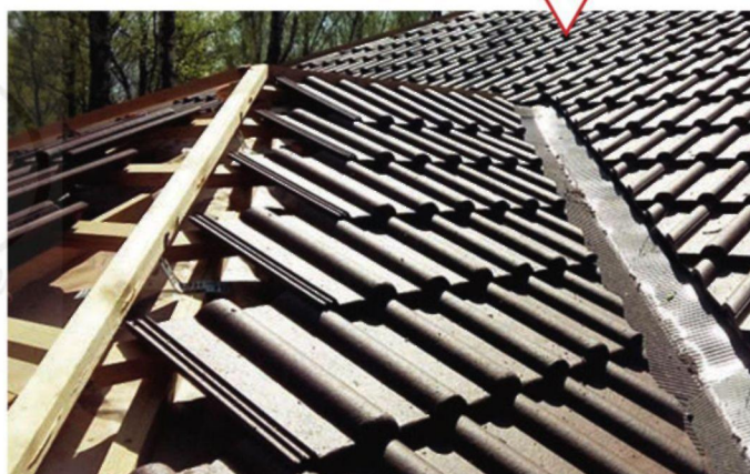
Укладка цементно-песчаной черепицы
