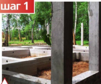
Монолитный ленточный фундамент с колоннами крыльца
