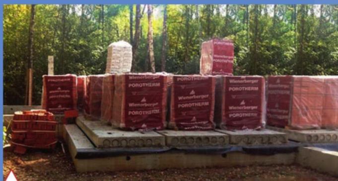
Складирование керамических камней на перекрытии технического этажа
