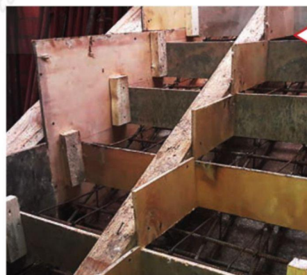
Сборка опалубки монолитной лестницы
