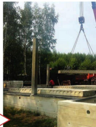
Монтаж сборных железобетонных плит перекрытия технического этажа
