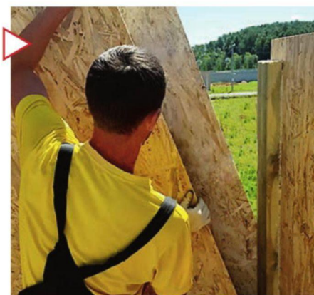
Стыковка СИП панелей на перекрытии первого этажа
