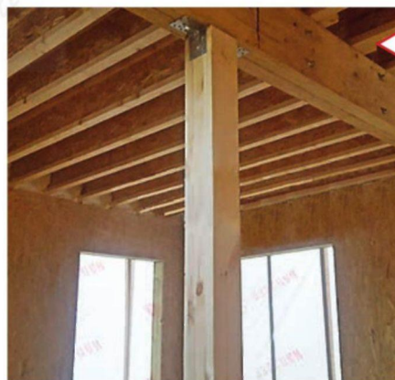
Стыковка СИП панелей на перекрытии первого этажа
