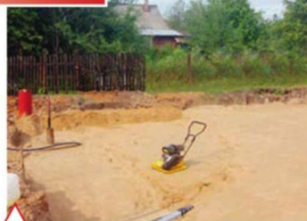
Уплотнение песчаного слоя виброплитой
