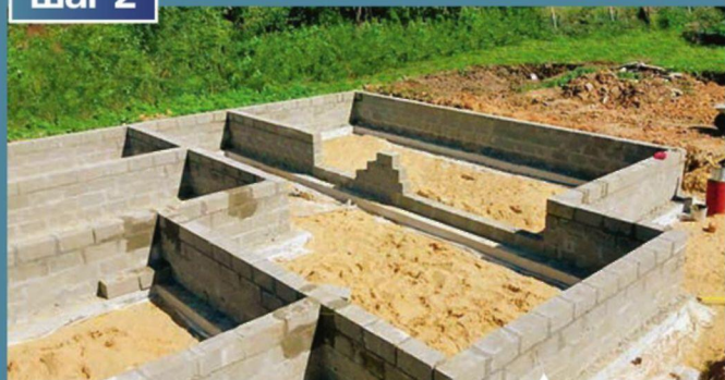
Возведение цоколя из цементно-песчаных блоков
