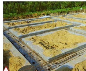
Монтаж арматурного каркаса монолитной ленты
