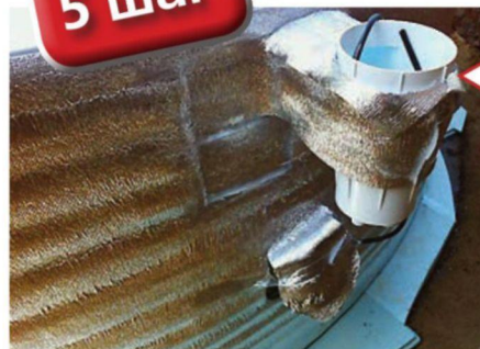
Утепление стенок бассейна фольгированным вспененным полиэтиленом
