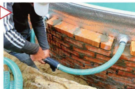
Подключение шлангов к скиммерам и форсункам
