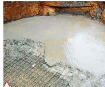
Бетонирование монолитной базы бассейна
