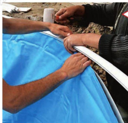
Пленку фиксируют к борту верхней планкой
