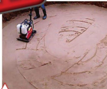
Уплотнение песчаного слоя виброплитой
