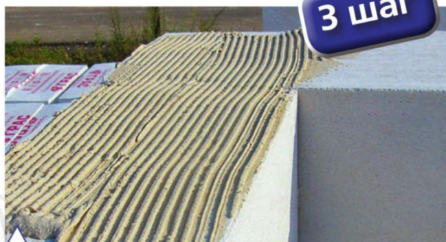
Нанесение «теплого» кладочного раствора зубчатой кельмой
