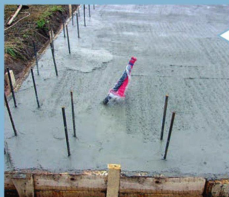
Арматурные стержни для крепления стен
