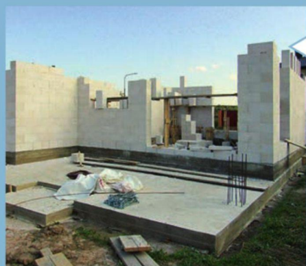
Возведение стен первого этажа
