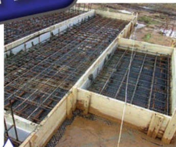
Монтаж арматурного каркаса в контуре деревянной опалубки
