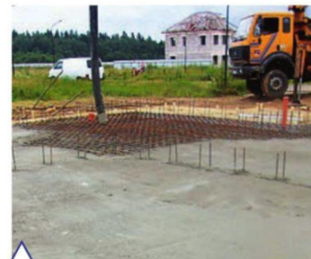
Бетонирование фундаментной плиты
