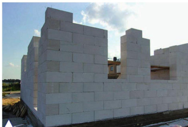
Кладка блочных стен по причалке
