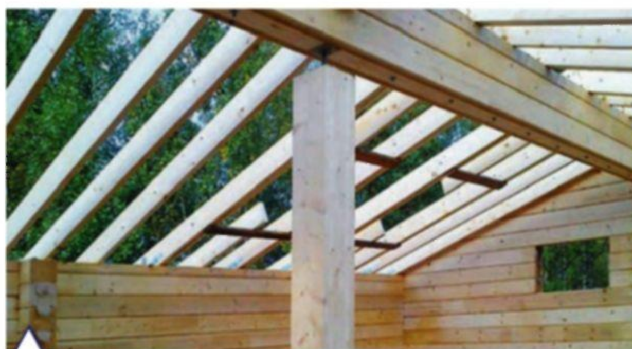
Возведение стропильной конструкции скатной крыши.
