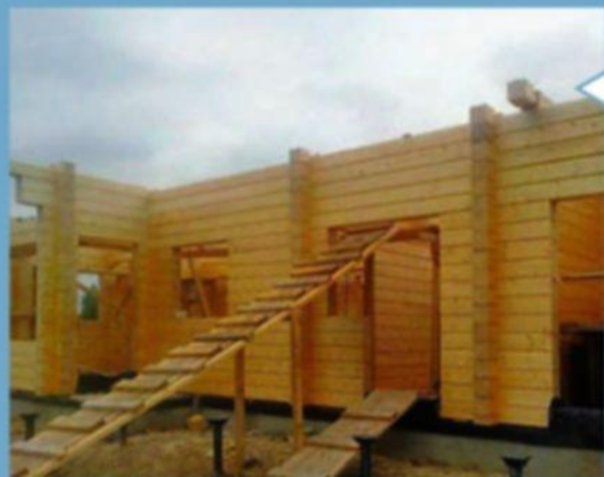
Сборка первого этажа сруба
