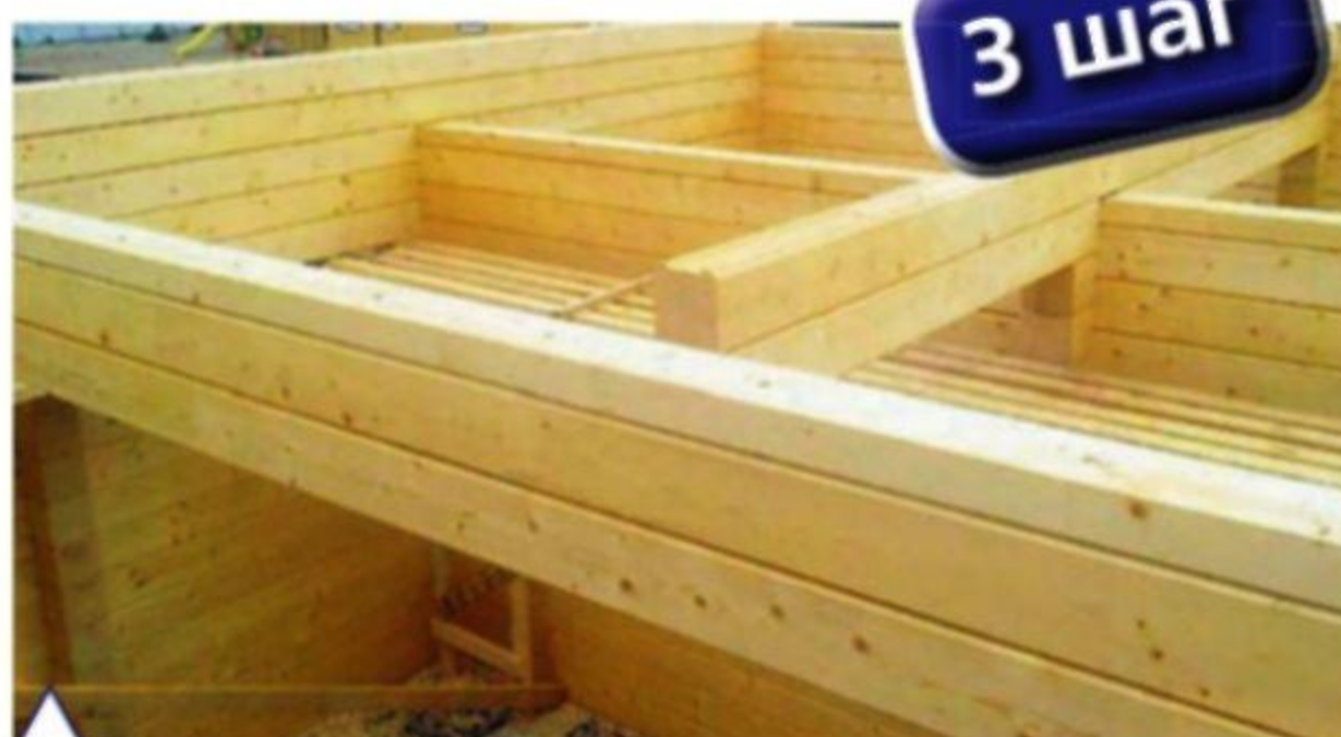
Стены подготовлены к устройству междуэтажного перекрытия и сооружению стропильной крыши.
