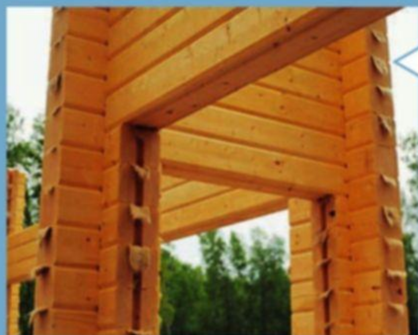
Межвенцовый уплотнитель брусчатых стен.
