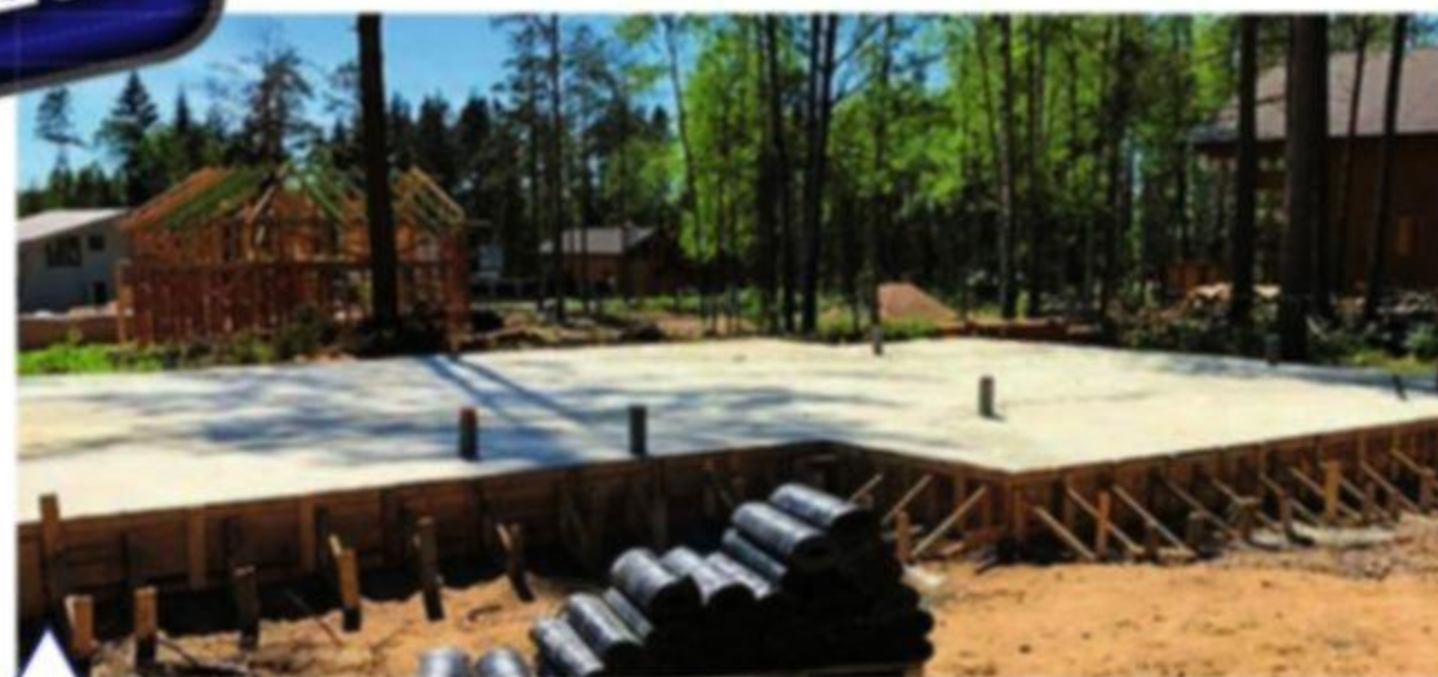
Монолитная железобетонная плита подготовлена к монтажу горизонтальной гидроизоляции
