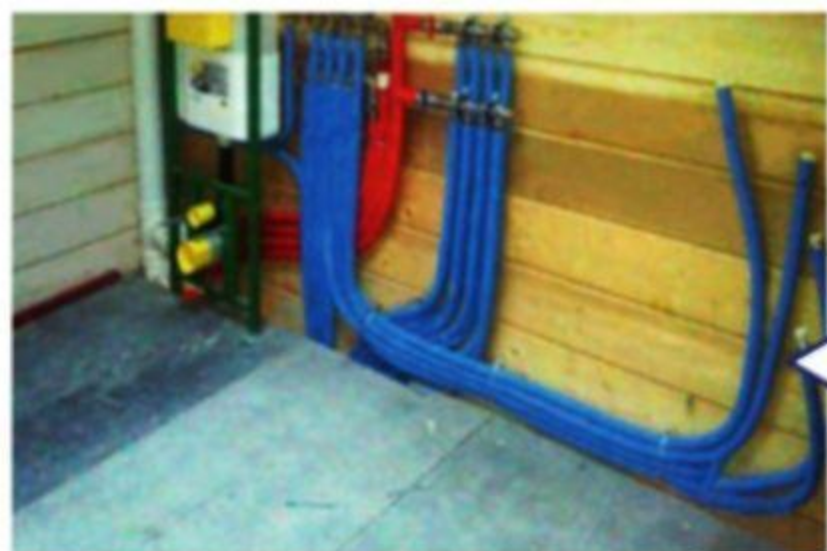
Отделка санузла на первом этаже
