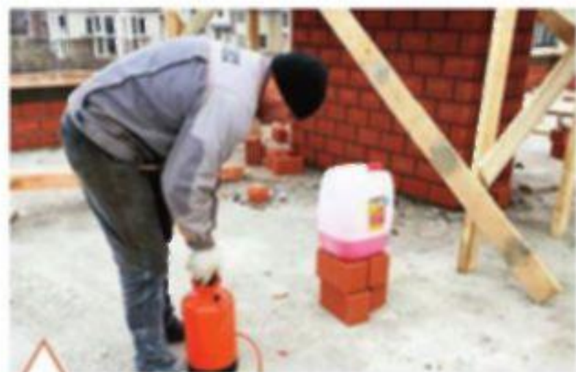
Подготовка оборудования для нанесения огнебиозащитного состава на деревянные элементы стропильной конструкции скатной крыши
