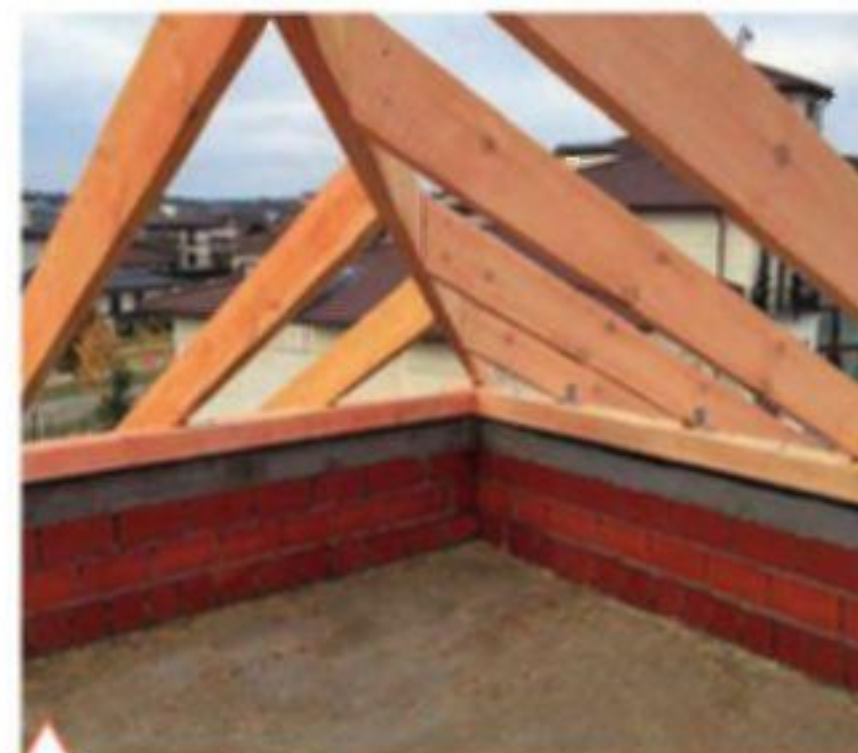
Возведение стропильной конструкции крыши
