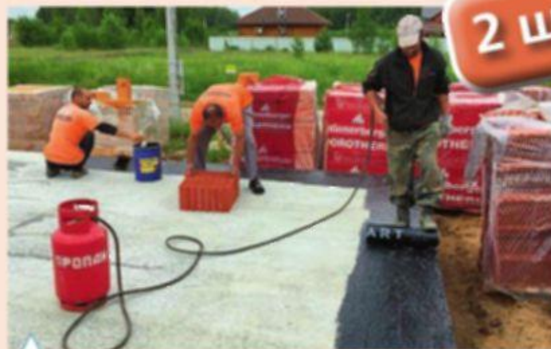
Устройство горизонтальной гидроизоляции фундаментной плиты
