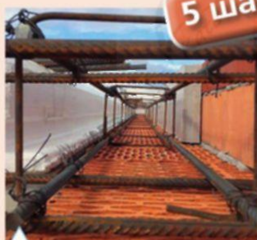
Арматурный каркас междуэтажного монолитного перекрытия
