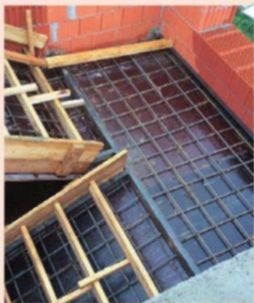
Опалубка из бакелизированной фанеры для сооружения монолитной лестницы
