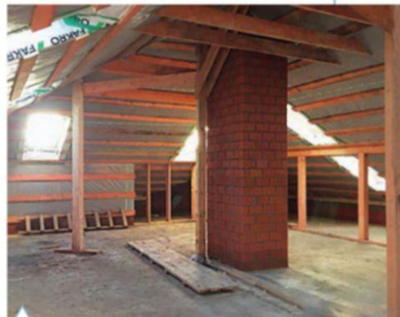
Мансарда готова для выполнения отделочных работ
