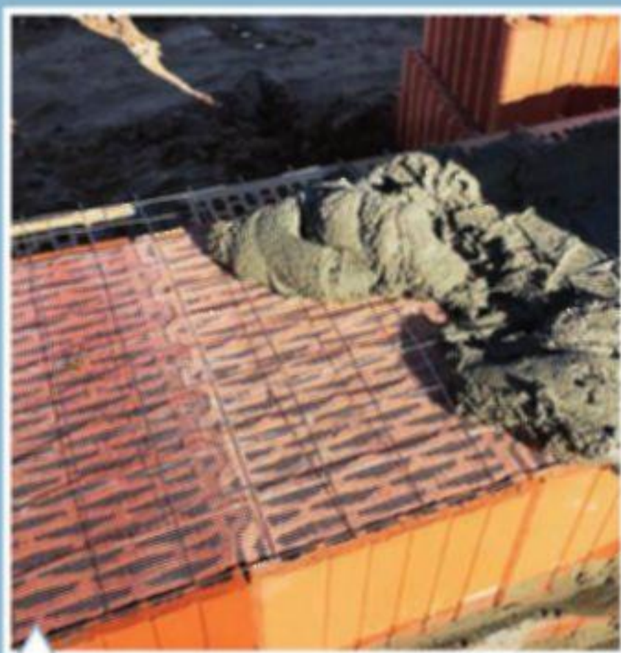
Структура горизонтальных швов блочной кладки
