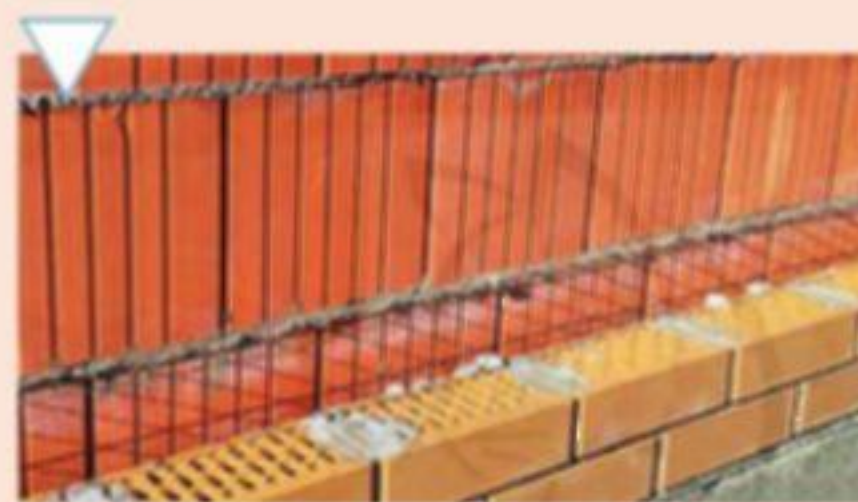
Возведение стен мансардного этажа
