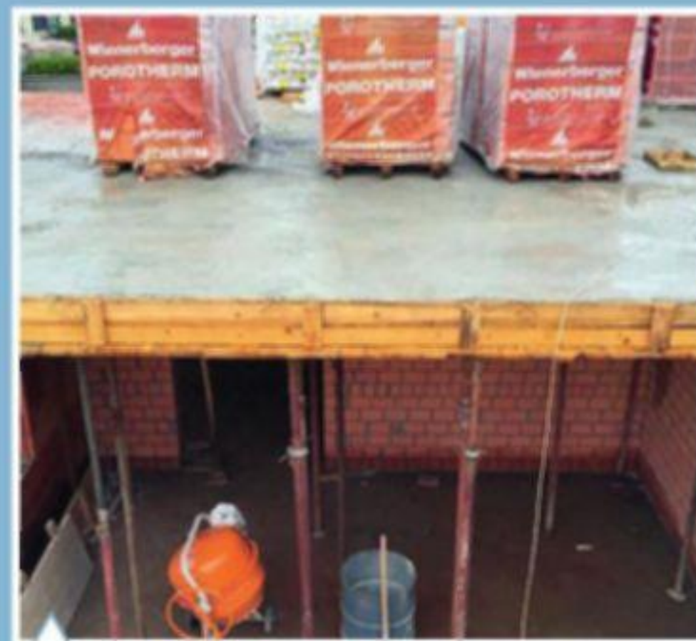
На готовом перекрытии складировали блоки для возведения стен мансардного этажа
