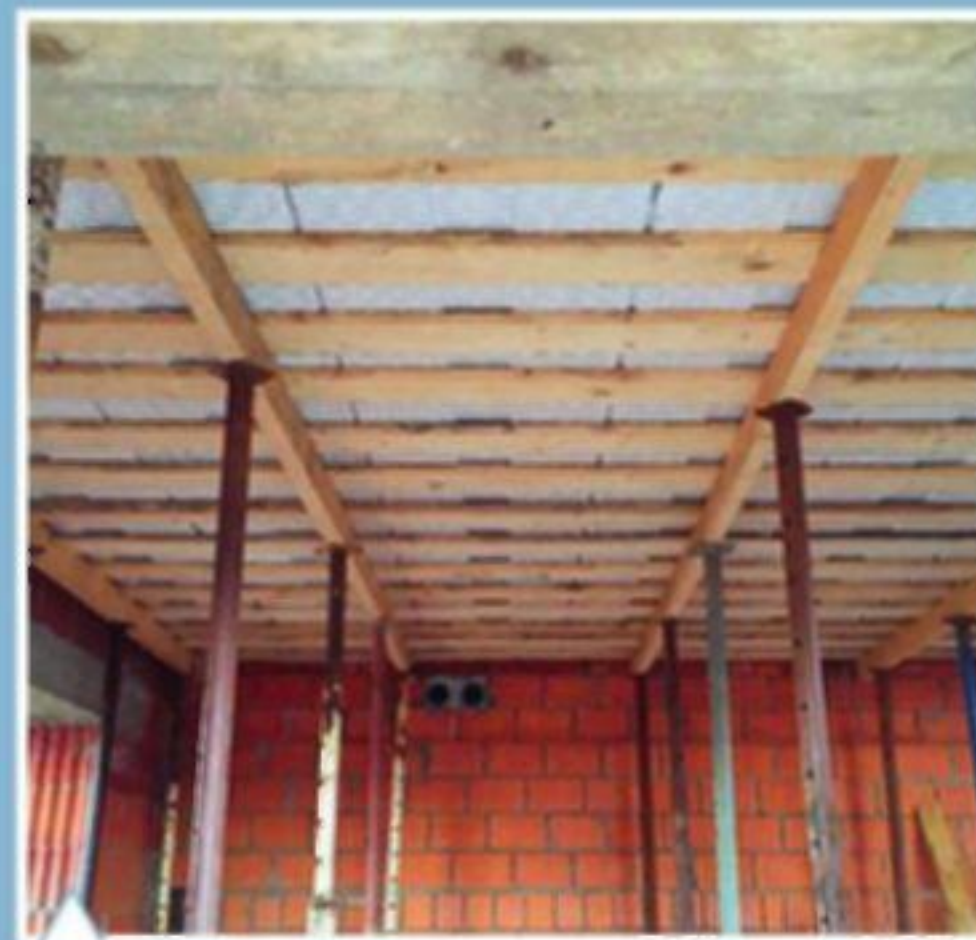
Утепление стены по периметру перекрытия; два слоя пенополистирола
