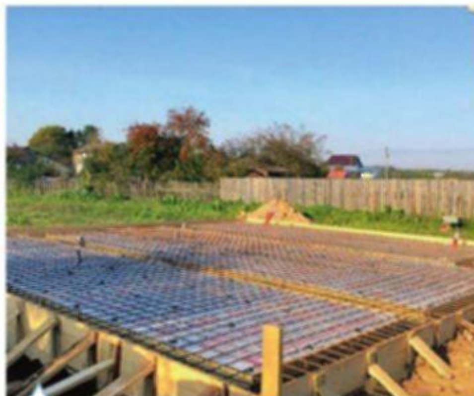
Заливка бетонной смеси в опалубку монолитной фундаментной плиты
