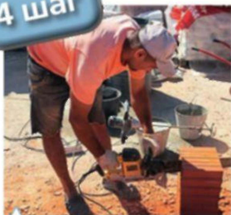
Заготовка доборных элементов путем резки цепной пилой
