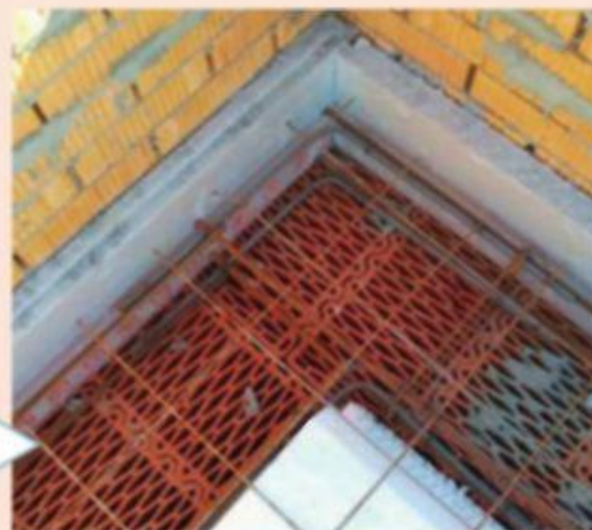
Арматурный каркас междуэтажного монолитного перекрытия
