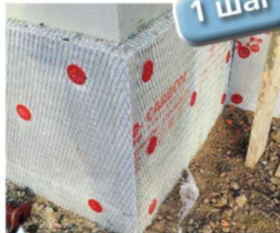
Утепление мелкозаглубленного фундамента и фиксация сетки для крепления цокольной облицовки
