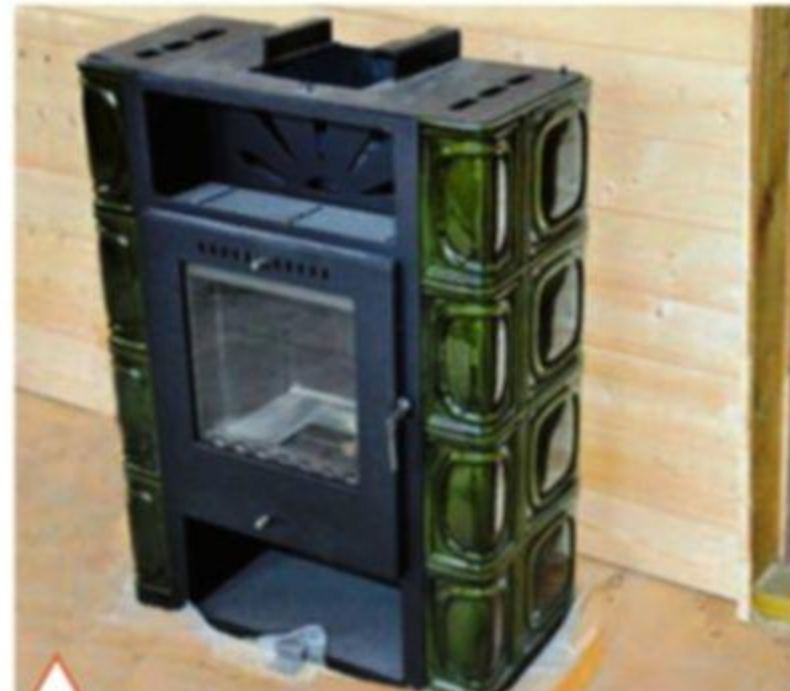
Установка каминной печи в мансарде
