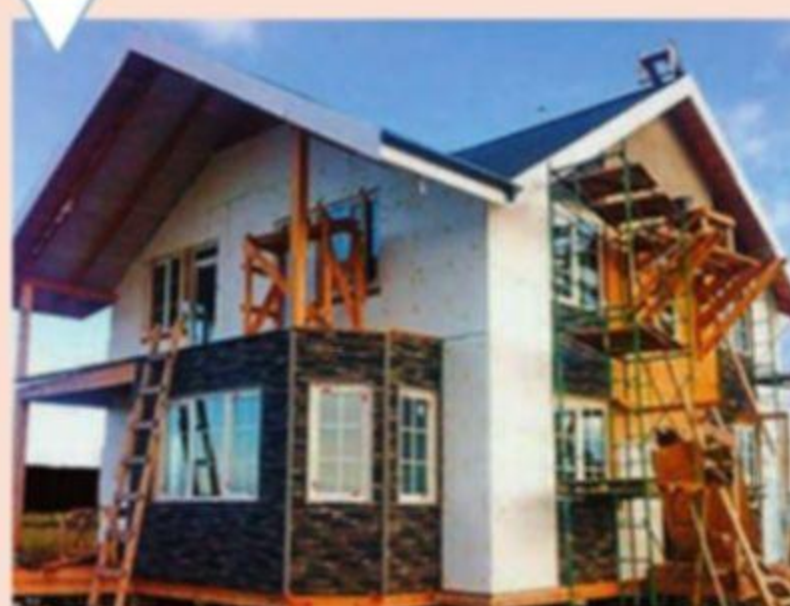
Утепление и отделка фасадов
