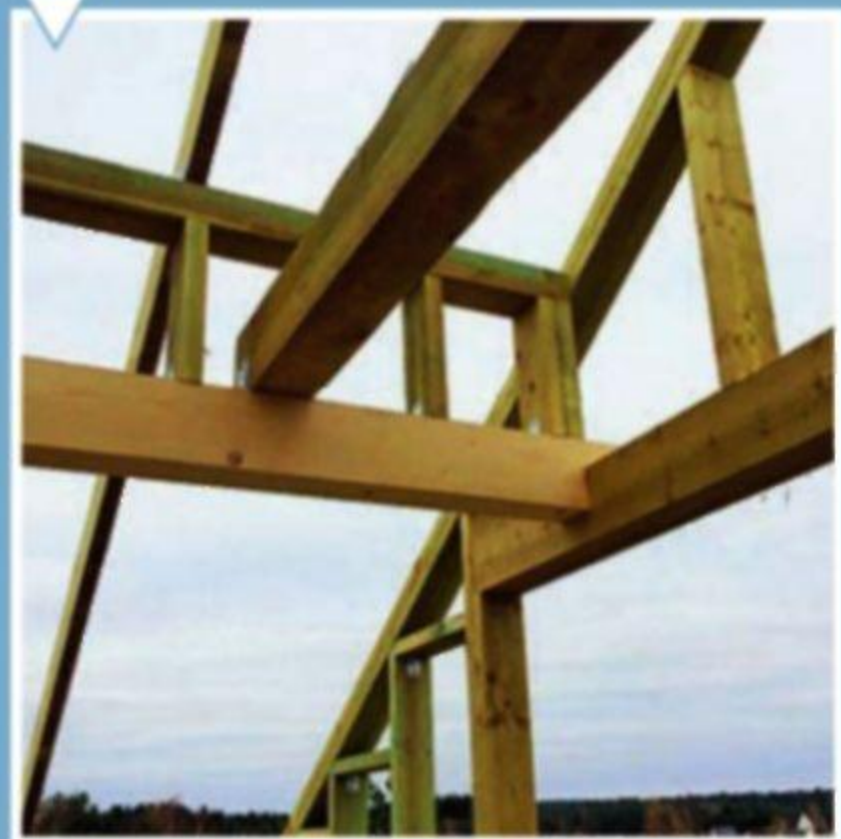
Возведение стропильной конструкции скатной крыши
