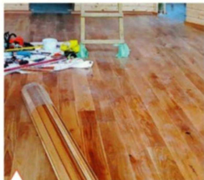
Укладка напольного покрытия в гостиной
