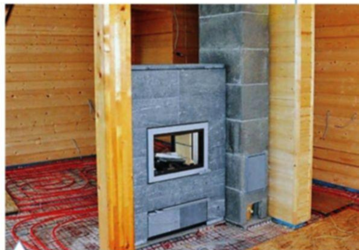
Монтаж финского камина из горшечного камня и отопительных контуров водяных полов
