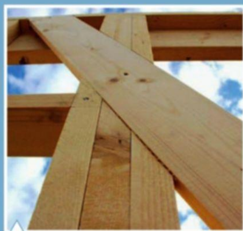
Монтаж каркаса второго этажа (ветровая связь)
