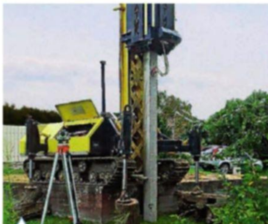
Забивка железобетонных свай малого формата
