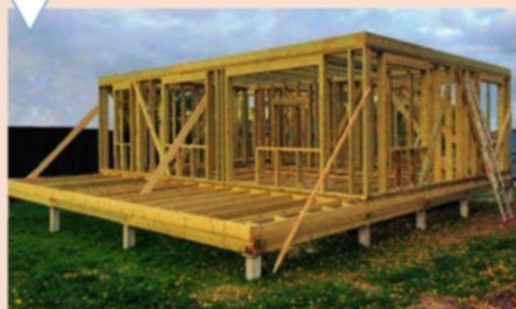
Сборка каркасной конструкции первого этажа
