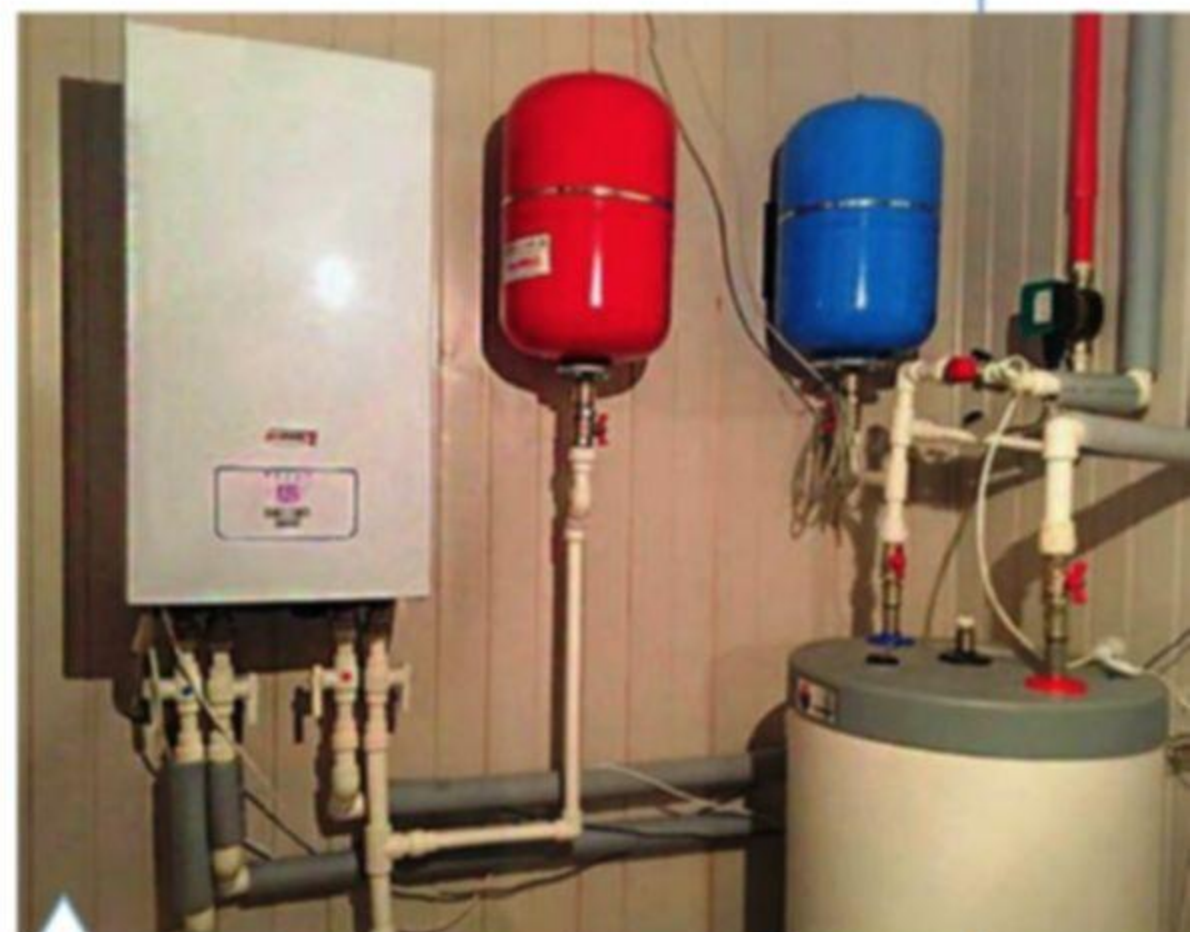
Обустройство котельной (технического помещения)
