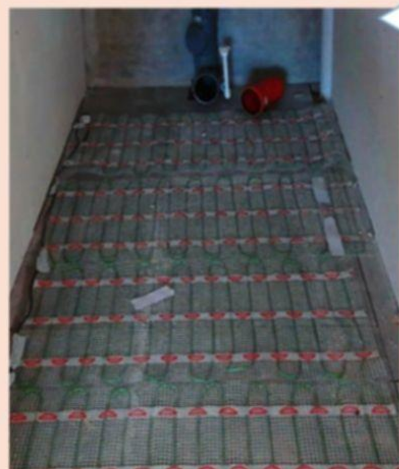
Монтаж системы кабельного напольного отопления
