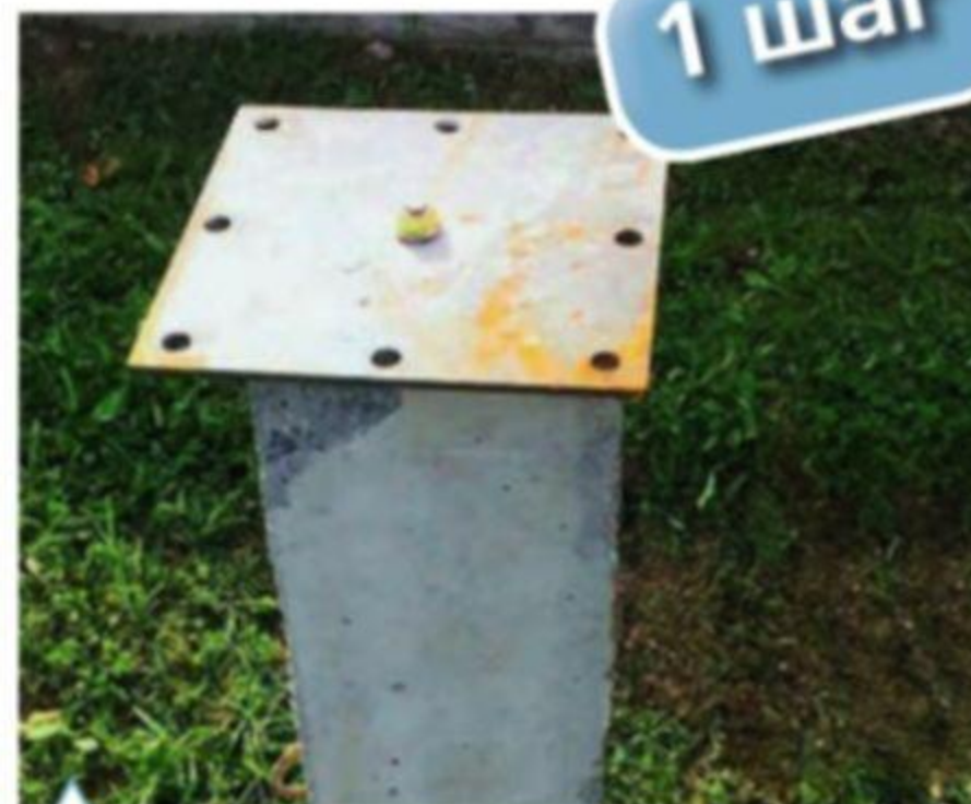
Установка оголовков из листовой стали толщиной 8 мм
