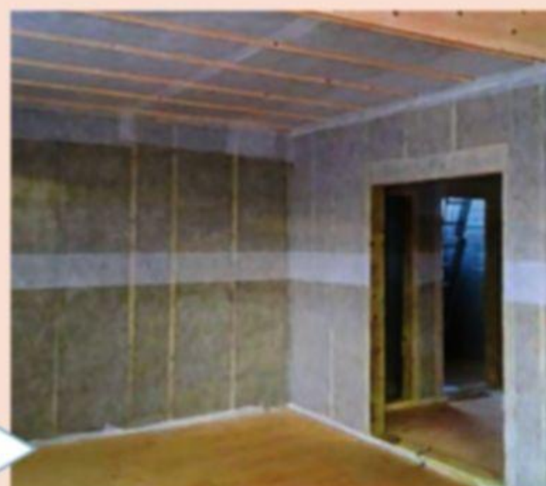
Заполнение каркаса минеральной теплоизоляцией из базальтового волокна
