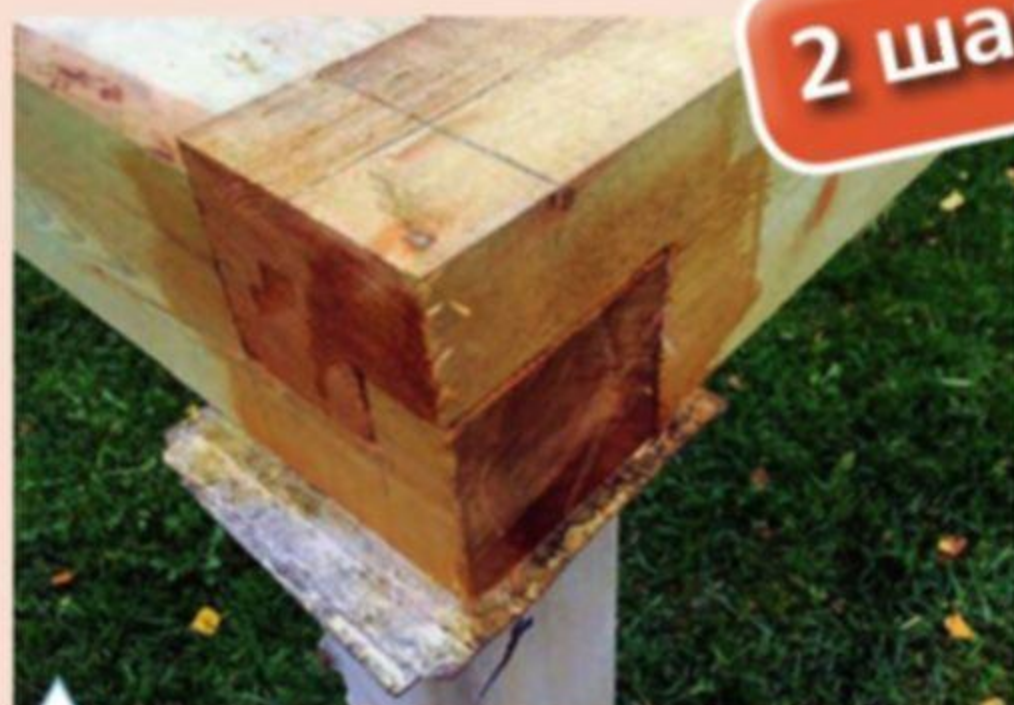
Монтаж нижней обвязки деревянного каркаса дома
