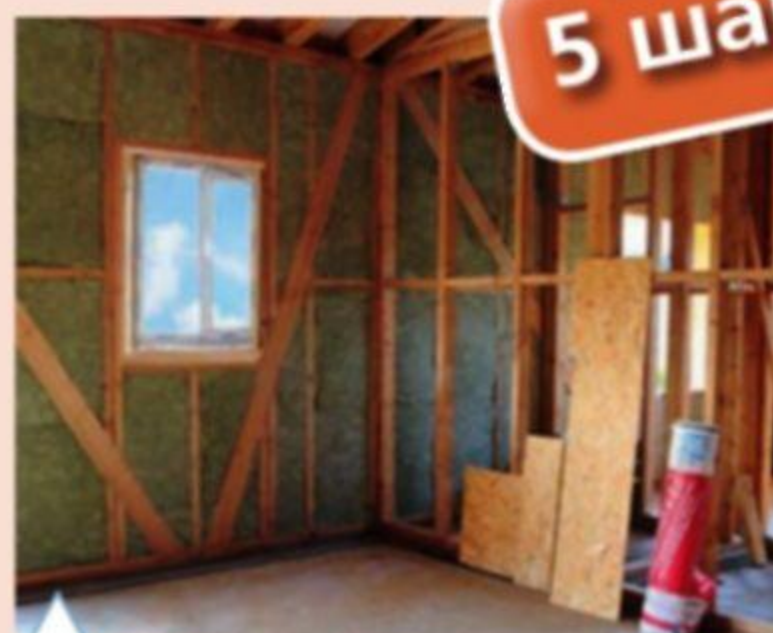
Заполнение каркаса минеральной теплоизоляцией из базальтового волокна
