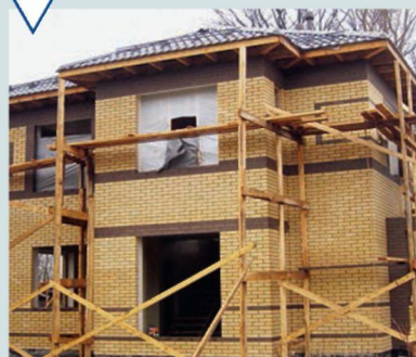
Завершение отделки фасада
