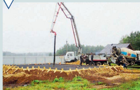
Бетонирование фундаментной плиты
