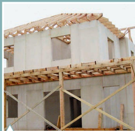
Монтаж каркаса крытой террасы
