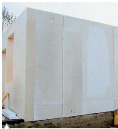
Угловой стык панельных стен первого этажа
