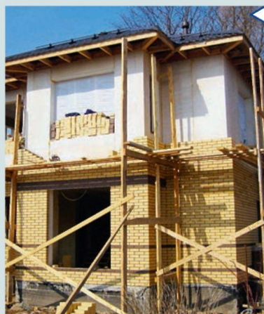
Возведение стен из лицевого кирпича
