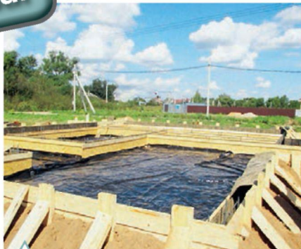
Выполнены земляные работы и гидроизоляция под плиту
