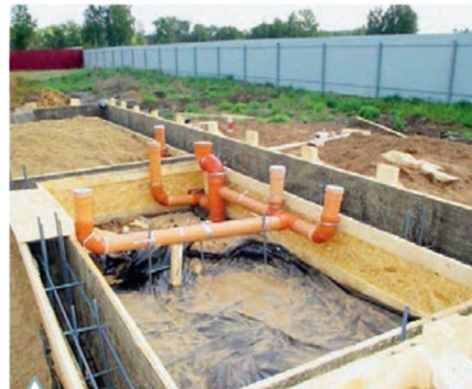
Ввод инженерных коммуникаций
