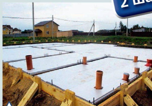
Укладка теплоизоляции плитного фундамента
