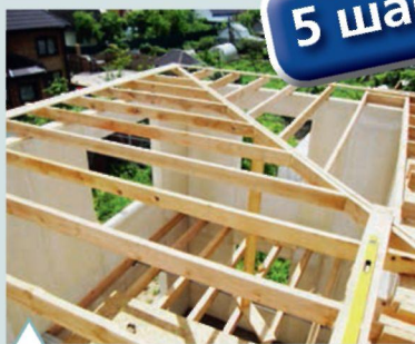
Монтаж стропильной конструкции скатной крыши
