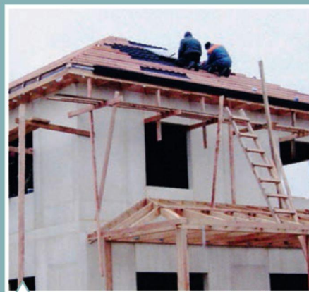
Укладка металлочерепицы
