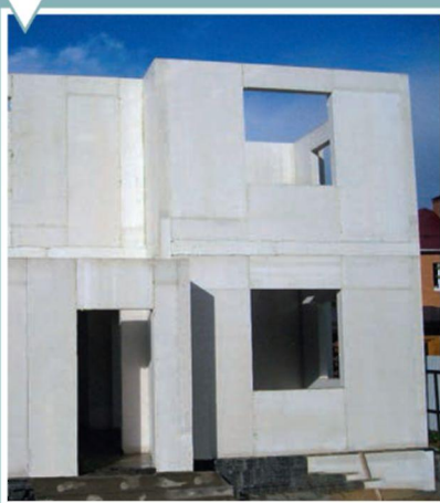
Сборка коробки панельного дома
