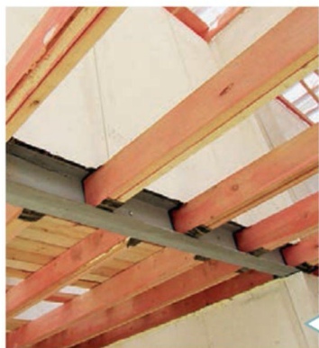
Монтаж стальных балок перекрытия
