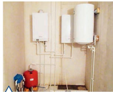
Смонтированы газовый и резервный электрический котлы отопления
