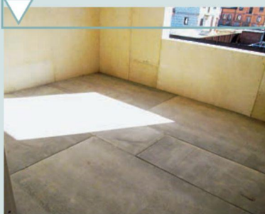
Перекрытие готово к укладке напольного покрытия
