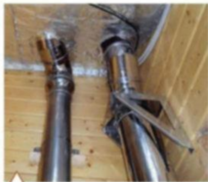
Монтаж модульного дымохода
