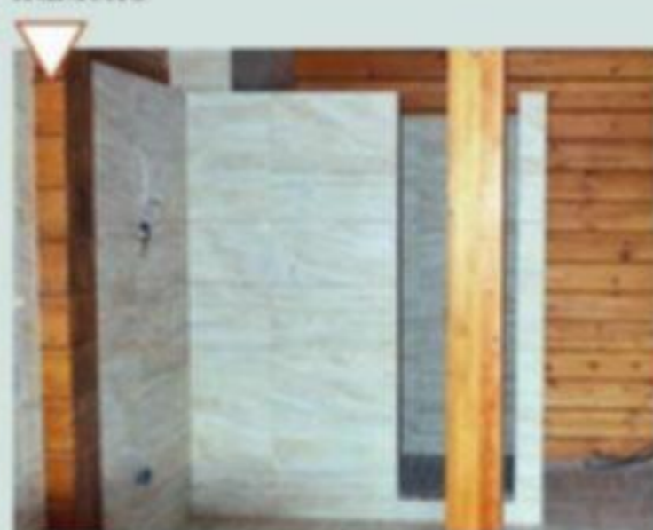
Отделка ванной комнаты плиткой под натуральный камень
