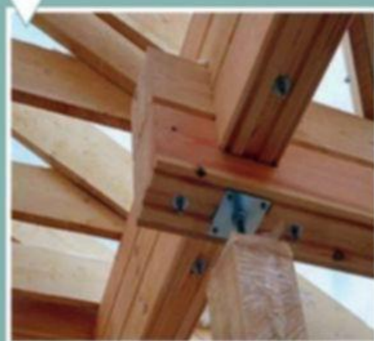
Винтовой компенсатор для регулирования естественной усадки бруса
