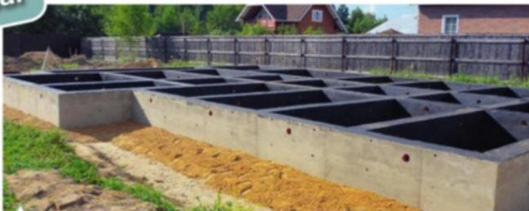
Фундамент с выполненной гидроизоляцией
