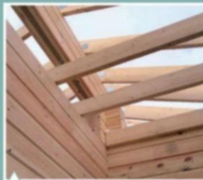
Сооружение стропильной конструкции скатной крыши
