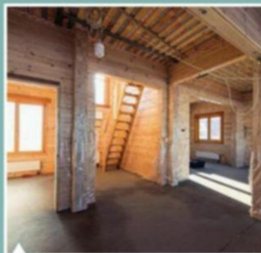
Первый этаж в процессе отделочных работ
