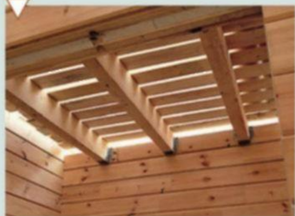
Балочное перекрытие первого этажа
