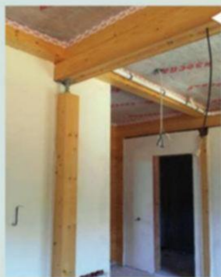
Гипсокартонная отделка стен в одной из детских спален
