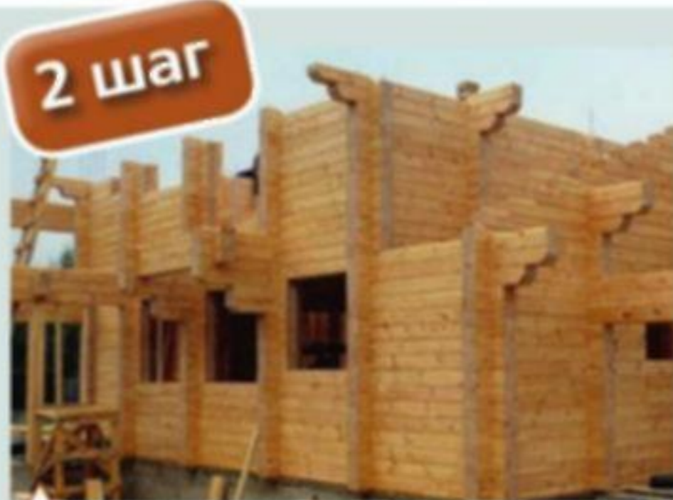
Сборка стен первого и второго этажа
