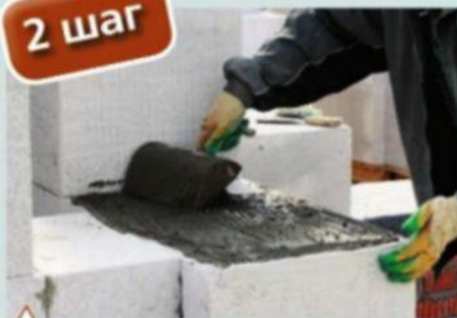
Укладка первого ряда газобетонных блоков
