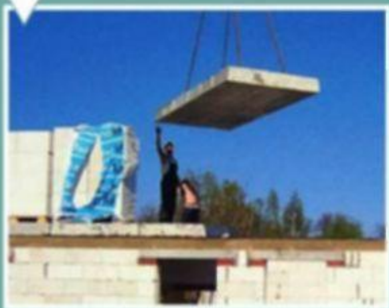
Монтаж железобетонных плит перекрытия первого этажа
