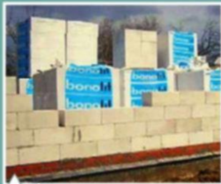
Стены возведены до уровня оконных проемов
