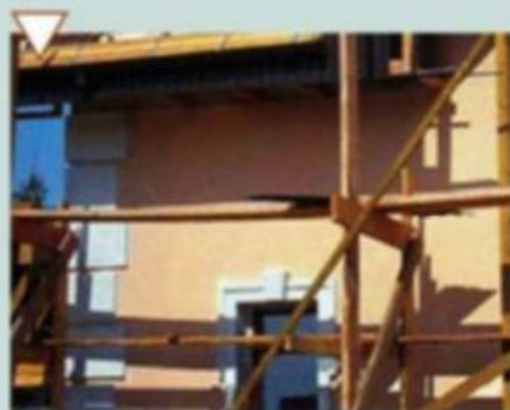
Стены покрасили фасадной краской двух цветов
