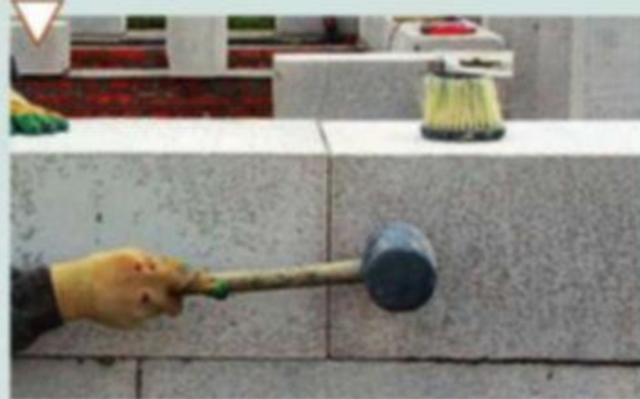
Корректировка положения блоков резиновой киянкой
