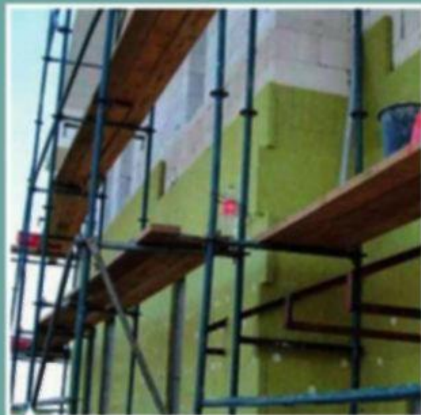
Монтаж фасадной теплоизоляции
