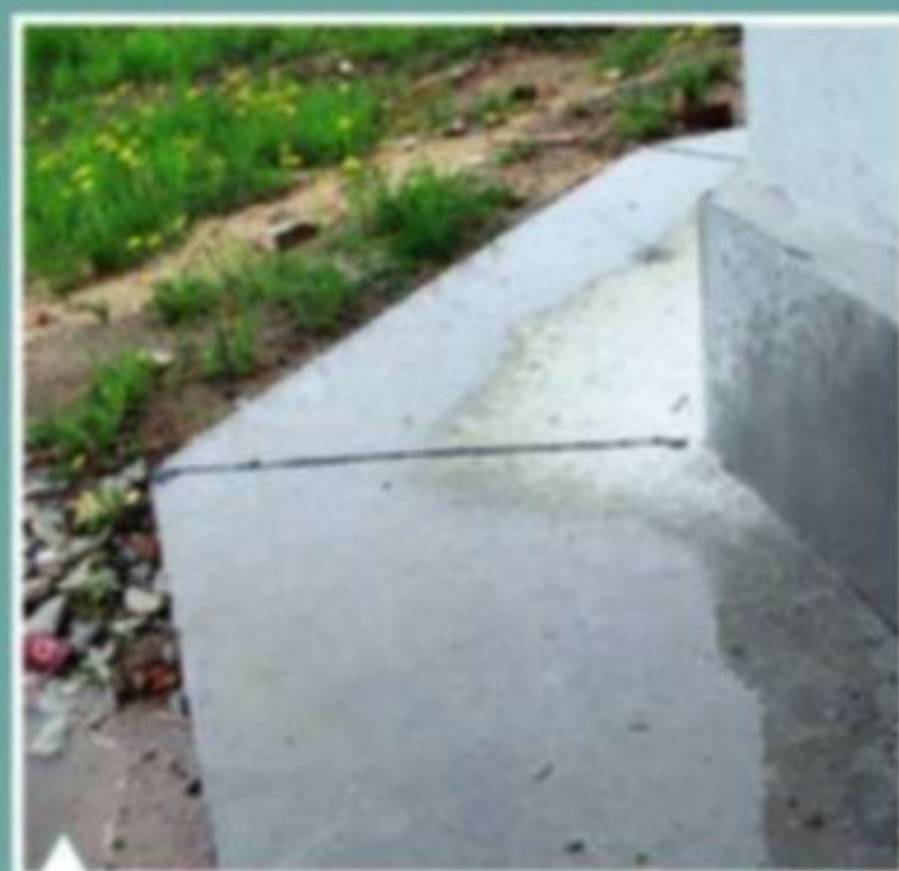
Монолитная отмостка по периметру дома
