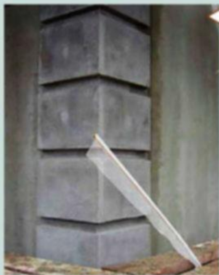
Штукатурный фасад готов к нанесению декоративного слоя
