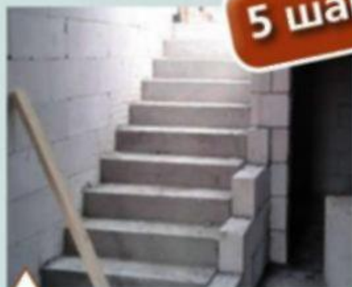
Монолитная лестница на второй этаж
