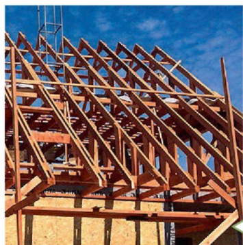
Монтаж фронтонов мансардной крыши
