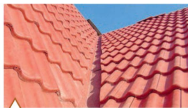
Обустройство ендовы на черепичной кровле
