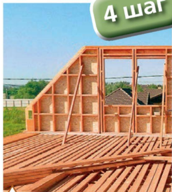
Монтаж фронтонов мансардной крыши
