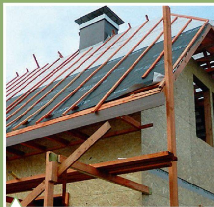
Монтаж подкровельной гидроизоляции
