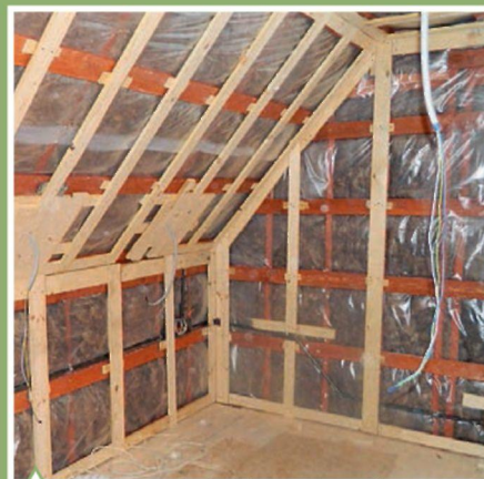
Монтаж пароизоляции
