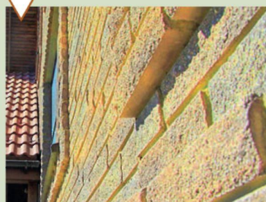
Облицовка фасадов лицевым кирпичом
