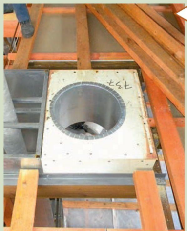
Подготовка перекрытия к установке модульного дымохода
