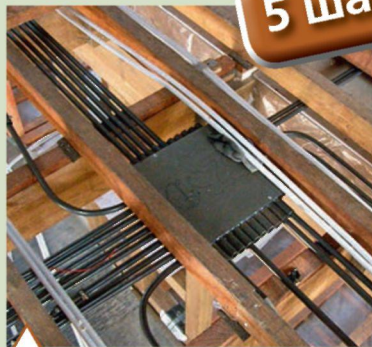
Монтаж электропроводки в структуре междуэтажного перекрытия
