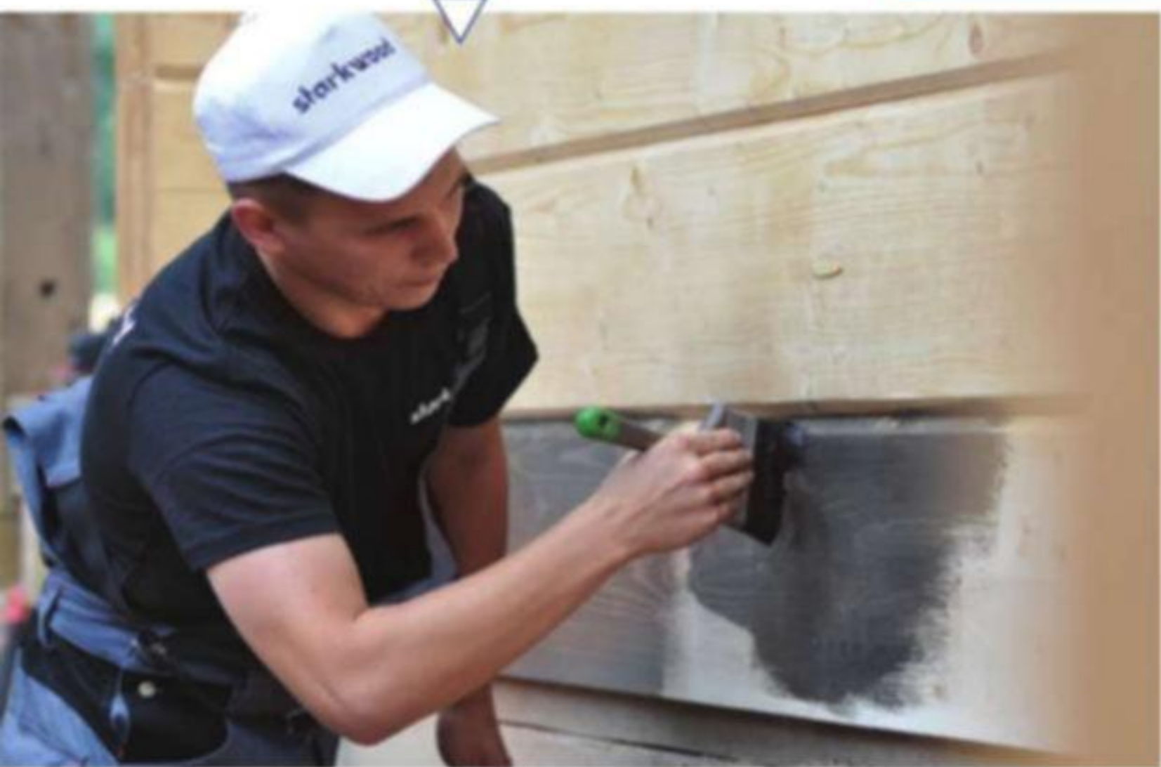
Нанесение защитно-декоративного масла Osto на стены из клееного бруса
