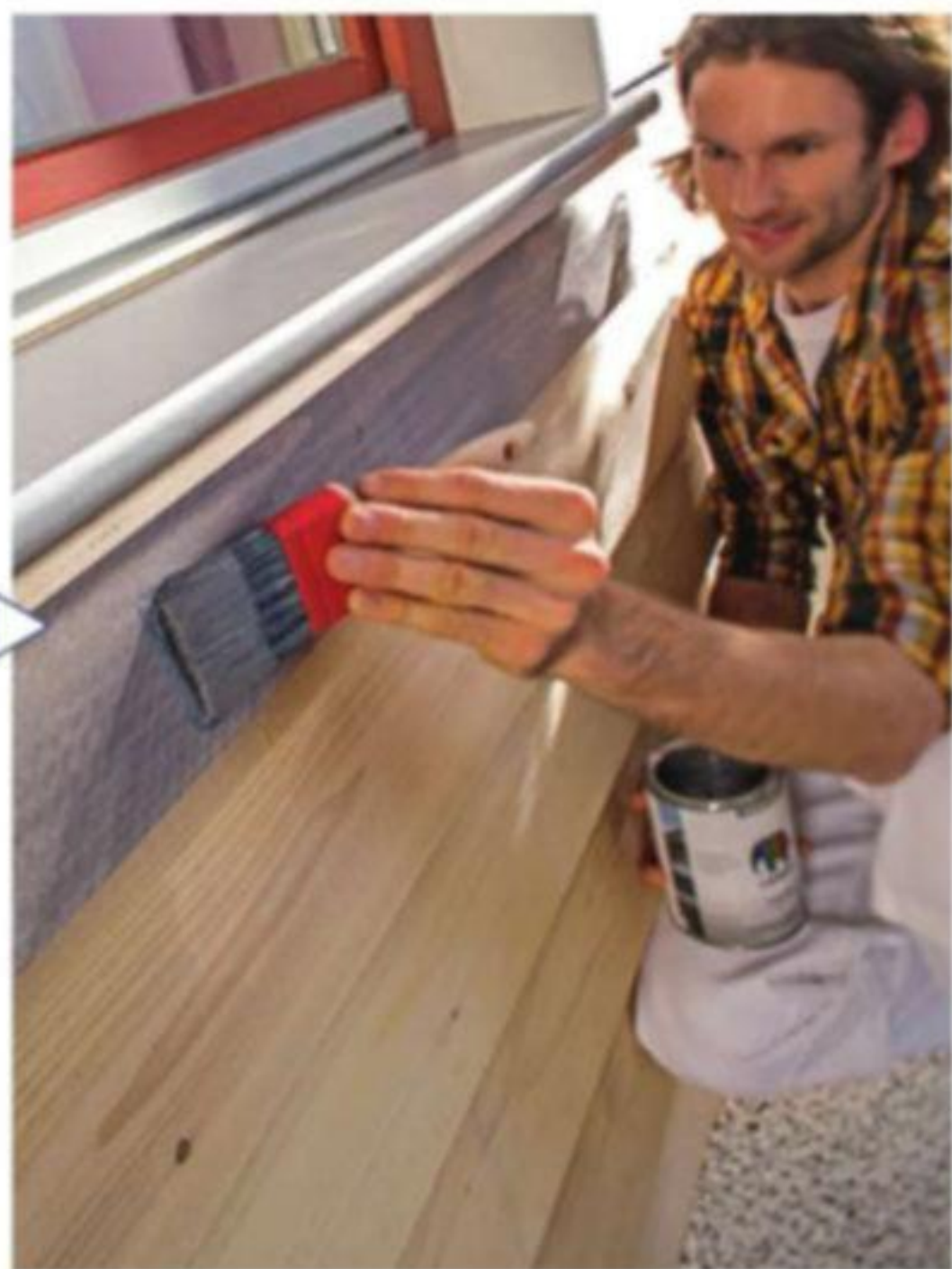
Процесс нанесения защитно-декоративного состава Saparol
