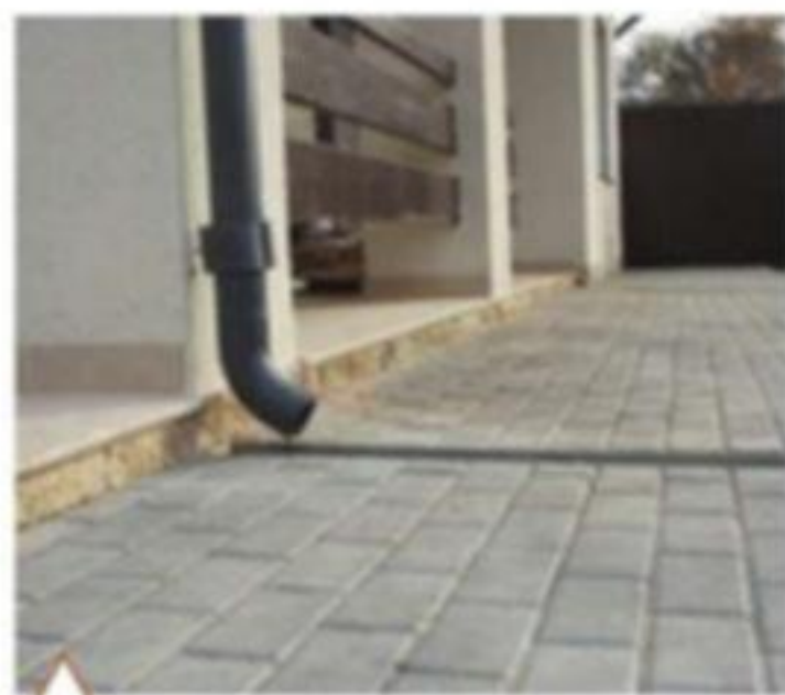
Отвод дождевой воды в водосборник дренажной системы
