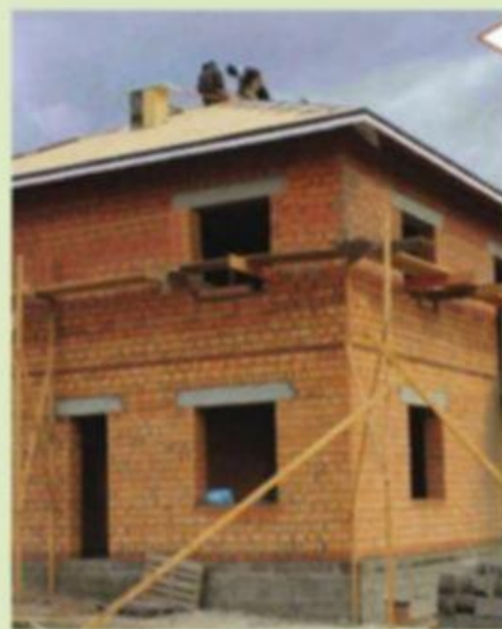
Укладка гибкой битумной черепицы по сплошному настилу из ОСП
