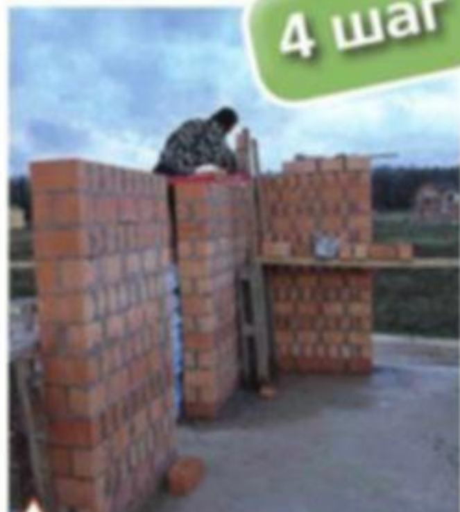
Возведение стен из керамических блоков
