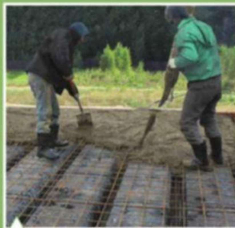
Бетонирование междуэтажного перекрытия
