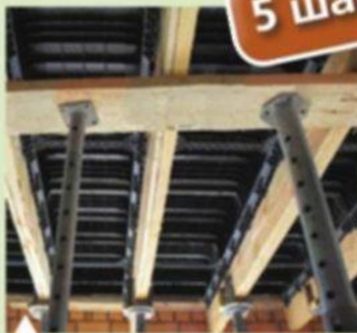
Собранная опалубка – вид изнутри
