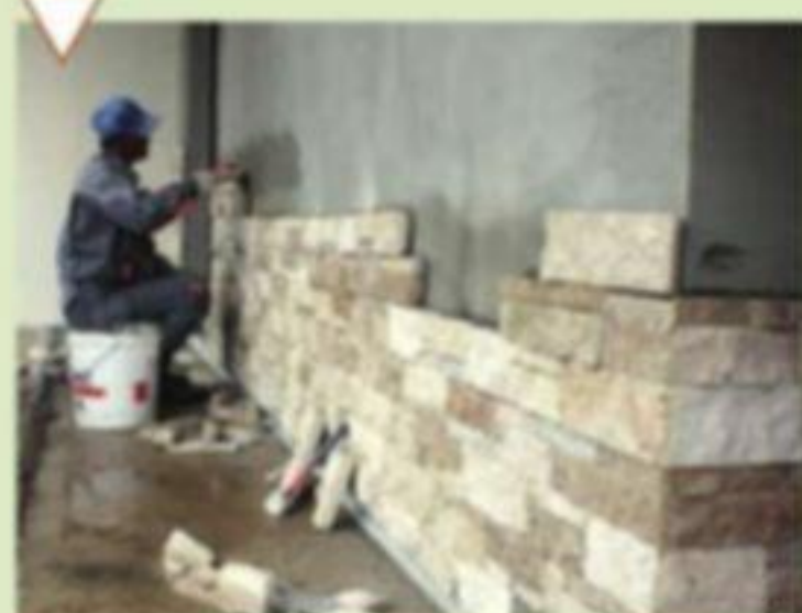
Облицовка оштукатуренного фасада искусственным камнем
