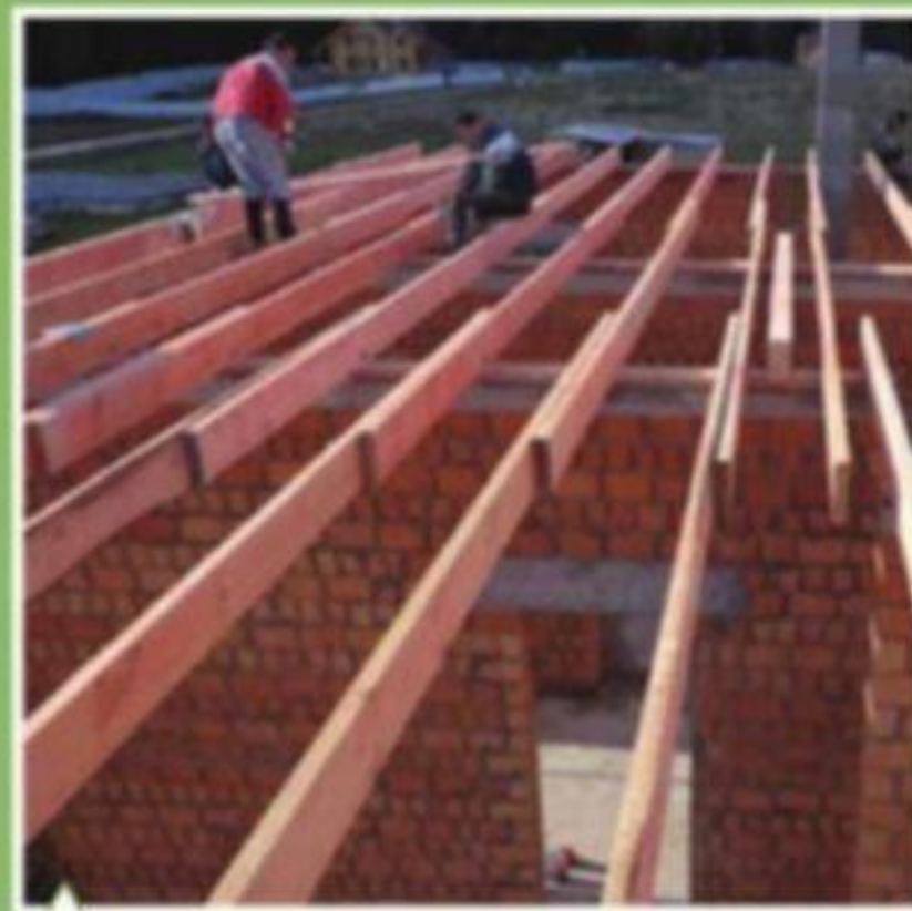
Возведение стропильной конструкции скатной крыши
