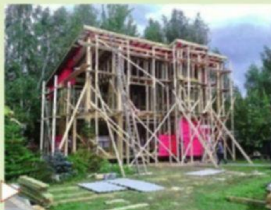
Каркас первого этажа с верхней обвязкой
