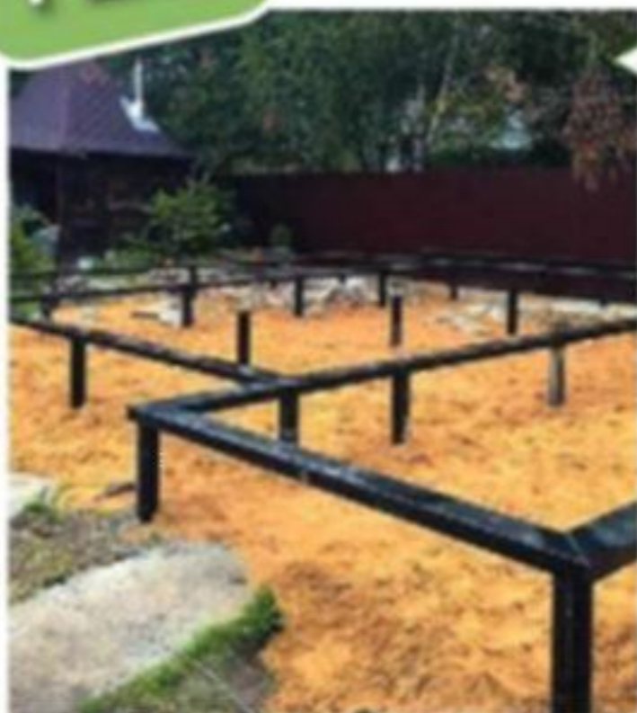
Фундамент из стальных винтовых свай
