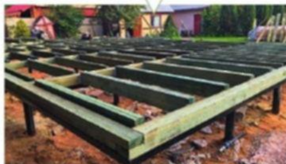
Фундамент из стальных винтовых свай
