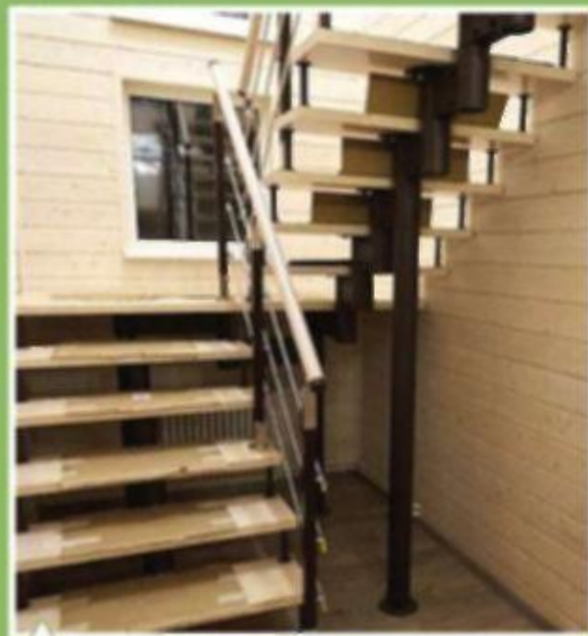
Лестница на центральном стальном косоуре
