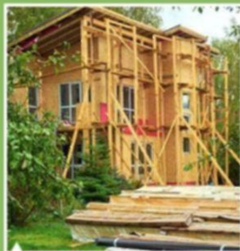
Наружная обшивка каркаса
