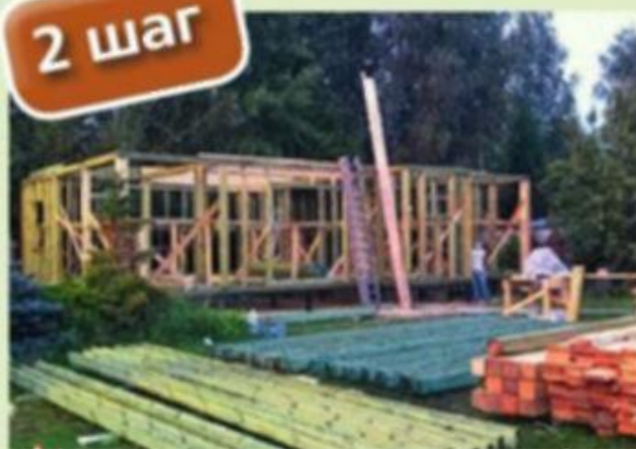
Каркас первого этажа с верхней обвязкой
