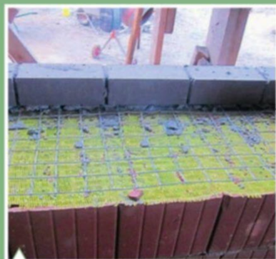
Полимерная сетка для кладочных швов
