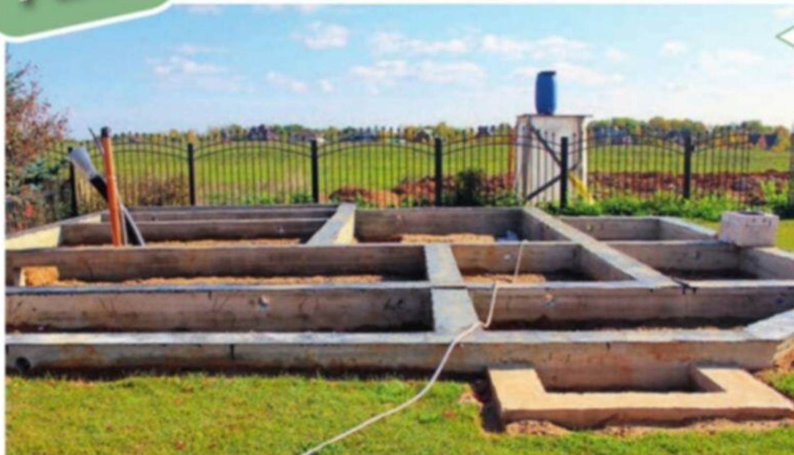
Монолитный ленточный фундамент
