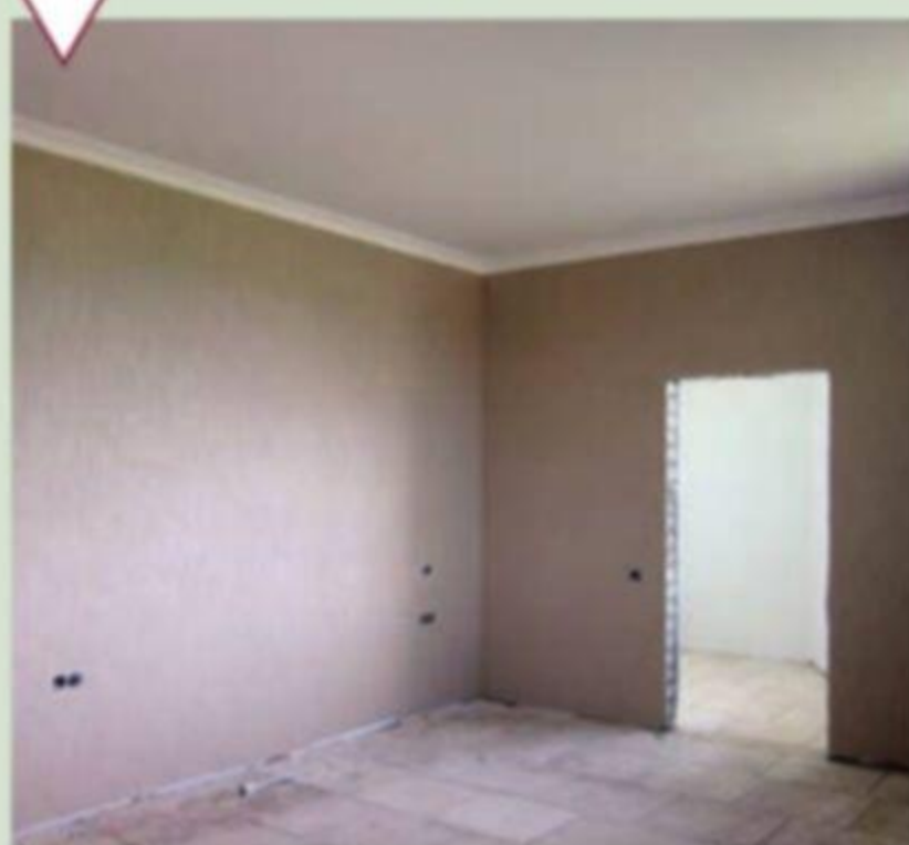
Чистовая отделка спальни
