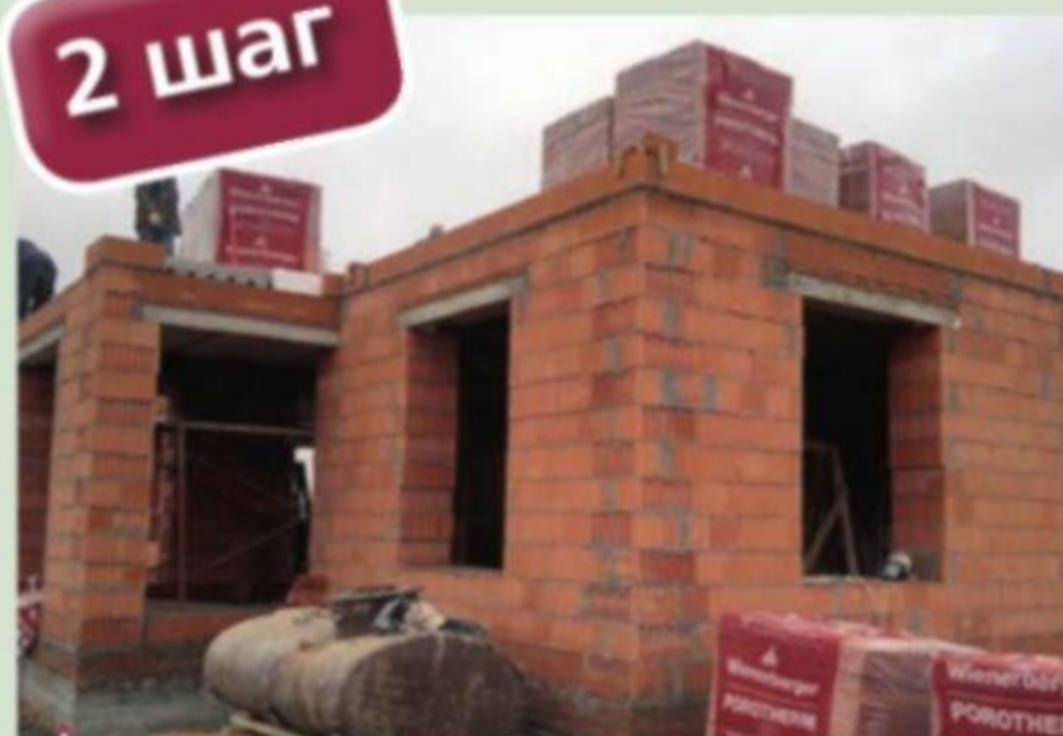
Возведение стен из керамических блоков
