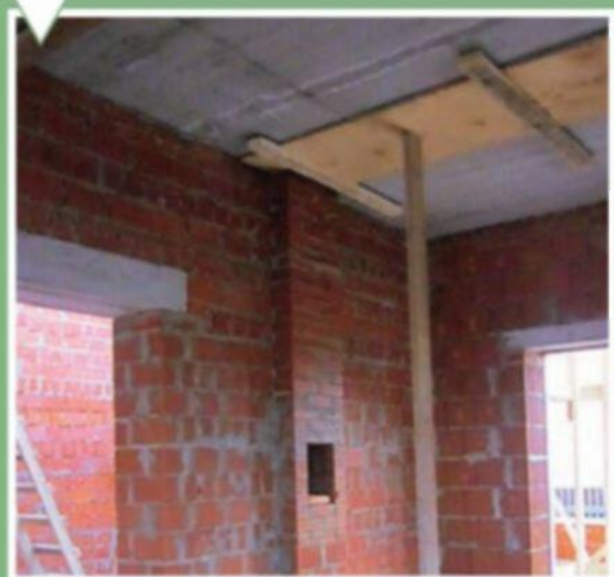
Сборное перекрытие с монолитными участками
