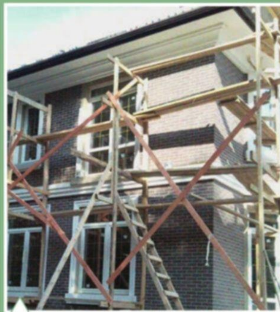
Отделка фасадов лицевым кирпичом и архитектурным бетоном
