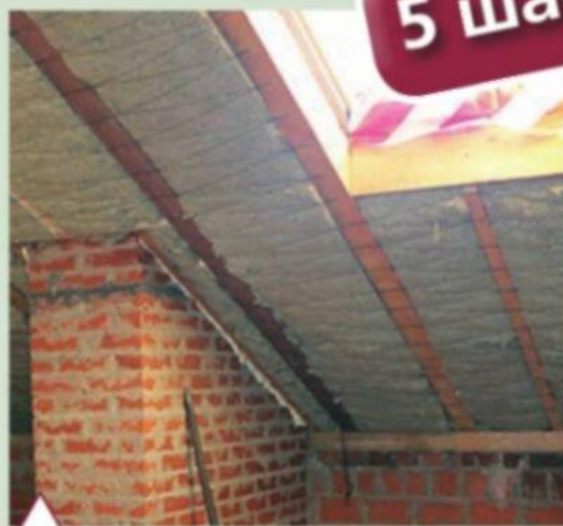
Кровельный пирог мансардной крыши
