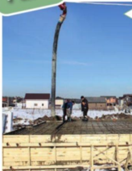
Бетонирование железобетонного фундамента
