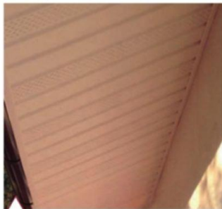
Подшивка карнизных свесов
