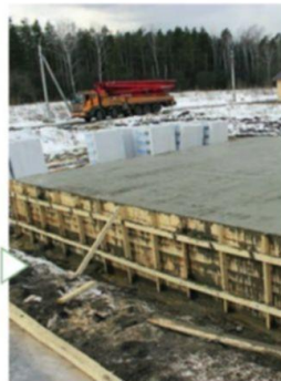
Твердение бетона. Складирование газобетонных блоков
