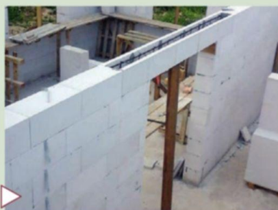
Первый ряд газобетонных блоков
