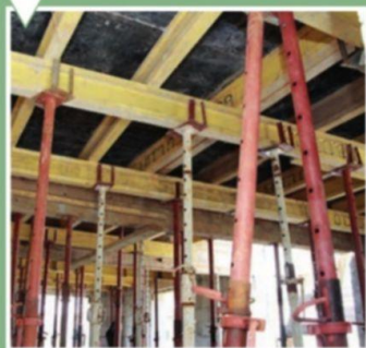
Монтаж инвентарной опалубки перекрытия
