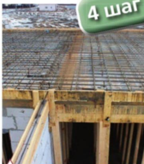
Армирование монолитного перекрытия
