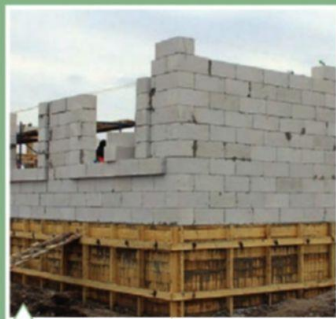
Возведение стен первого этажа
