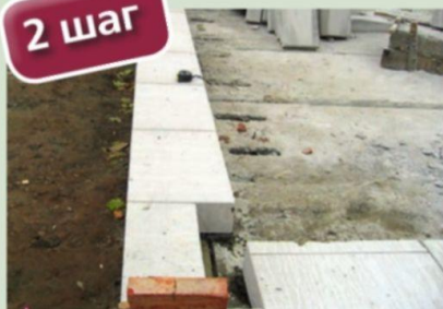
Первый ряд газобетонных блоков
