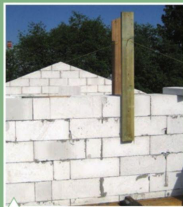
Подготовка к возведению стропильной крыши
