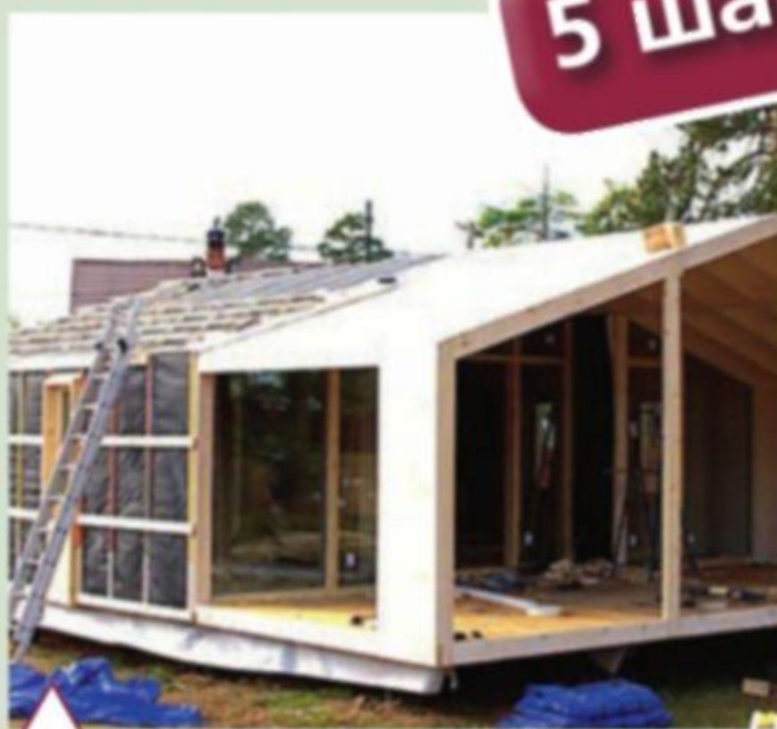
Монтаж гидроветрозащитной мембраны
