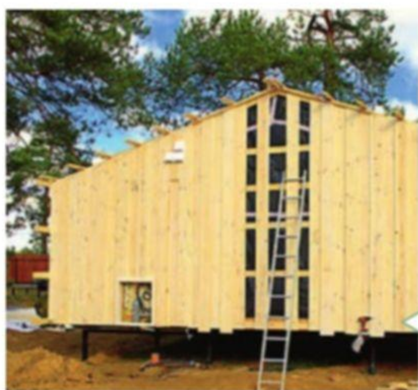
Установленные модули подготовлены к соединению в общее строение
