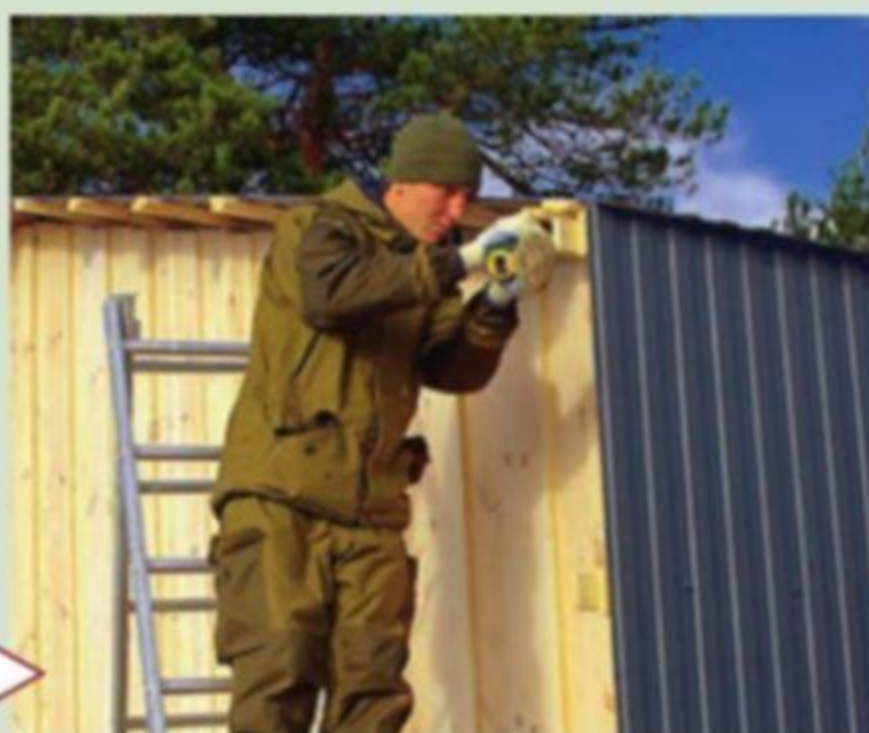
Монтаж гидроветрозащитной мембраны
