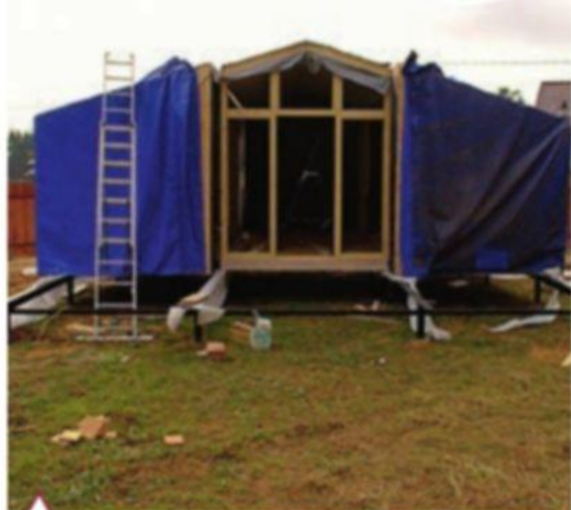
Установленные модули подготовлены к соединению в общее строение
