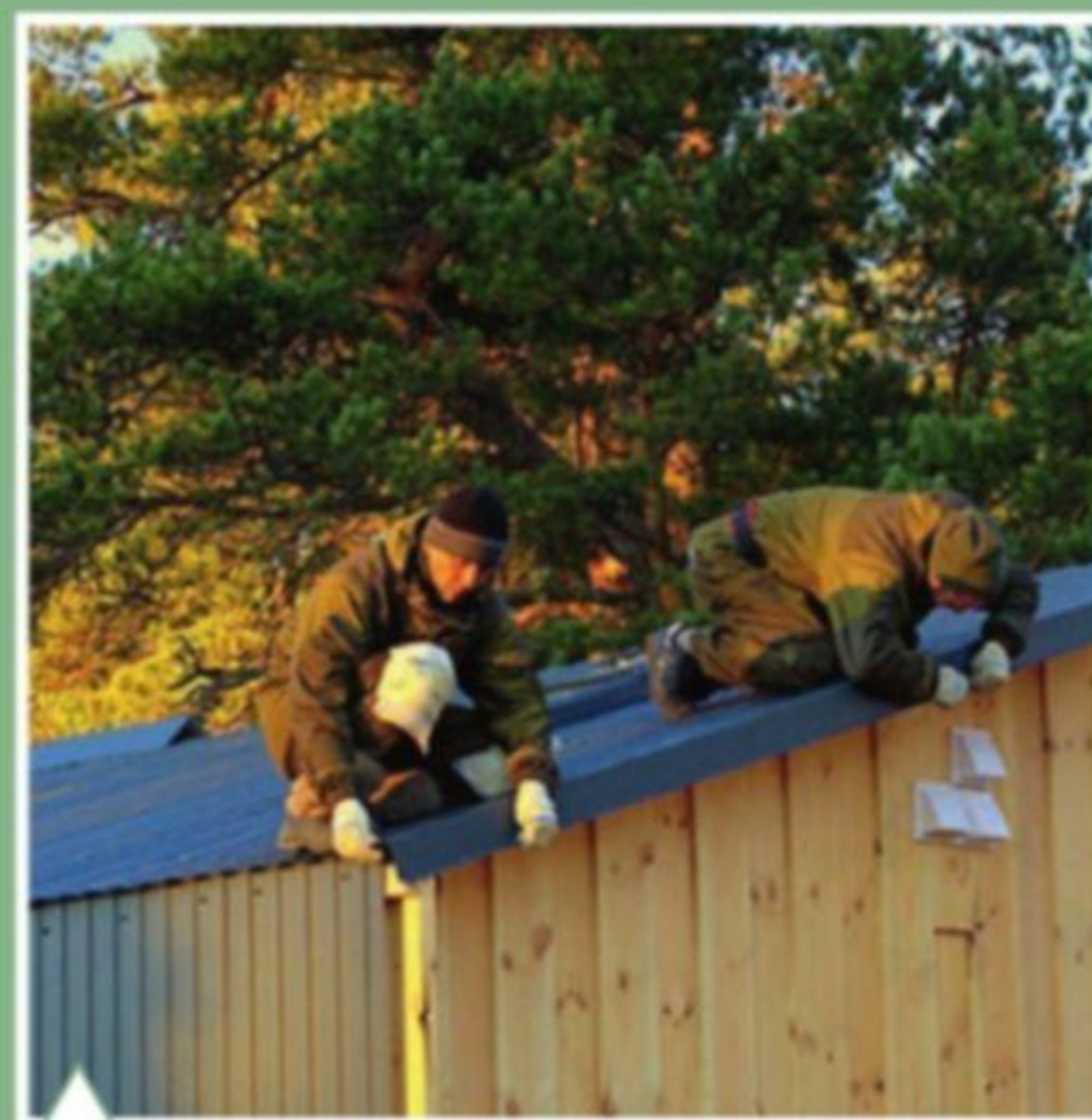
Монтаж фронтовой планки профилированной кровли
