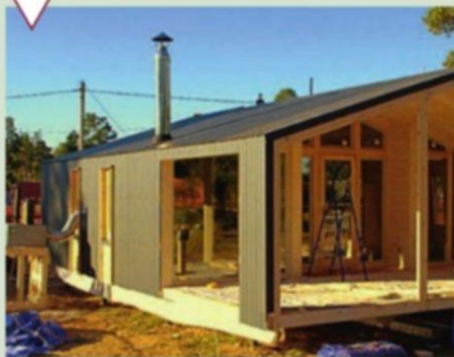
Монтаж дымохода для дровяного камин
