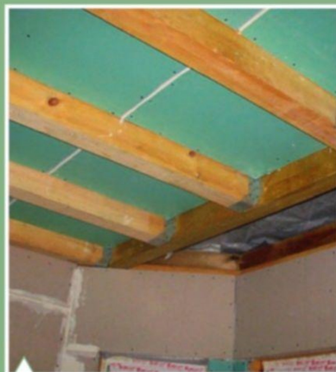
Черновая отделка мансарды
