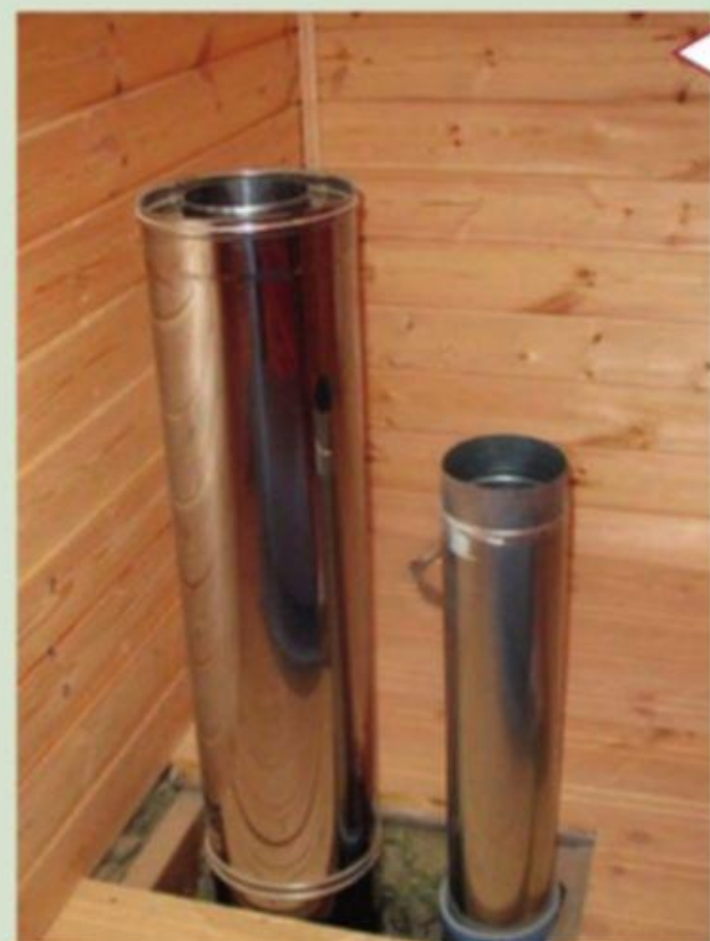
Устройство металлического дымохода для газового котла
