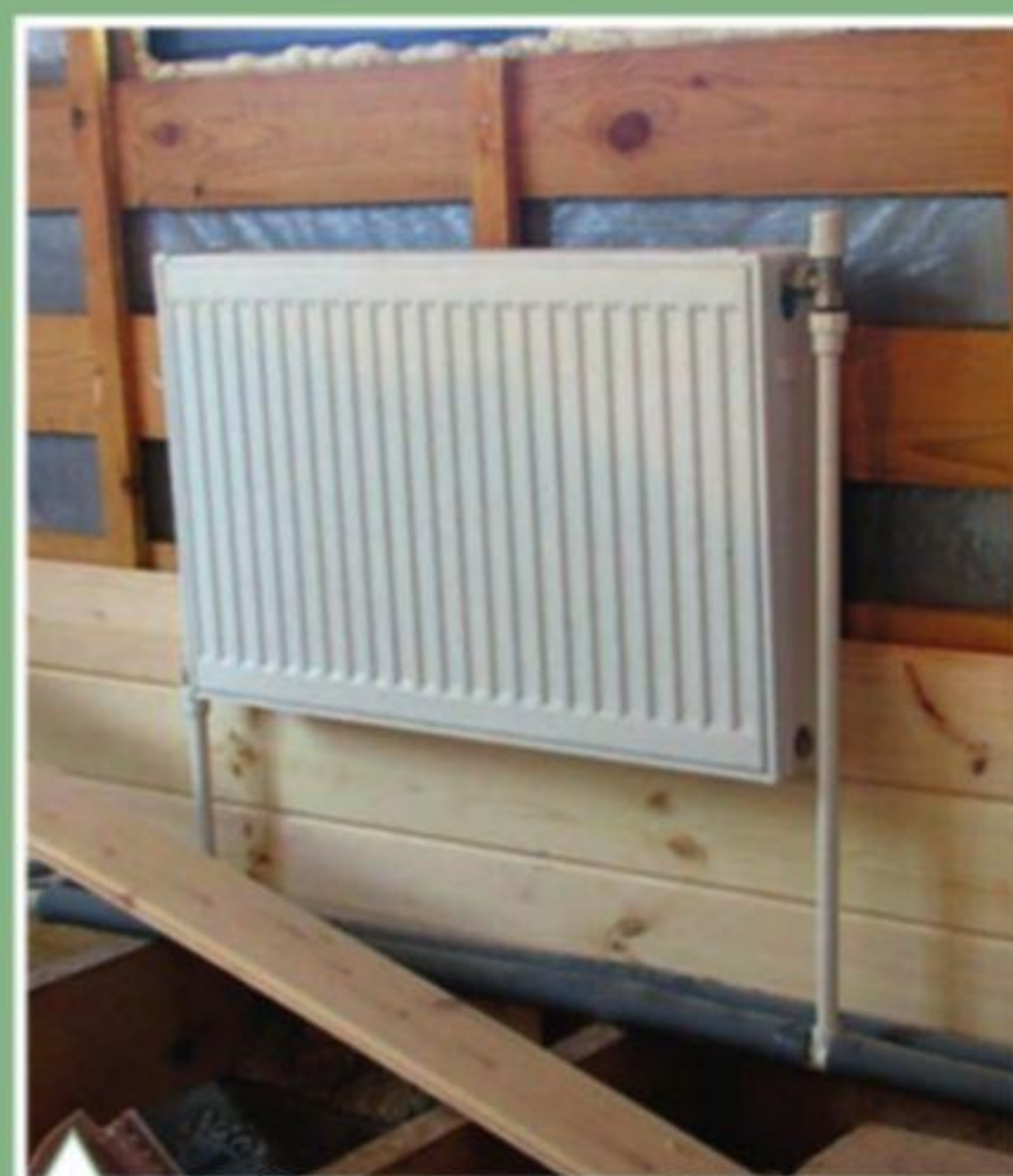
Внутренняя обшивка стен доской, имитирующей брус
