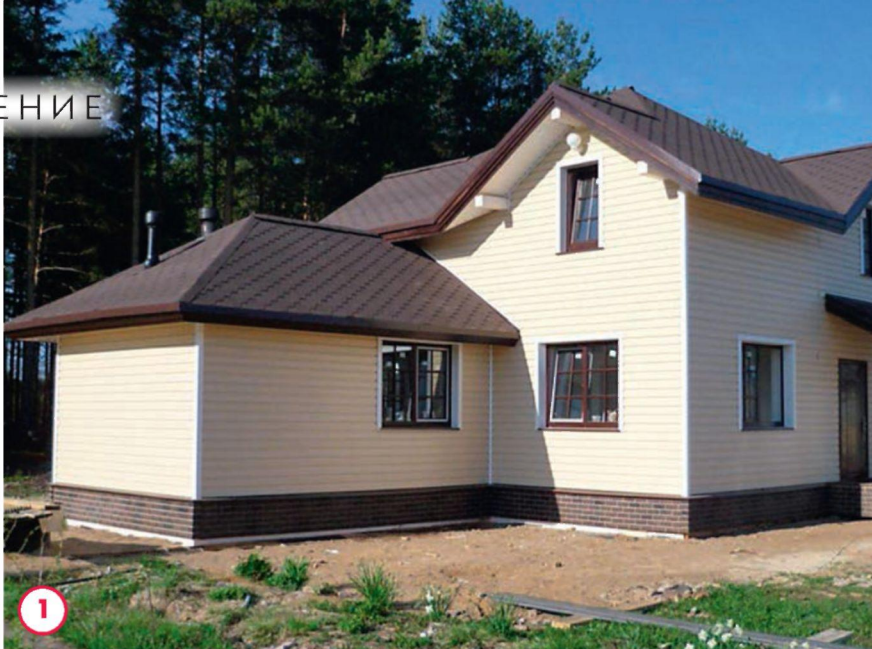
① Дом построен с использованием щепоцементных блоков Durisol ② Строительство дома по технологии Durisol
