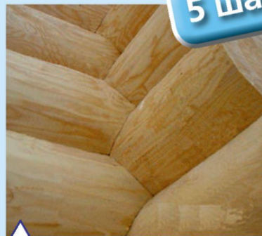
Вид углового замкового соединения
