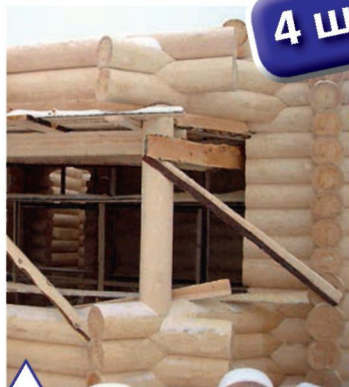
Сборка бревенчатого эркера
