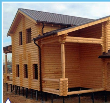
Завершена укладка металлочерепицы
