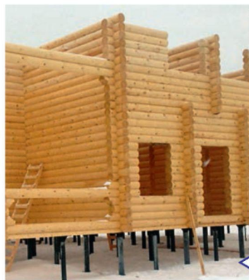
Сборка бревенчатого эркера
