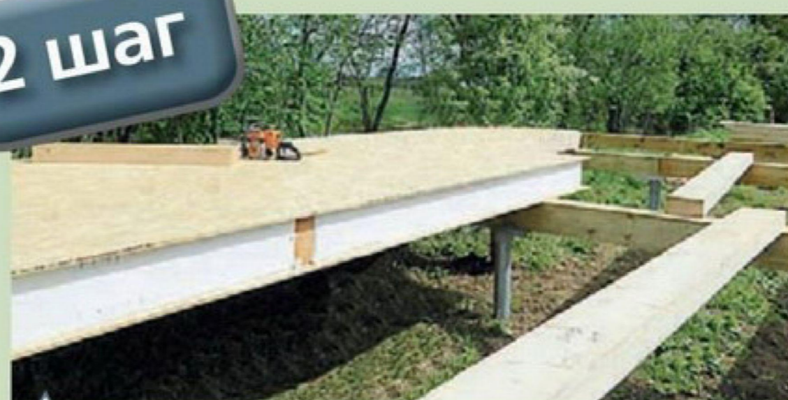
Монтаж СИП панелей нулевого перекрытия
