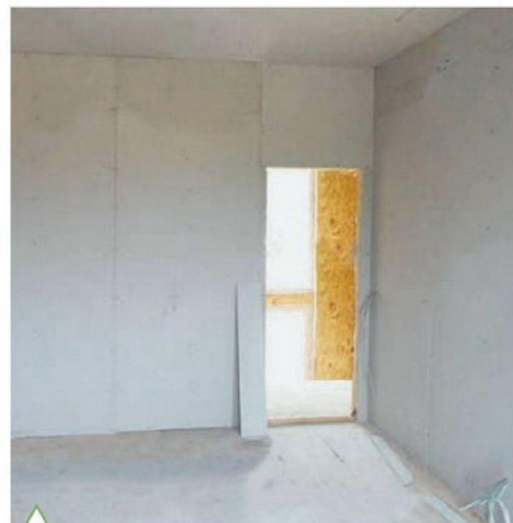
Обшивка стен гипсокартонными листами
