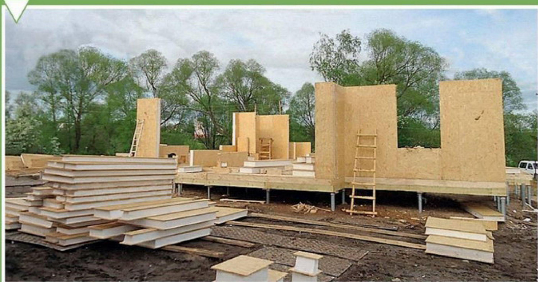
Сборка стен первого этажа
