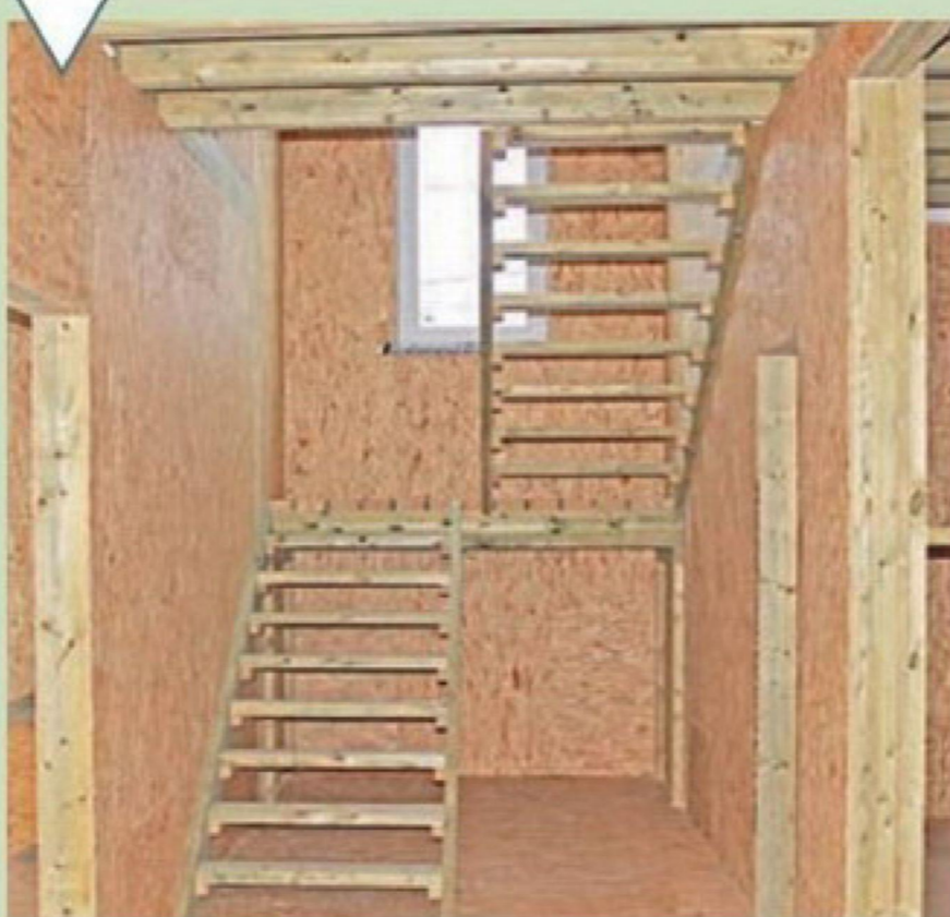
Монтаж деревянной лестницы
