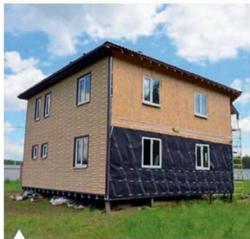
Монтаж гидроветрозащитной мембраны
