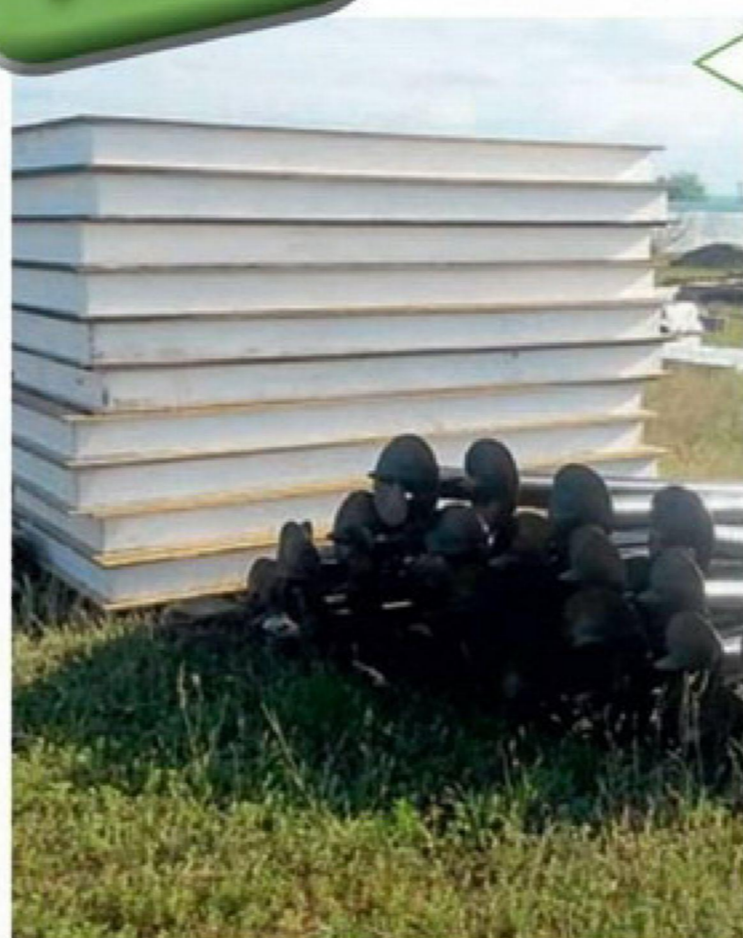
Складирование винтовых свай и СИП панелей
