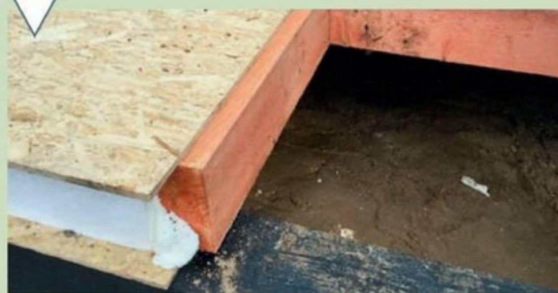
Обшивка торцов антисептированными досками
