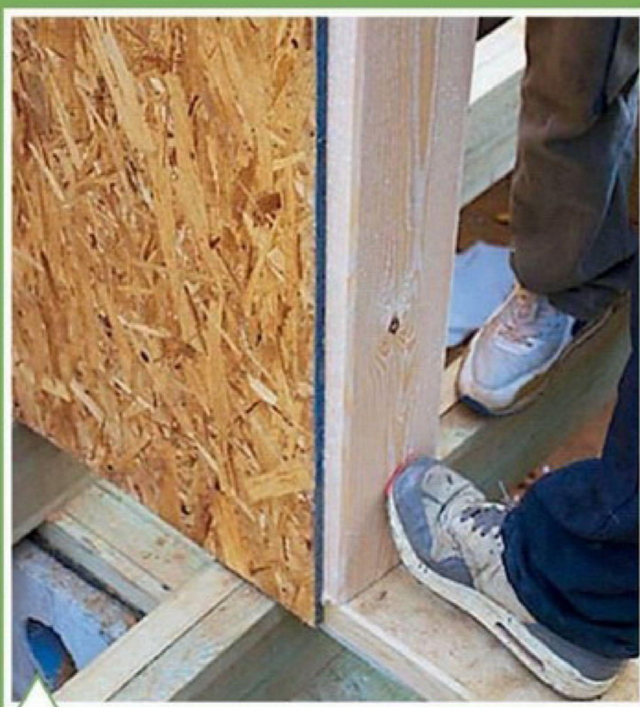
Крепление торцевых досок
