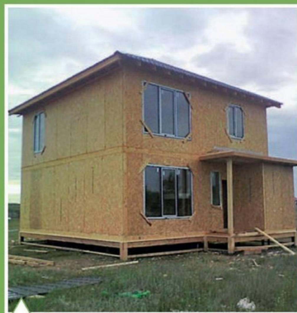
Монтаж окон из ПВХ профиля
