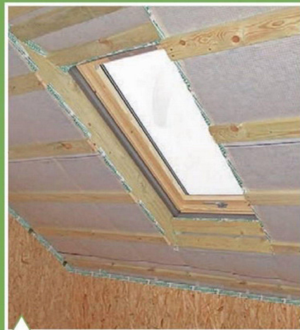
Обустройство мансардного окна
