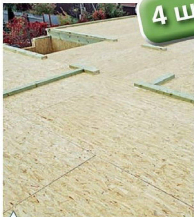
Крепление опорных досок под стены второго этажа
