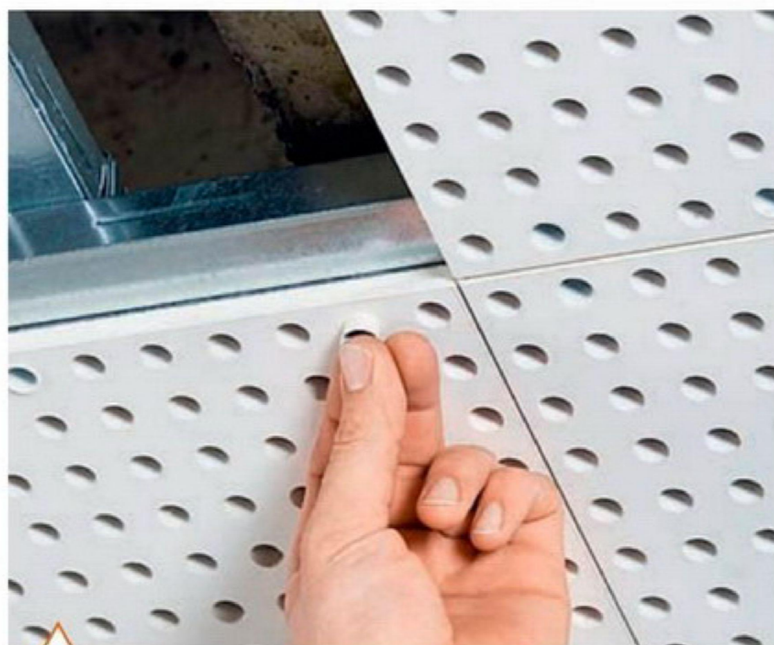
Монтаж акустического потолка Кнауф
