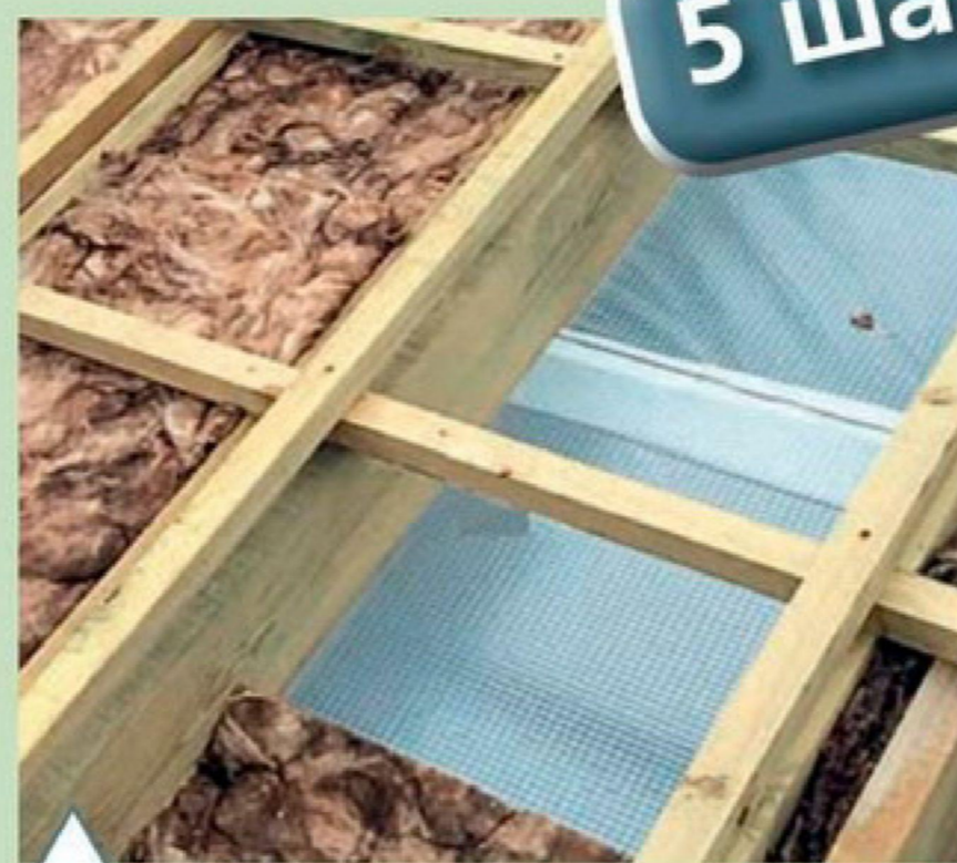
Монтаж подкровельной теплоизоляции
