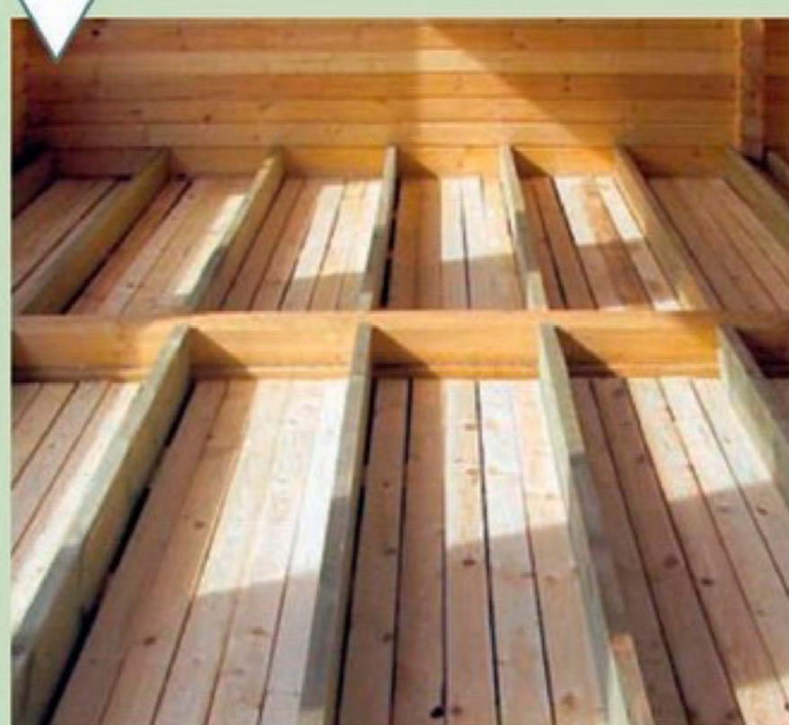
Устройство деревянного междуэтажного перекрытия
