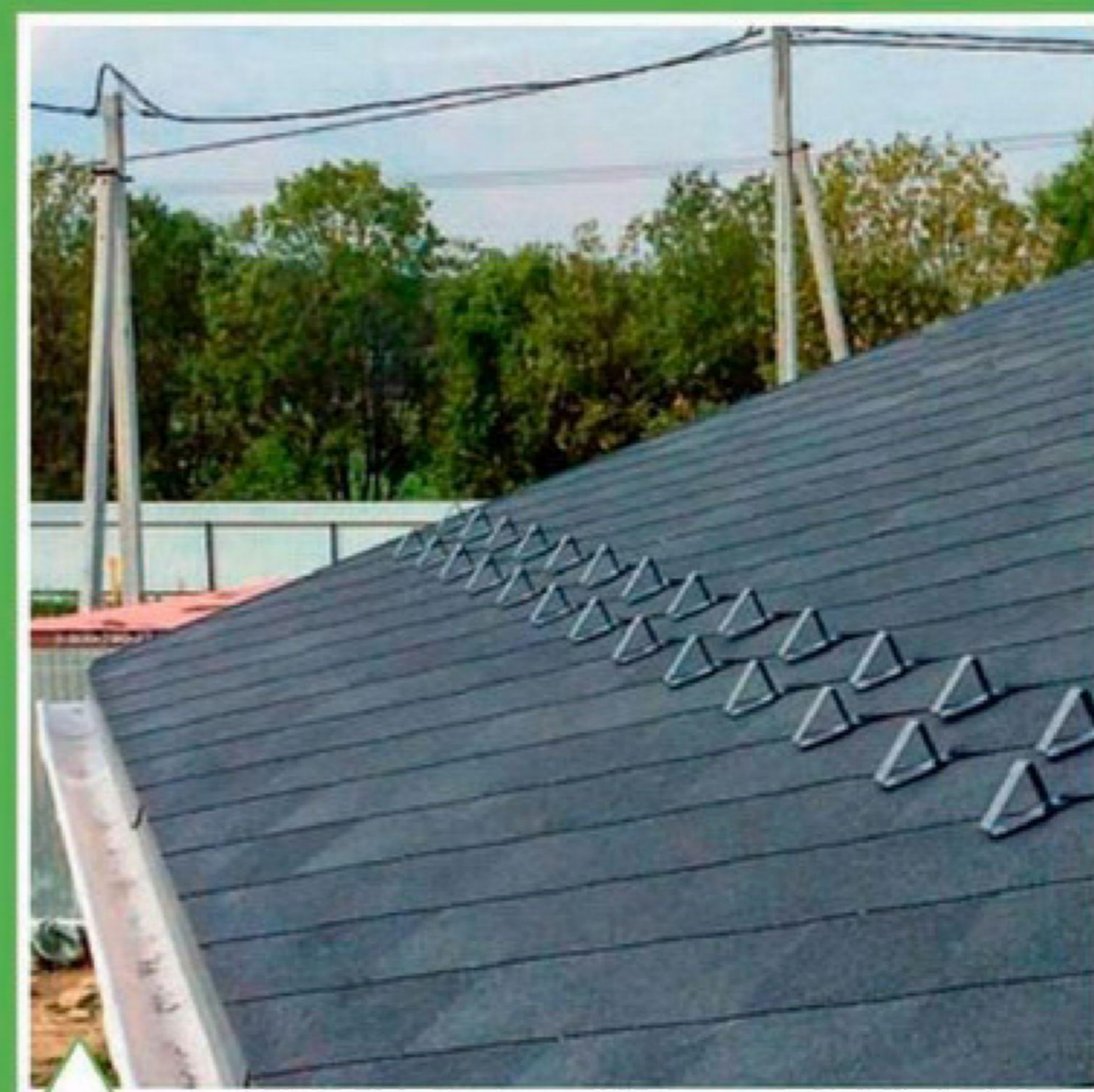
Кровельное покрытие из битумной черепицы
