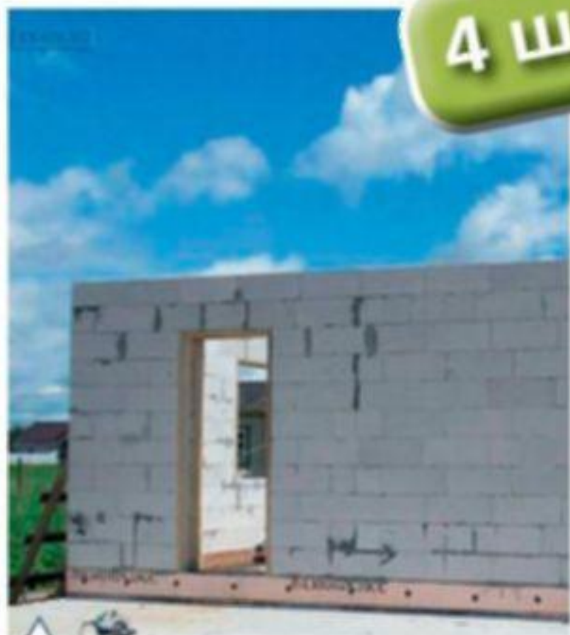
Стены первого этажа подвели под перекрытие
