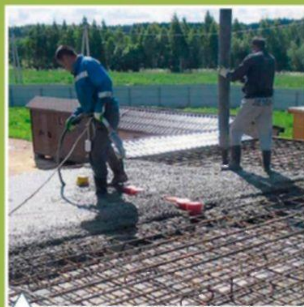
Бетонирование перекрытия стен первого этажа
