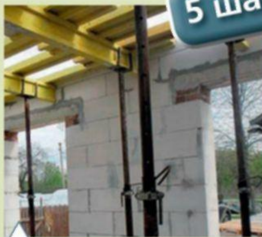
Монтаж инвентарной опалубки
