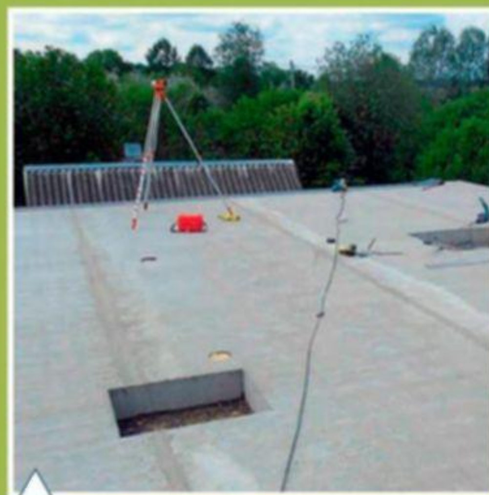
Подготовка готового перекрытия к возведению мансардного этажа
