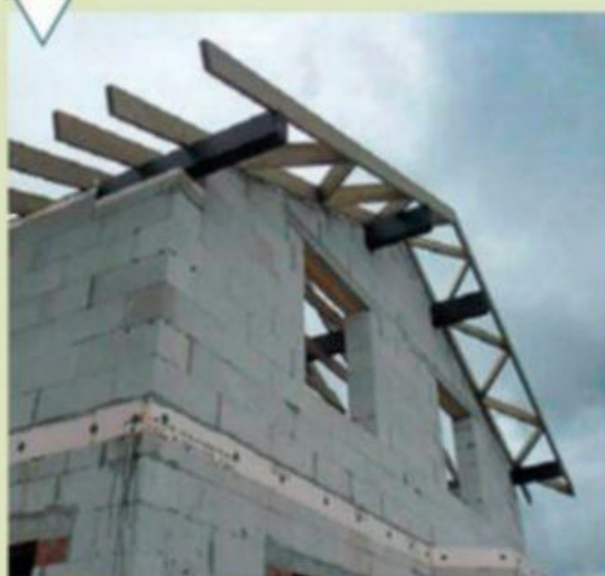
Возведение стропильной конструкции
