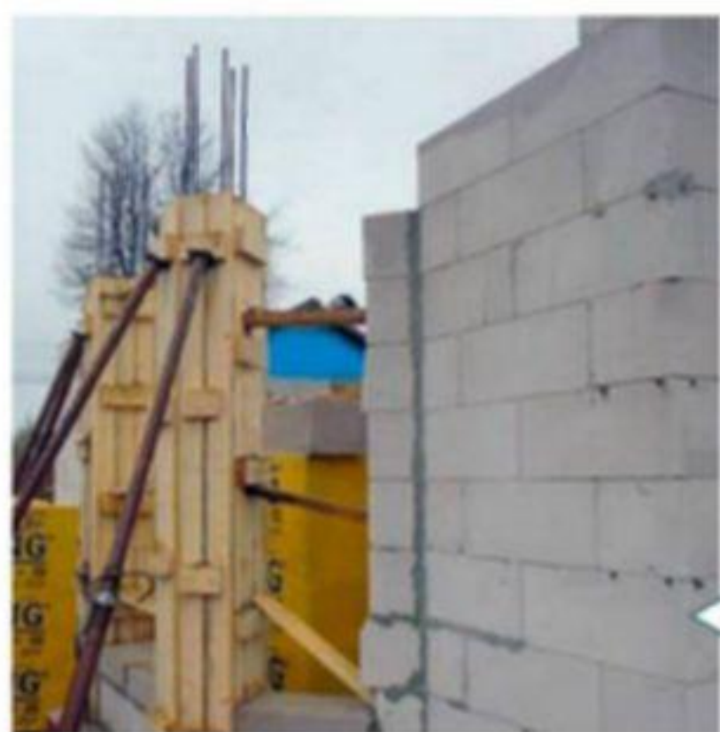
Стены первого этажа подвели под перекрытие
