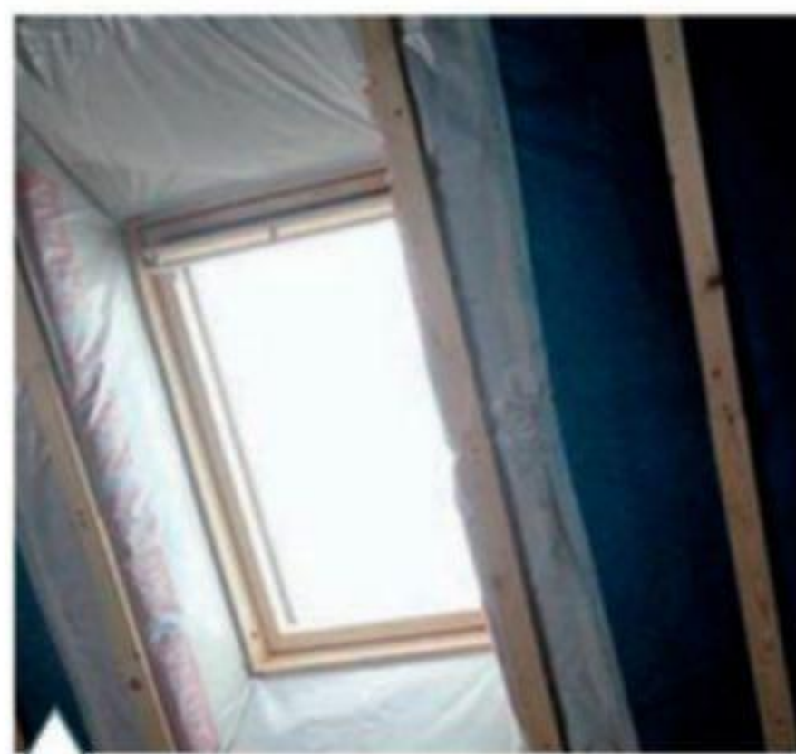
Пароизоляция утеплителя с внутренней стороны
