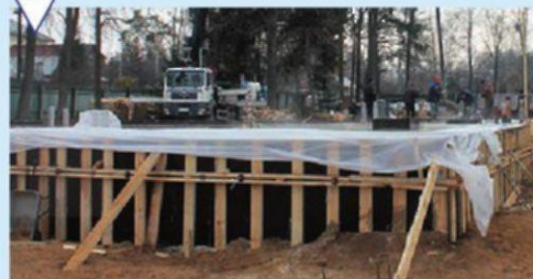
Бетонирование плиты (заливка бетонного раствора бетононасосом)
