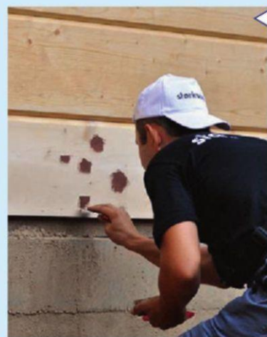
Нанесение натуральной шпаклевки
