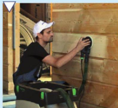
Финишная шлифовка стен
