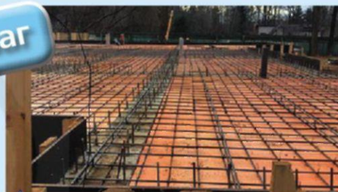
Укладка утеплителя и монтаж арматурного каркаса монолитной железобетонной плиты
