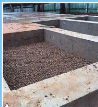
Вид фундамента после снятия опалубки
