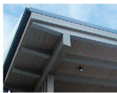
Вид подшивки карнизных свесов стропильной крыши
