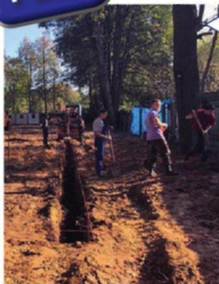
Разработка траншей по разметке
