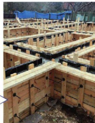
Заливка бетонного раствора в опалубку стен фундамента
