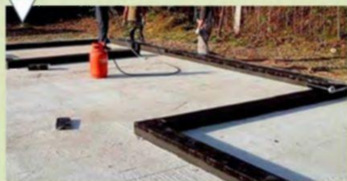
Направление рулонной битумной гидроизоляции на ленты под стены сруба
