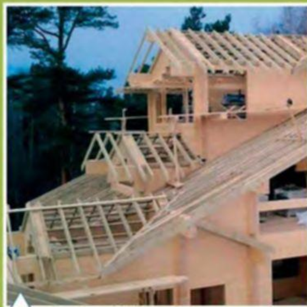
Сооружение стропильной конструкции скатной крыши
