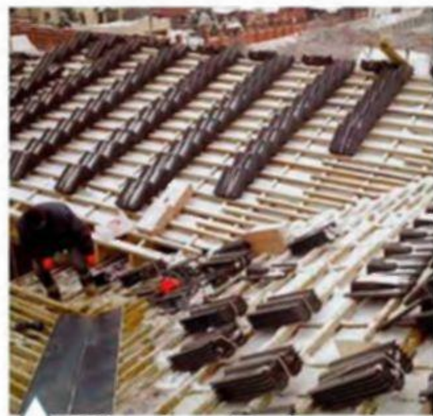
На стропилах разложена цементно-песчаная черепица
