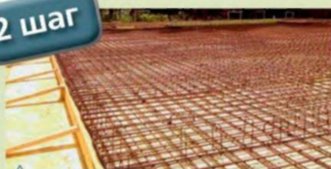
Арматурный каркас железобетонной плиты перекрытия
