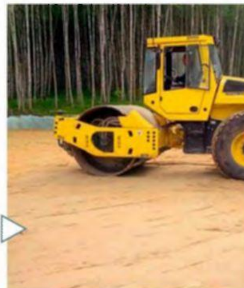
Уплотнение песчаного основания фундамента
