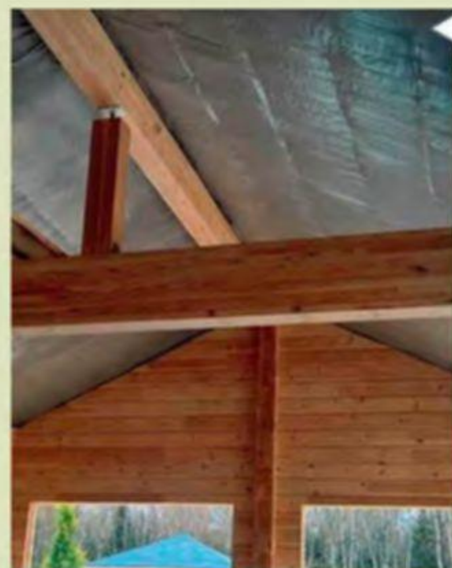
Поверх утеплителя натянута пароизоляция
