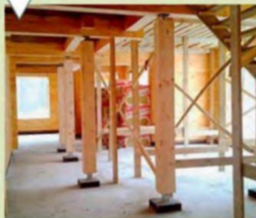
Стойки под крупномерными балками из клееного бруса
