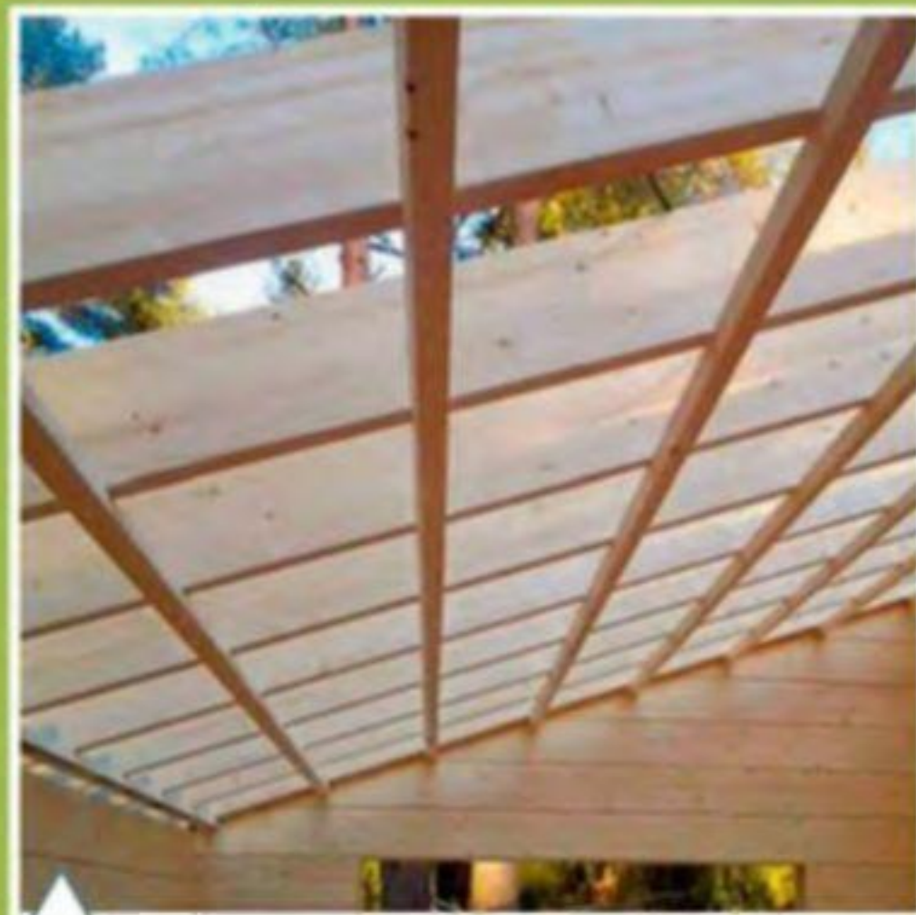
Вид стропил перед монтажом кровельного пирога
