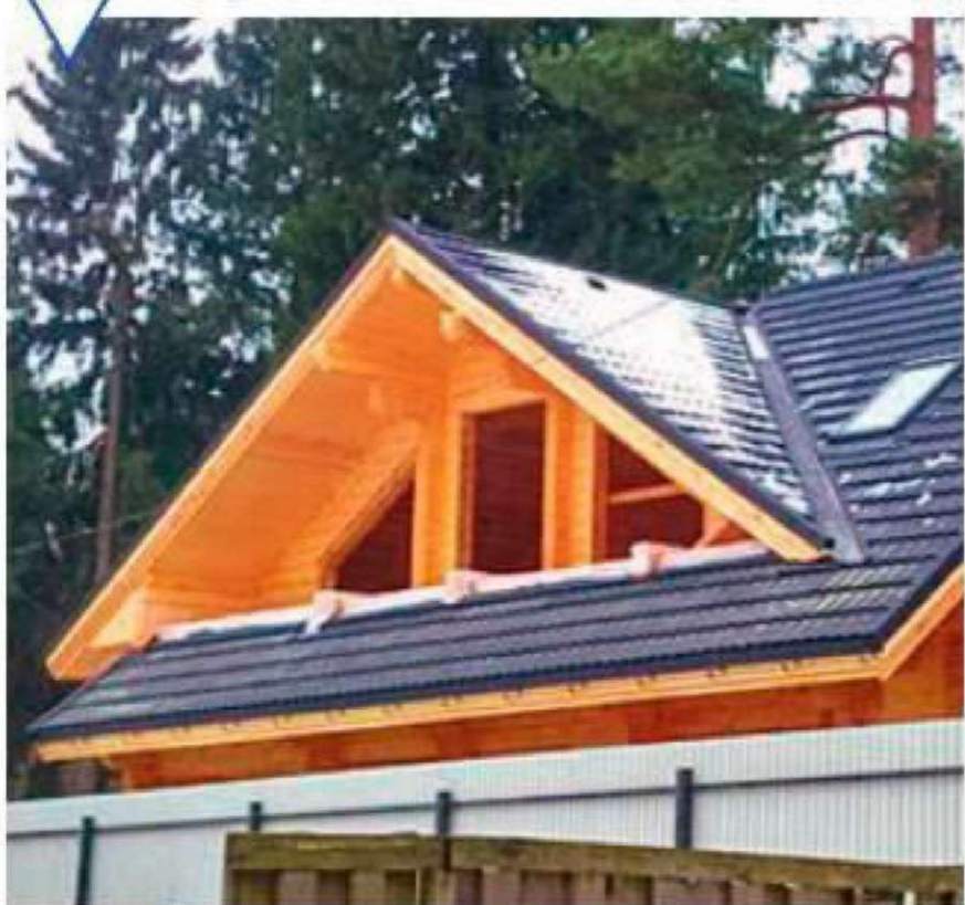
Монтаж кровли завершен
