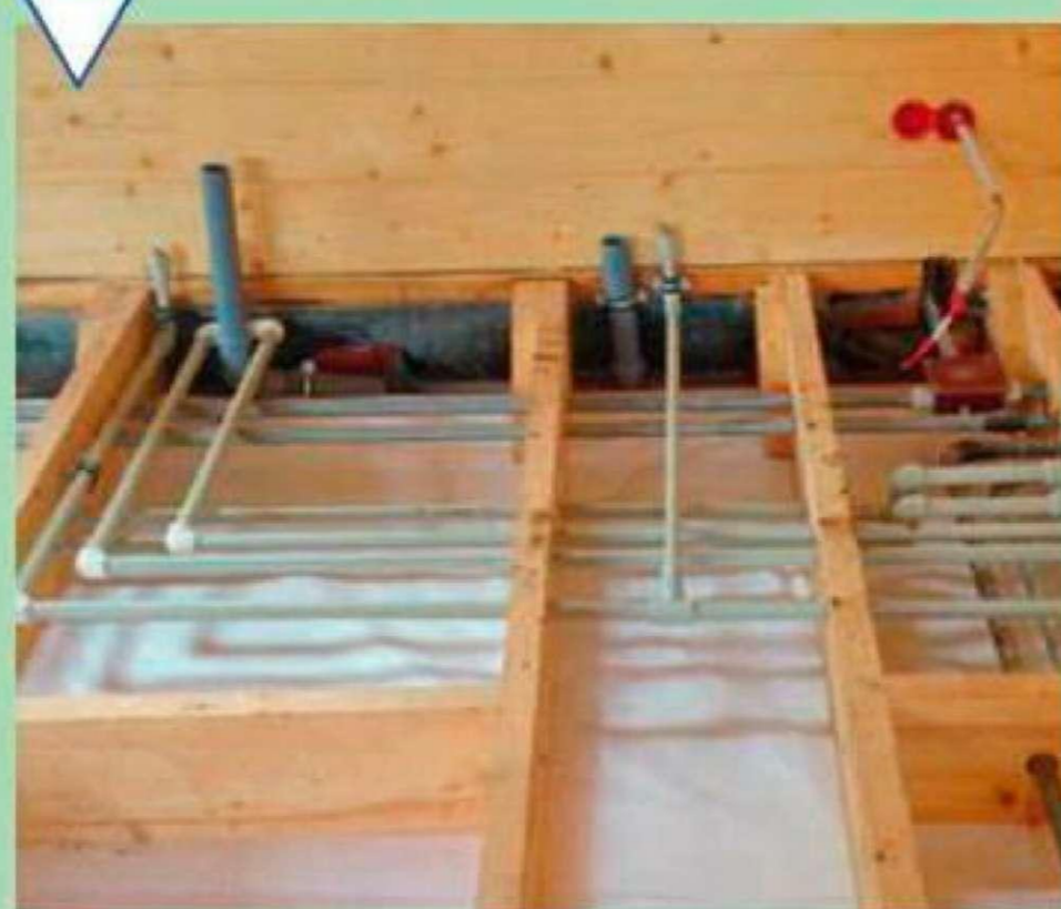
Прокладка коммуникаций в структуре балочного перекрытия
