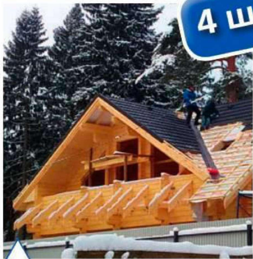
Укладка натуральной черепицы
