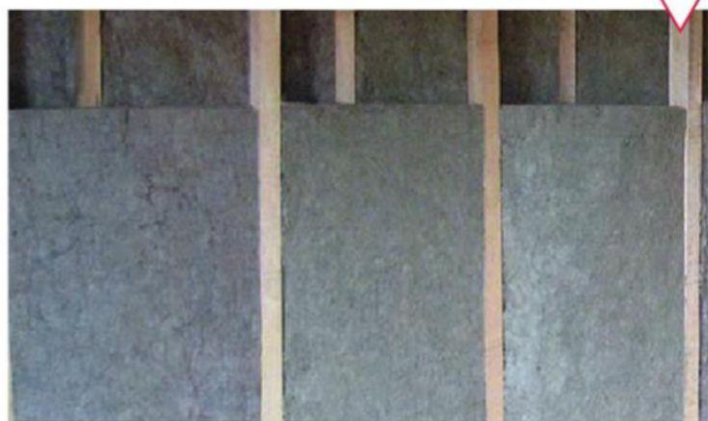
Закладка утеплителя в двойной каркас (ф. «Наносфера»)
