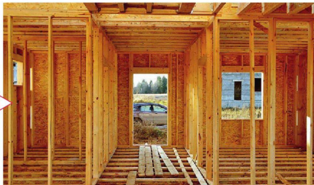
Обшивка каркасных стен плитами ОСП (ф. Intercity)
