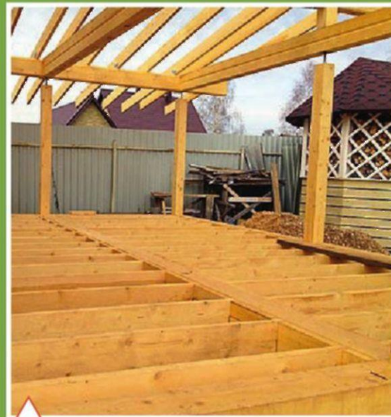
Устройство балочной основы под дощатый настил террасы
