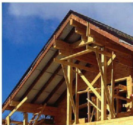
Корытчатый брус стропильной конструкции скатной крыши
