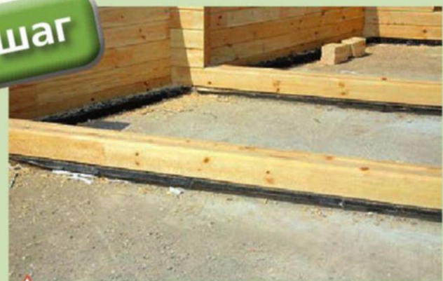
Горизонтальная гидроизоляция по обрезу фундамента
