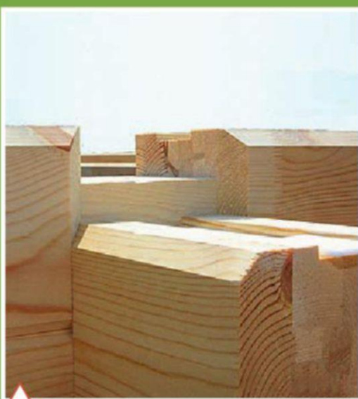
Профилированный клееный брус в структуре несущих стен
