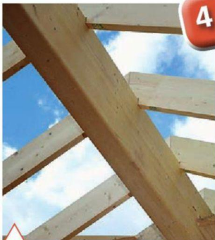
Корытчатый брус стропильной конструкции скатной крыши
