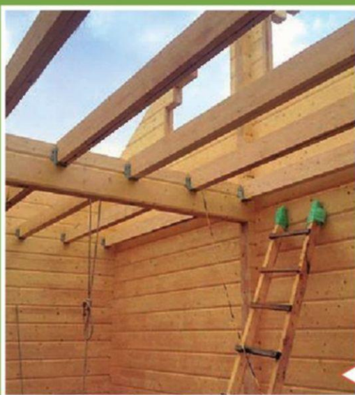
Профилированный клееный брус в структуре несущих стен
