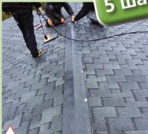
Укладка коньковых плиток битумной черепицы
