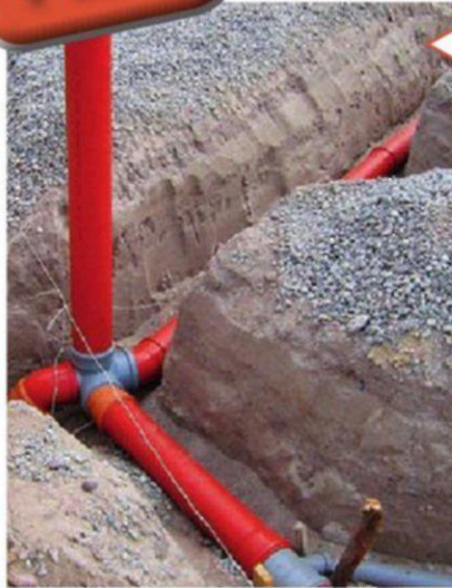
Прокладка наружных инженерных коммуникаций
