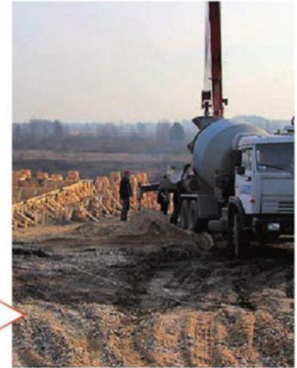
Бетонирование монолитного фундамента
