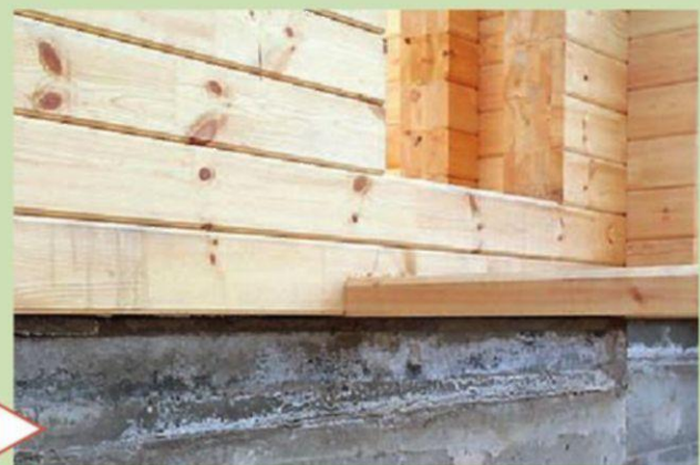
Горизонтальная гидроизоляция по обрезу фундамента
