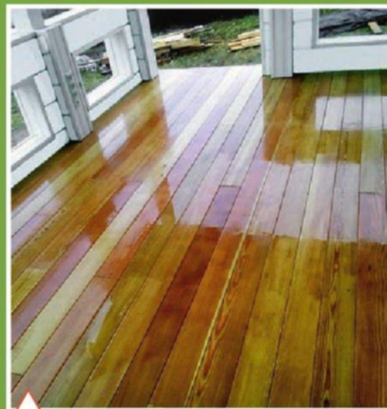
Террасный настил после нанесения яхтенного лака
