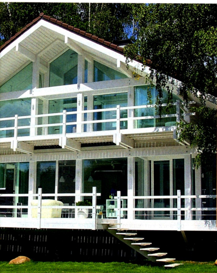
Прозрачные стеклопакеты с магнетронным покрытием StopRay NEO без рамы и переплетов устанавливаются между стоек фахверка (ф. Osko-Haus)
