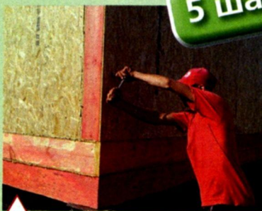
Углы первого этажа стягивают глухарями
