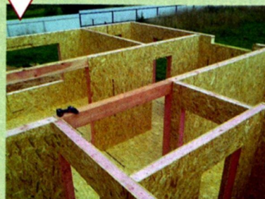
Приступают к устройству обвязки стен первого этажа
