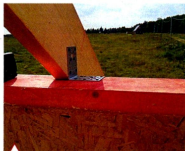
Крепление стропил к мауэрлату стальными оцинкованными уголками
