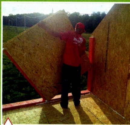
Монтаж первых стеновых панелей мансарды
