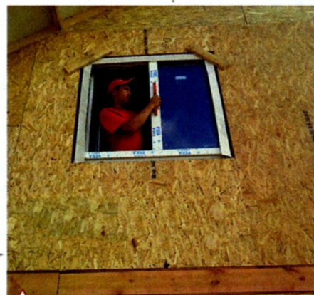
Монтаж энергосберегающих оконных блоков из системного ПВХ профиля
