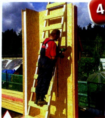
Монтаж начальных, угловых, панелей стен первого этажа
