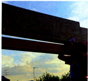
Монтаж начальных, угловых, панелей стен первого этажа
