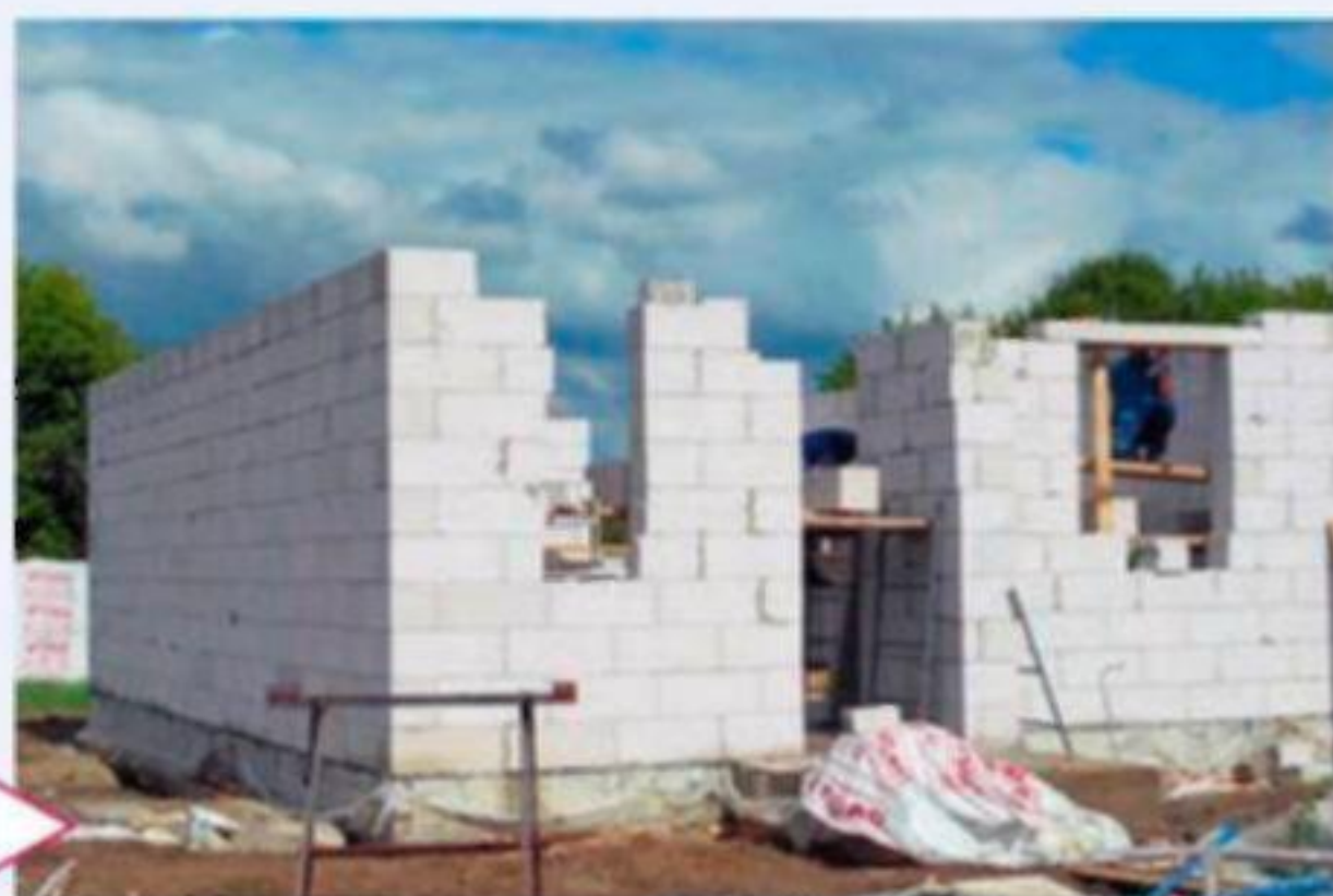
Возведение стен первого этажа
