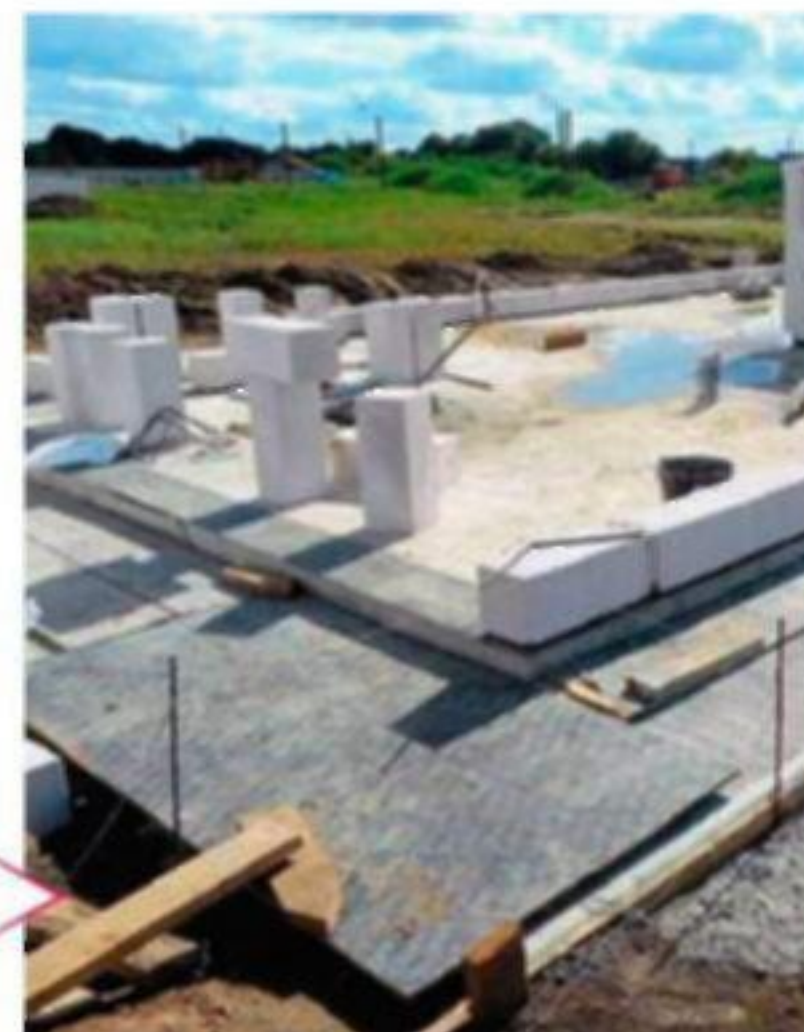
Плитный мелкозаглубленный фундамент
