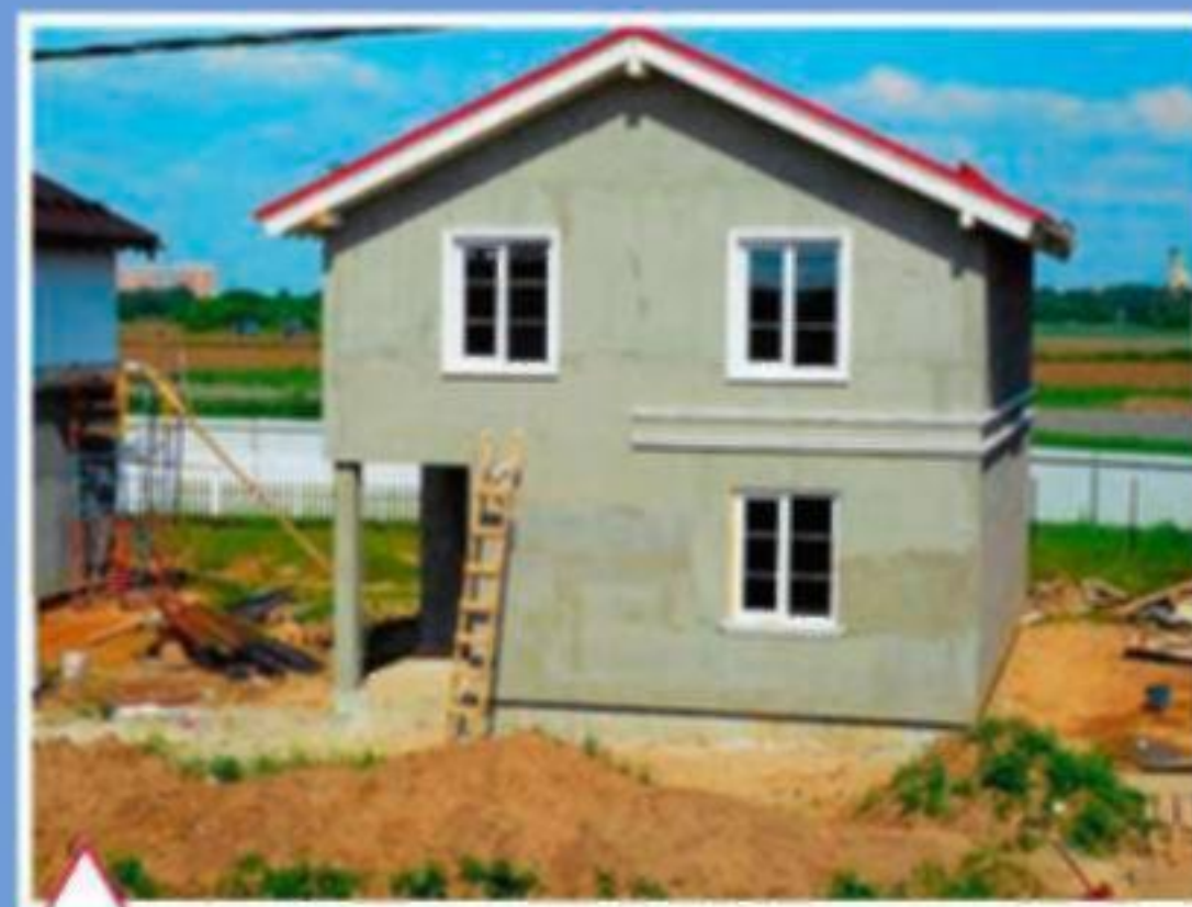
Монтаж лепных элементов
