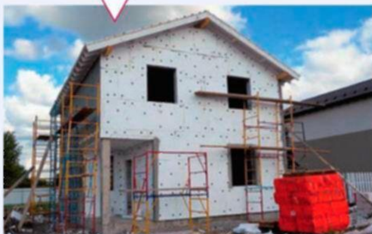
Облицовка стен плитами из пенопласта
