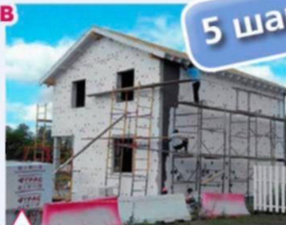
Оштукатуривание стен по полимерной сетке
