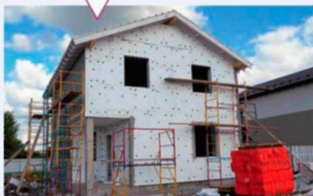
Облицовка стен плитами из пенопласта
