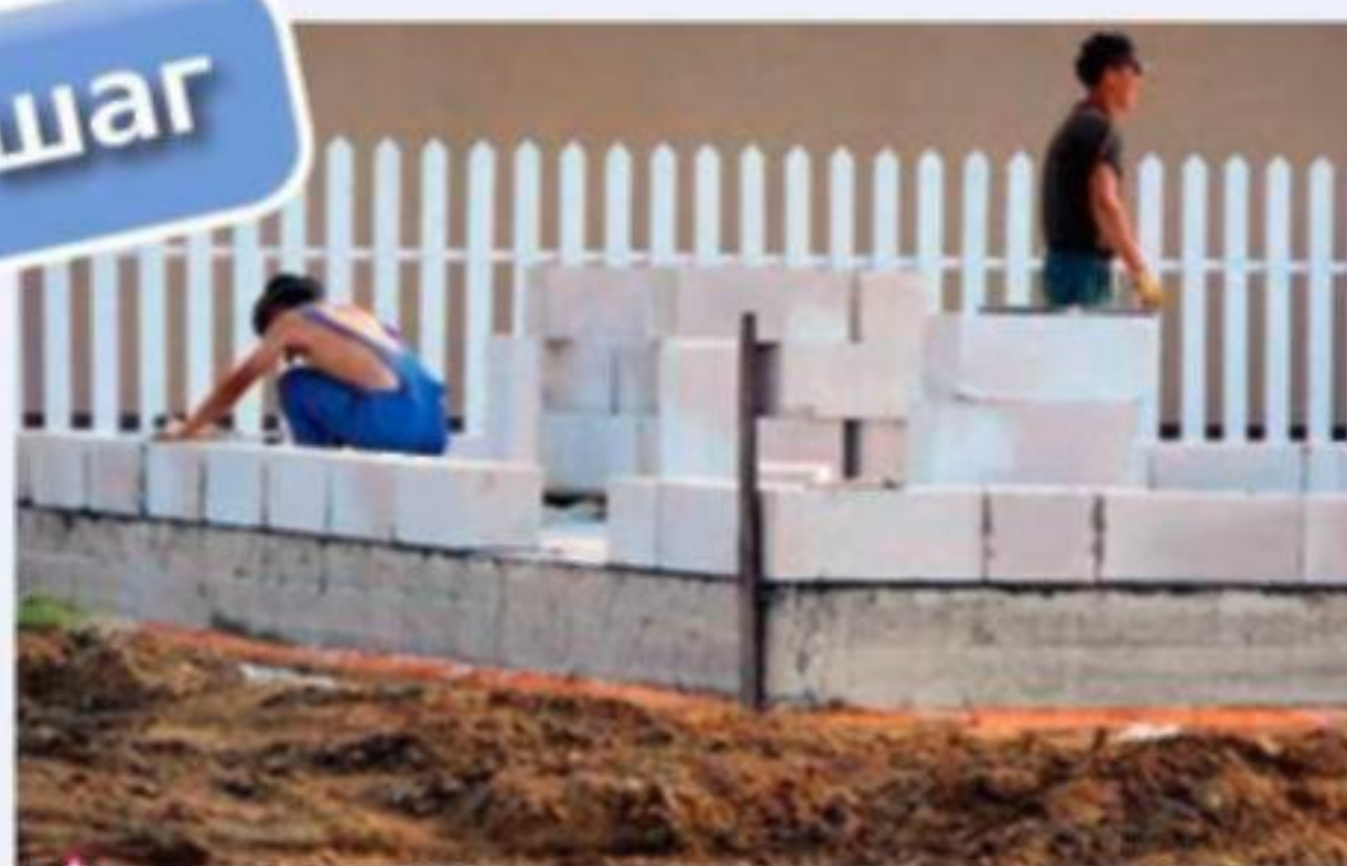
Укладка первого ряда газобетонных блоков
