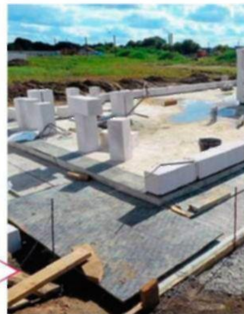
Плитный мелкозаглубленный фундамент
