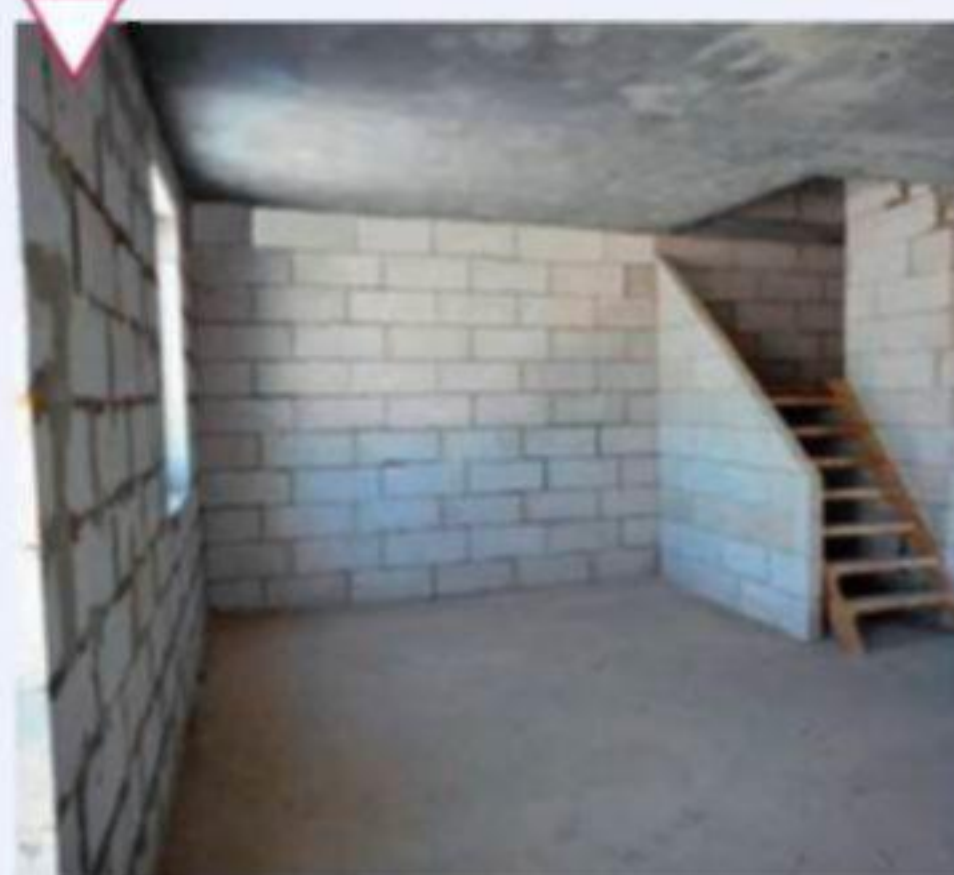
Установка пластиковых окон и утепление перекрытия второго этажа
