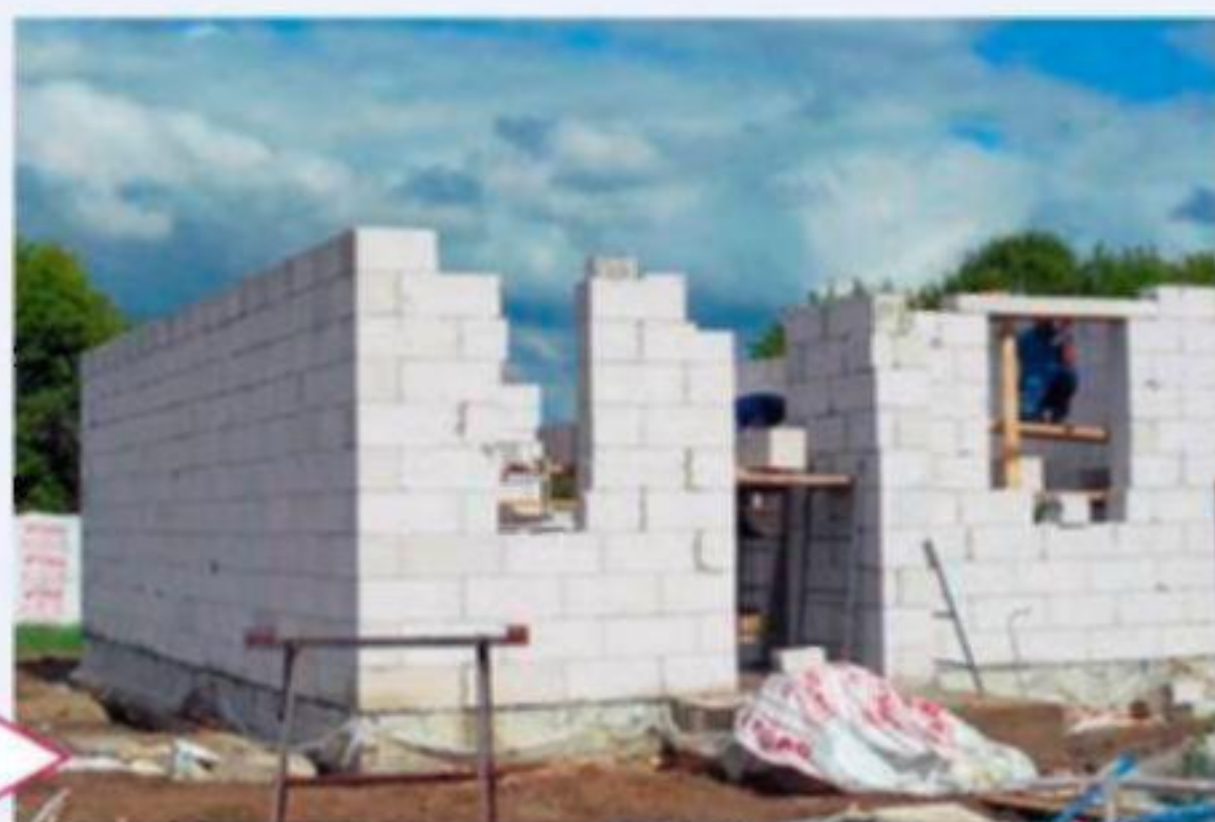
Возведение стен первого этажа
