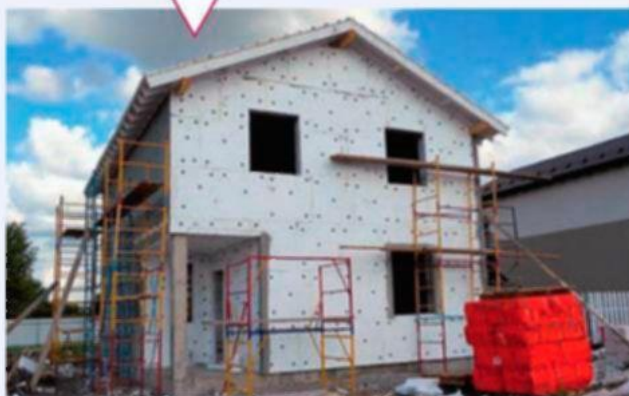
Облицовка стен плитами из пенопласта
