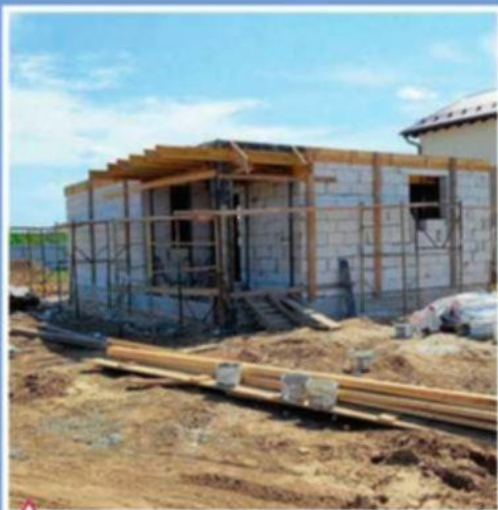
Устройство монолитного объединяющего пояса
