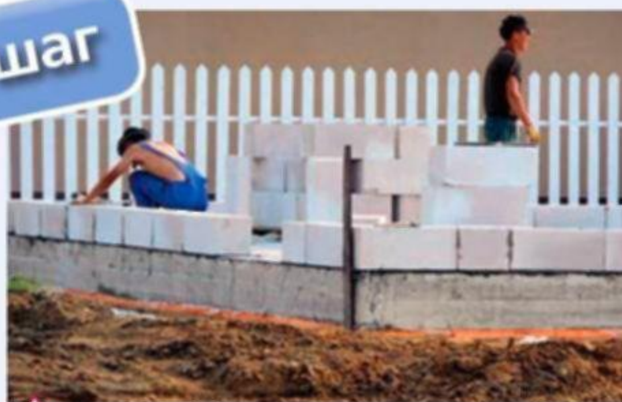
Укладка первого ряда газобетонных блоков
