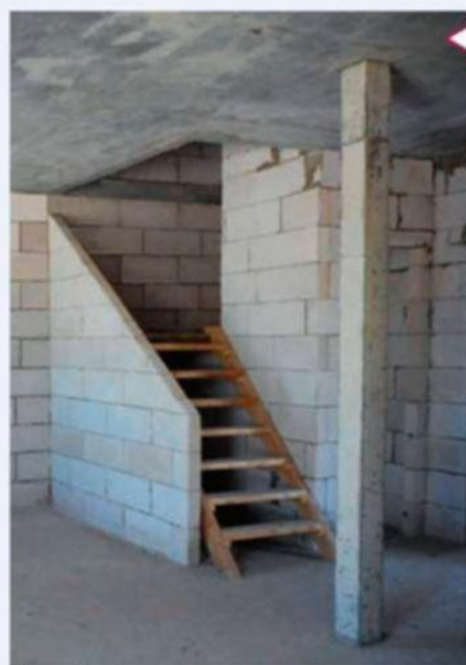
Блочное ограждение лестничного марша
