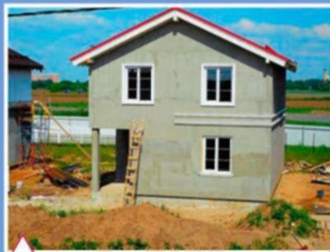
Монтаж лепных элементов
