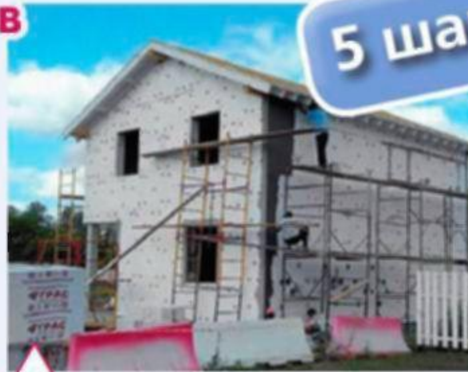
Оштукатуривание стен по полимерной сетке
