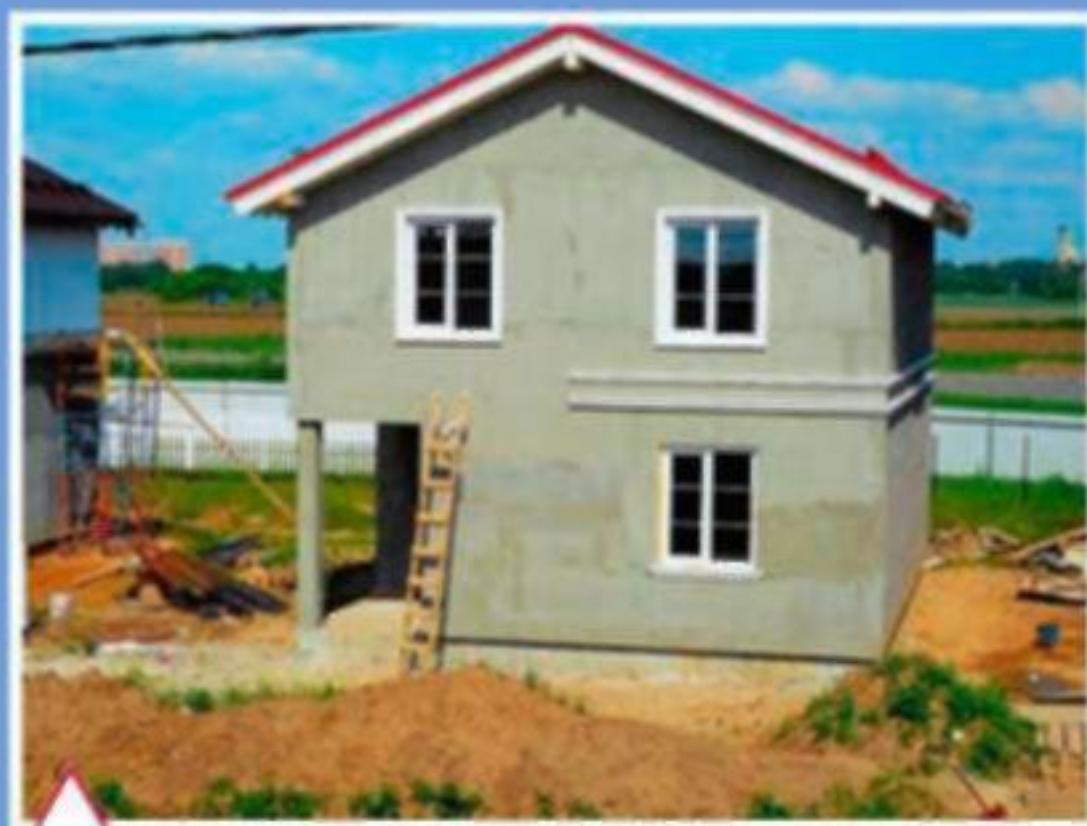
Монтаж лепных элементов
