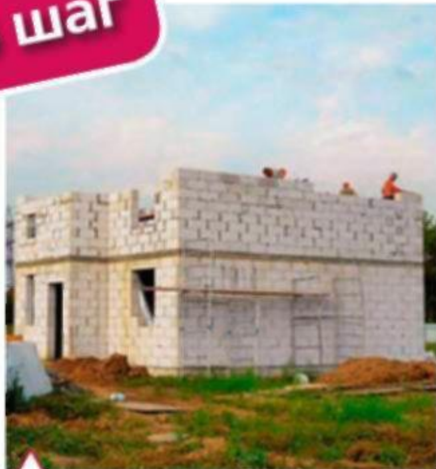
Возведение стен второго этажа
