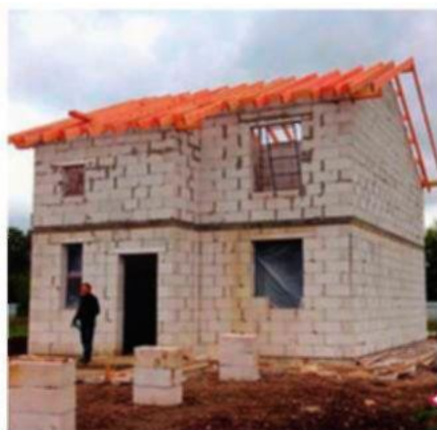
Возведение стен второго этажа
