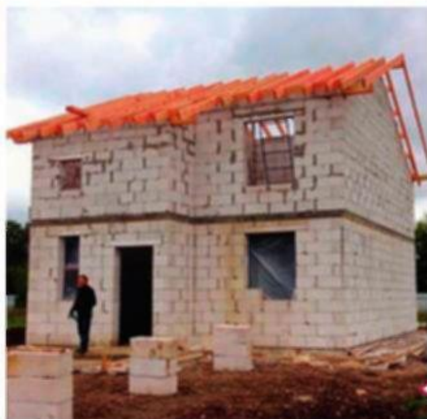
Возведение стен второго этажа
