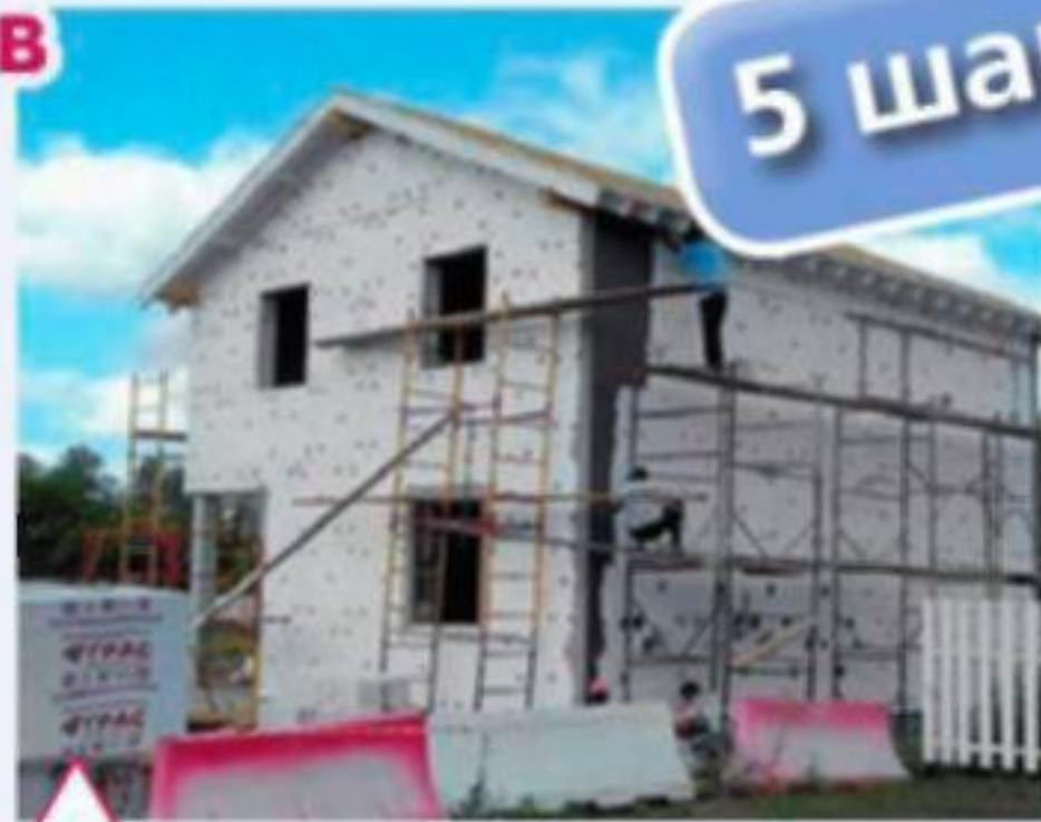
Оштукатуривание стен по полимерной сетке
