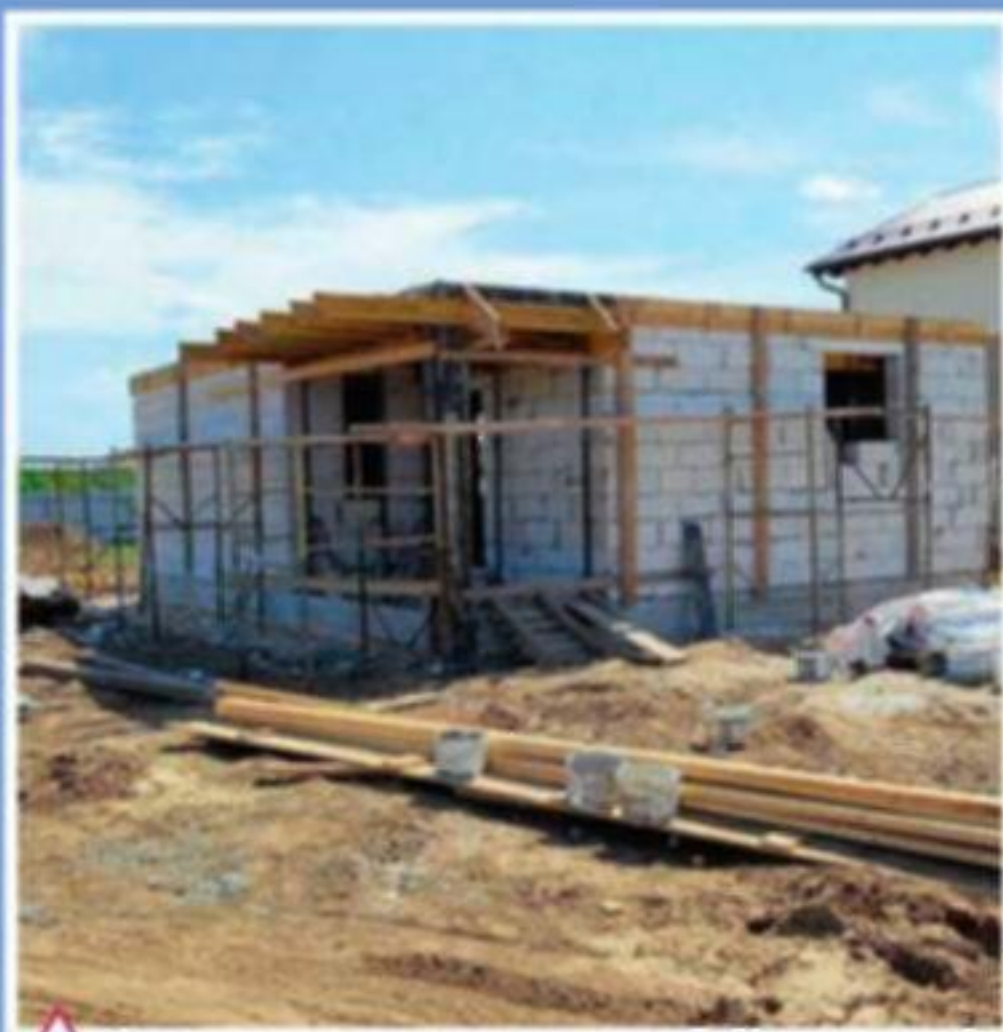
Устройство монолитного объединяющего пояса
