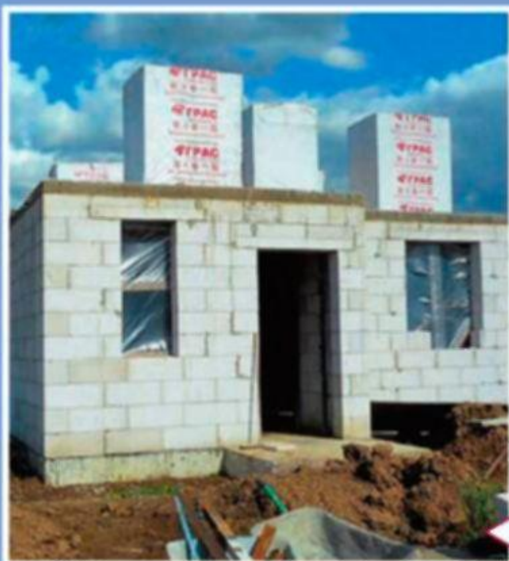
Устройство монолитного объединяющего пояса
