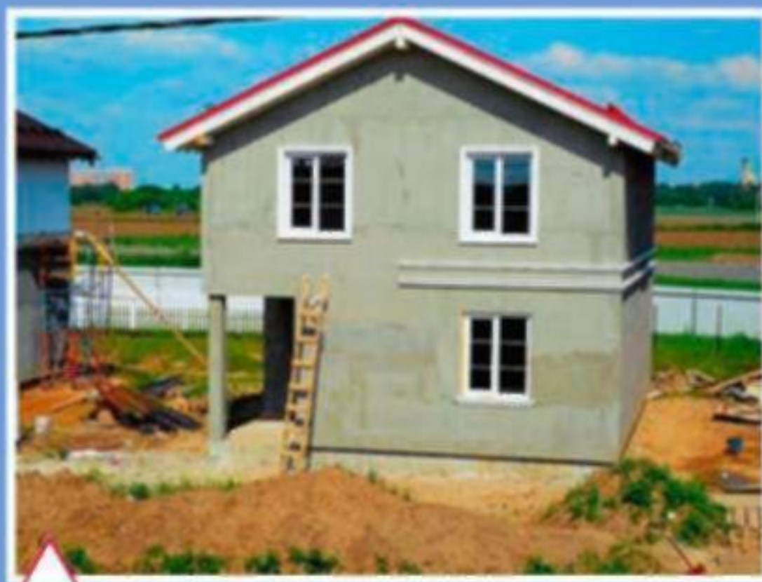
Монтаж лепных элементов
