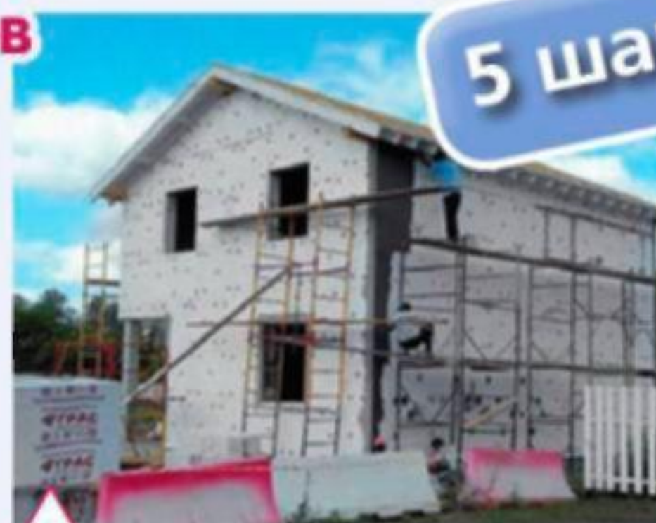
Оштукатуривание стен по полимерной сетке
