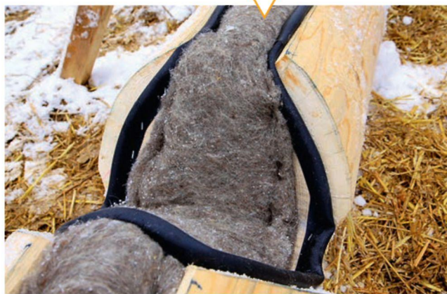
Оцилиндрованное бревно с утеплителем из овечьей шерсти
