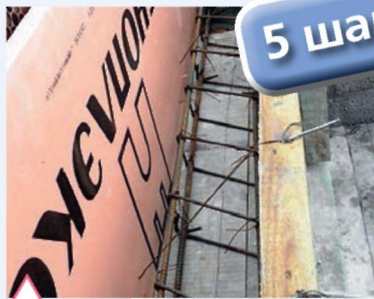
Устройство монолитных перемычек над оконными и дверными проемами
