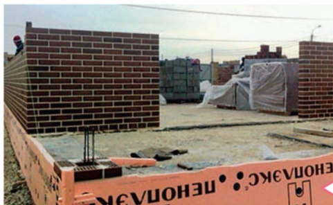
Кладка внешней стенки с использованием растворной смеси белого цвета
