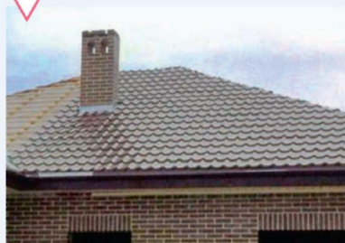
Укладка металлочерепичного кровельного покрытия
