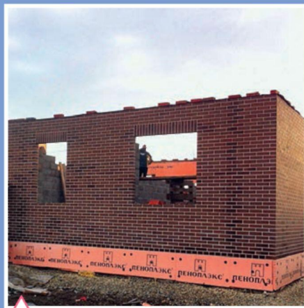
Стены дома возведены под крышу. Монтаж каркаса антисейсмического пояса
