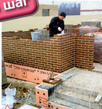
Кладка внешней стенки с использованием растворной смеси белого цвета
