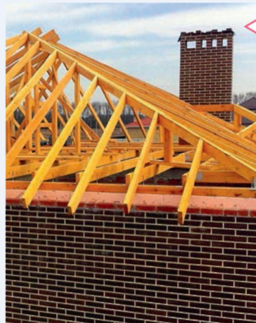
Стропильная конструкция, обработанная огнебиозащитным составом
