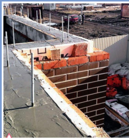
Антисейсмический монолитный пояс и шпильки для крепления мауэрлата
