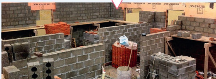
Возведение внутренних стен из керамических блоков
