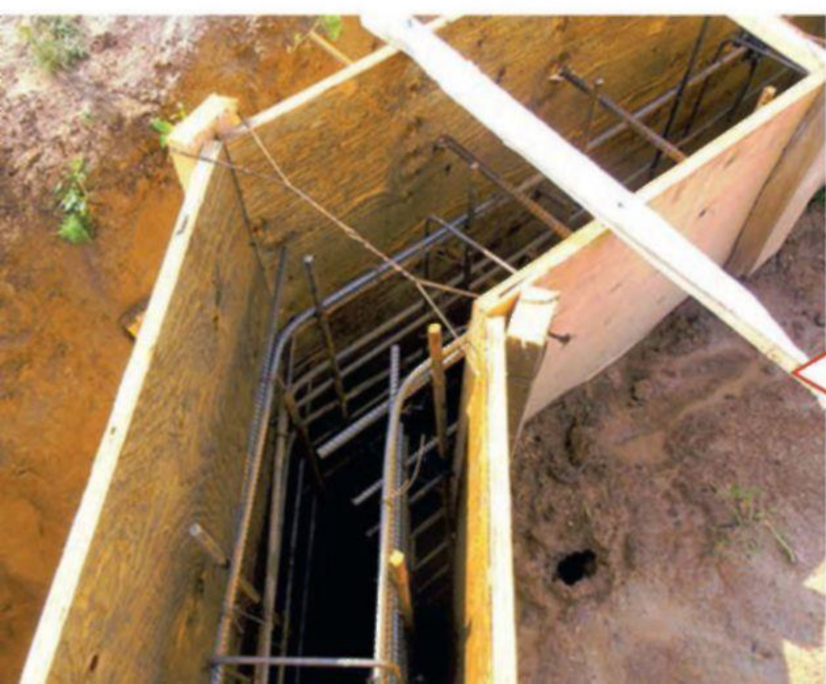
△ Дом из клееного бруса Vuokatti на монолитном буронабивном фундаменте
