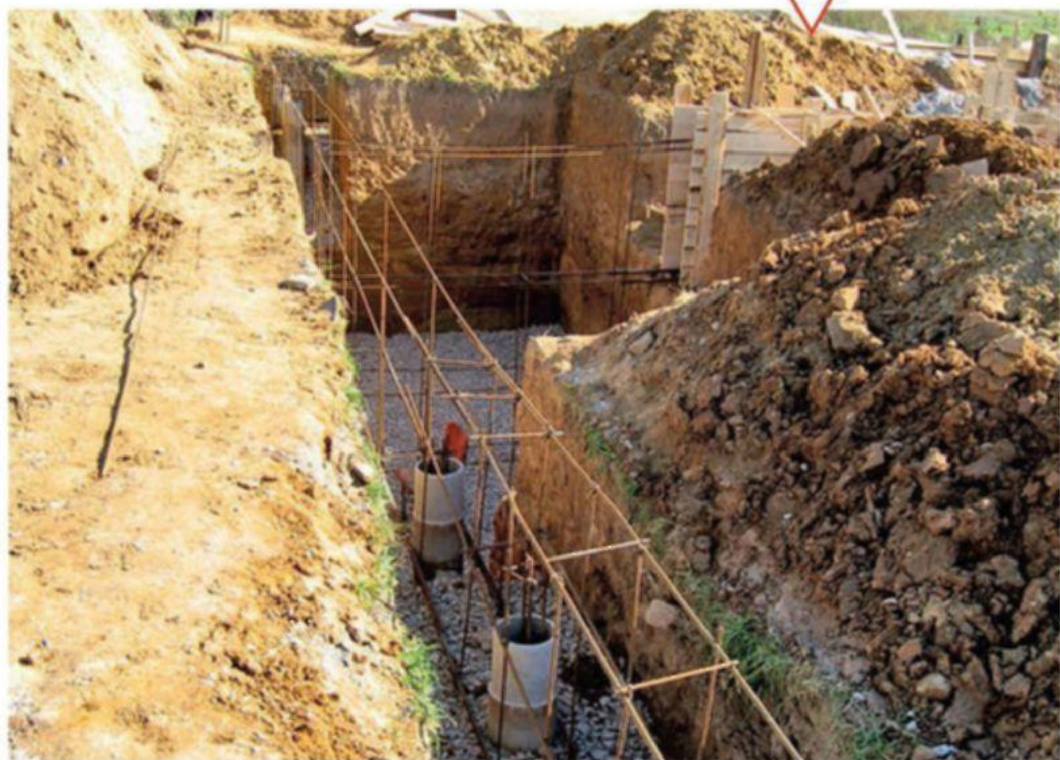
Строительство фундамента на базе буронабивных свай
