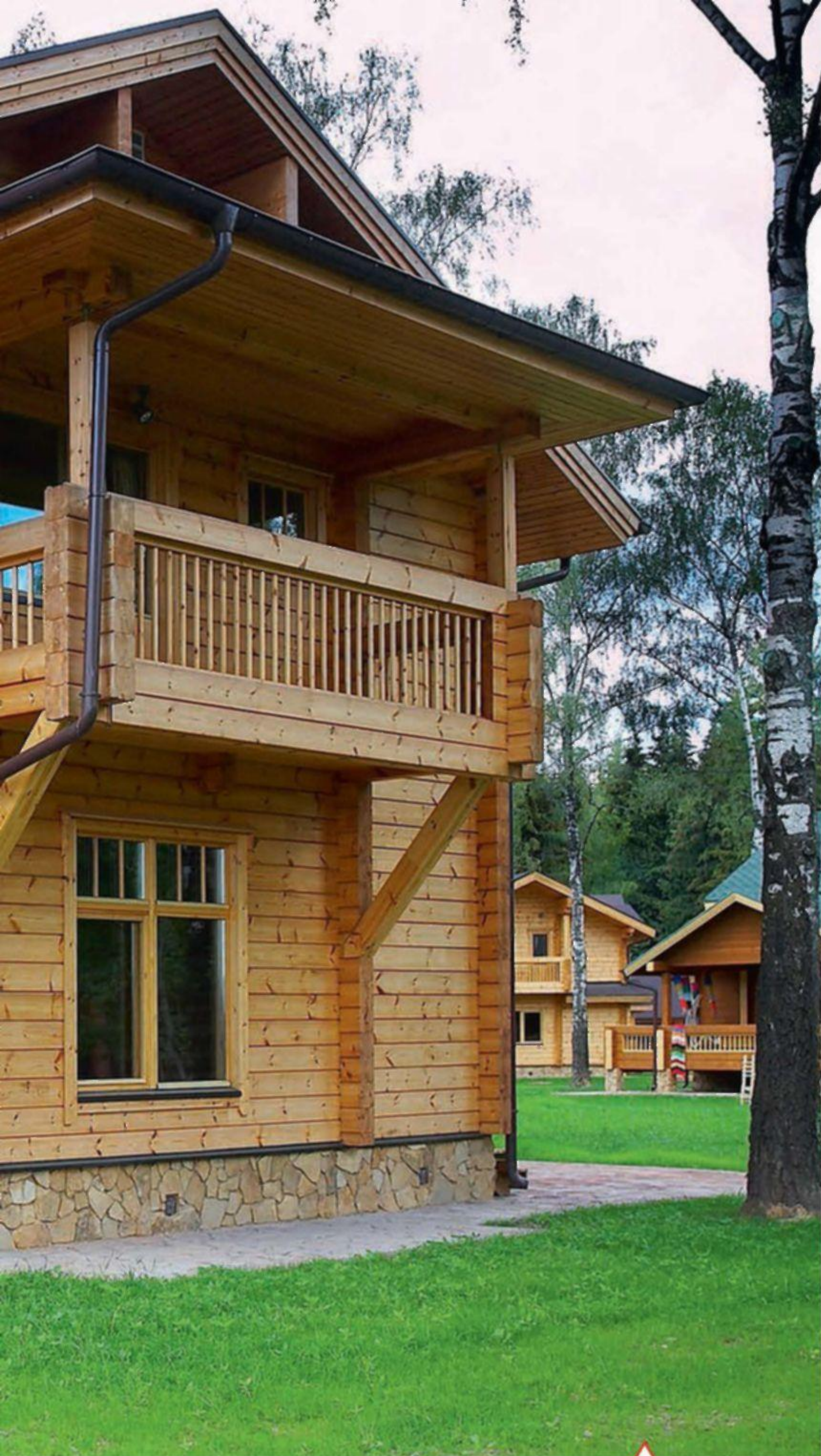
△ Дом из клееного бруса Vuokatti на монолитном буронабивном фундаменте
