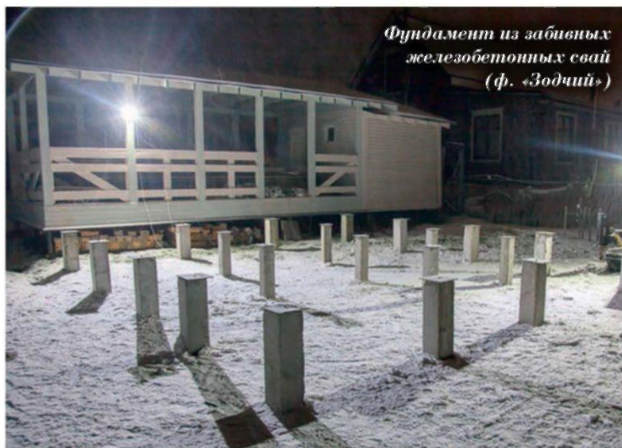
Забивка железобетонных свай с помощью мини-копра (ф. «Зодчий»)
