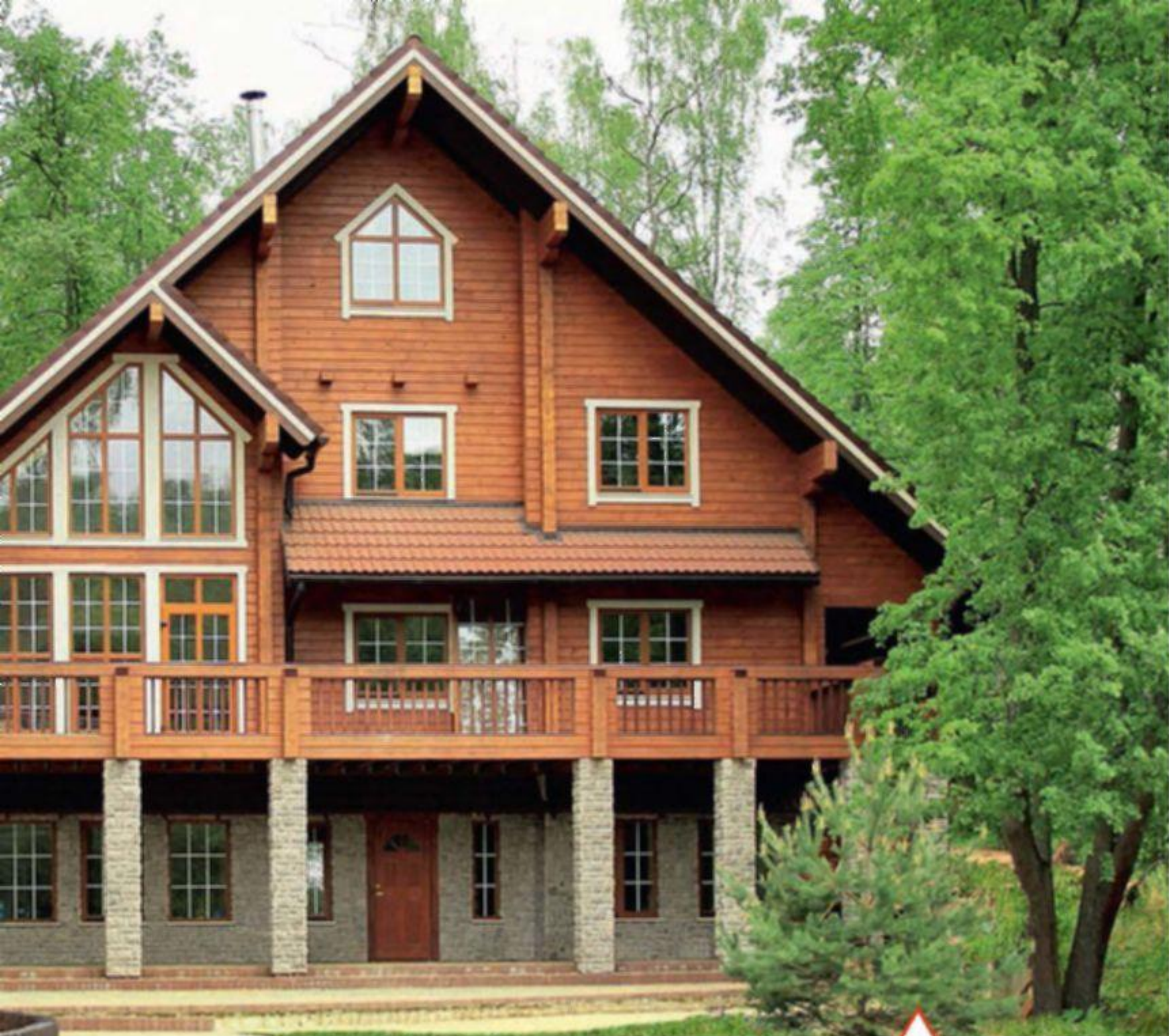
Деревянный дом на полно-заглубленном монолитном фундаменте с высоким цокольным этажом (ф. «Палекс-Строй»)
