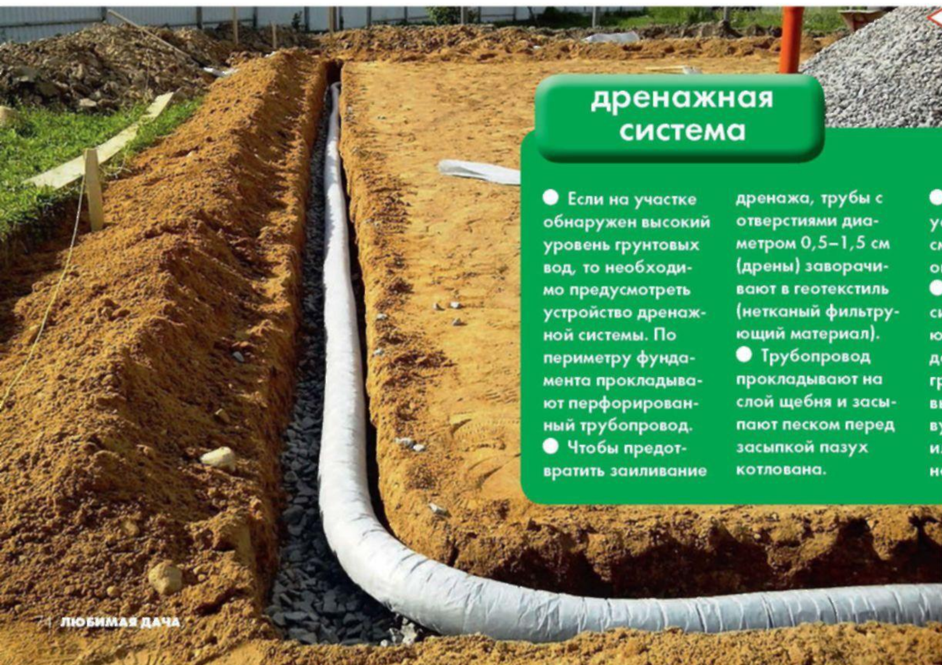
Дренажный контур вокруг фундамента (ф. «Каптемир Групп»)
