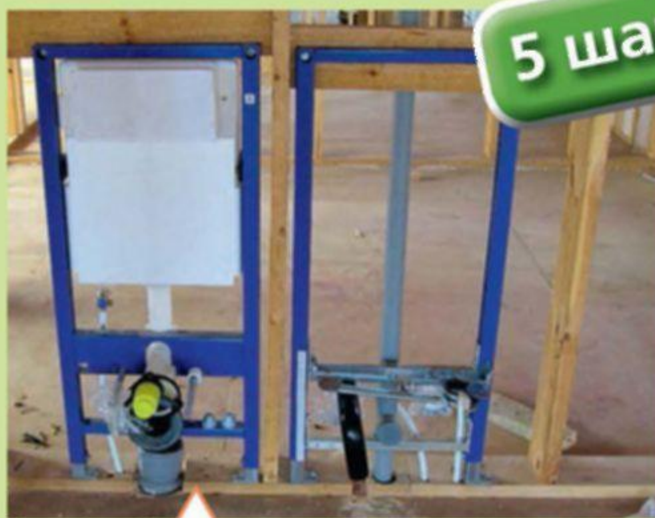
Система установки для монтажа подвешеного сантехнического оборудования
