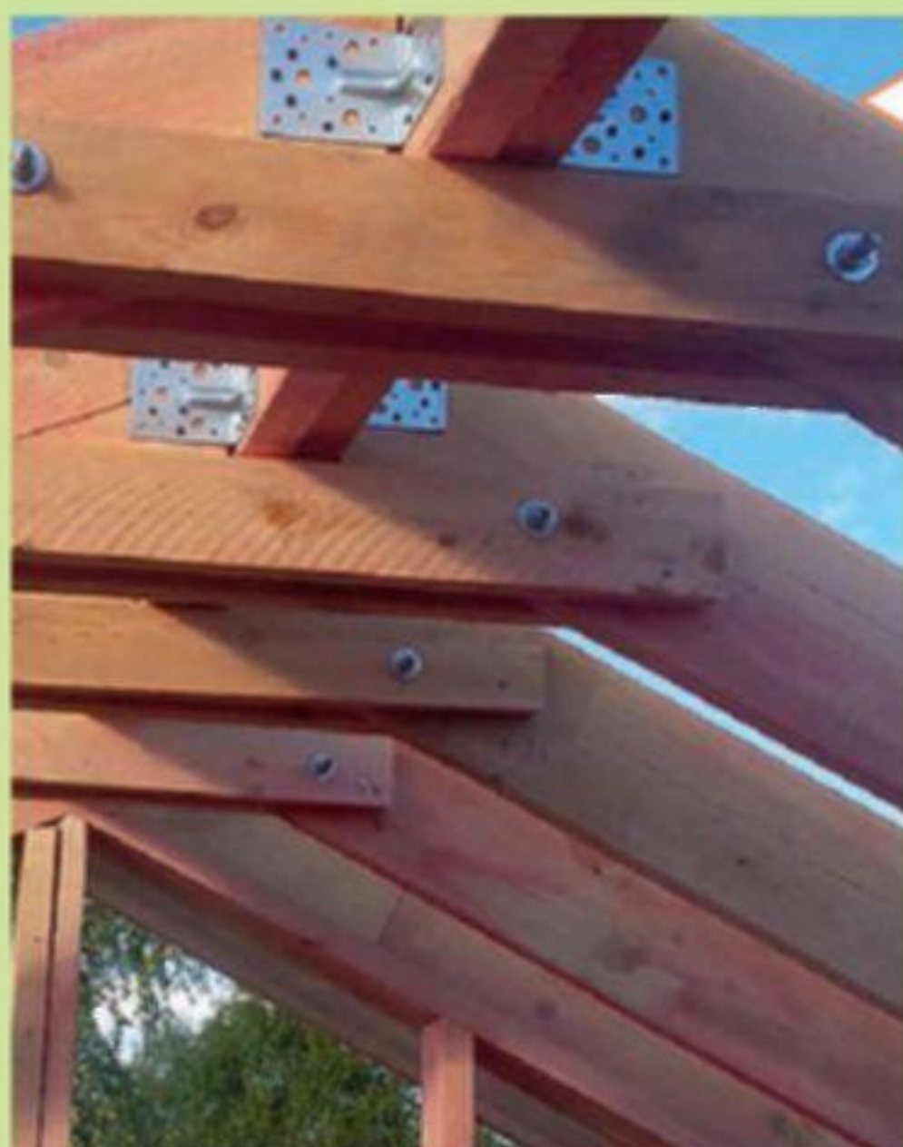
Коньковый узел стропильной конструкции
