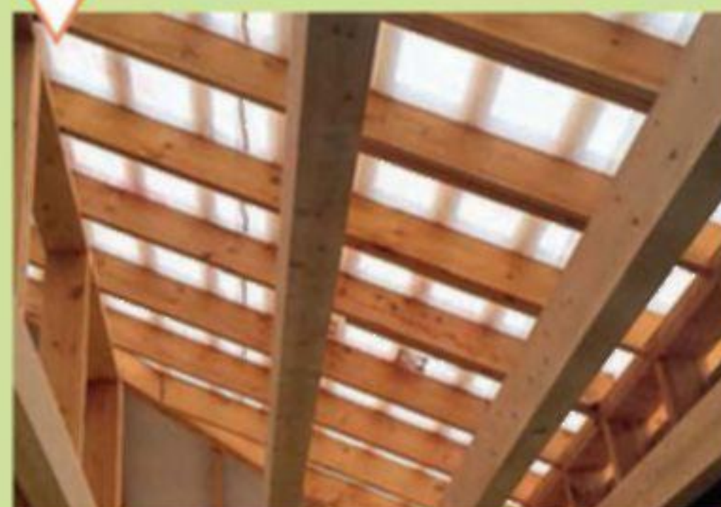
Вид стропил и смонтированной подкровельной гидроизоляционной мембраны
