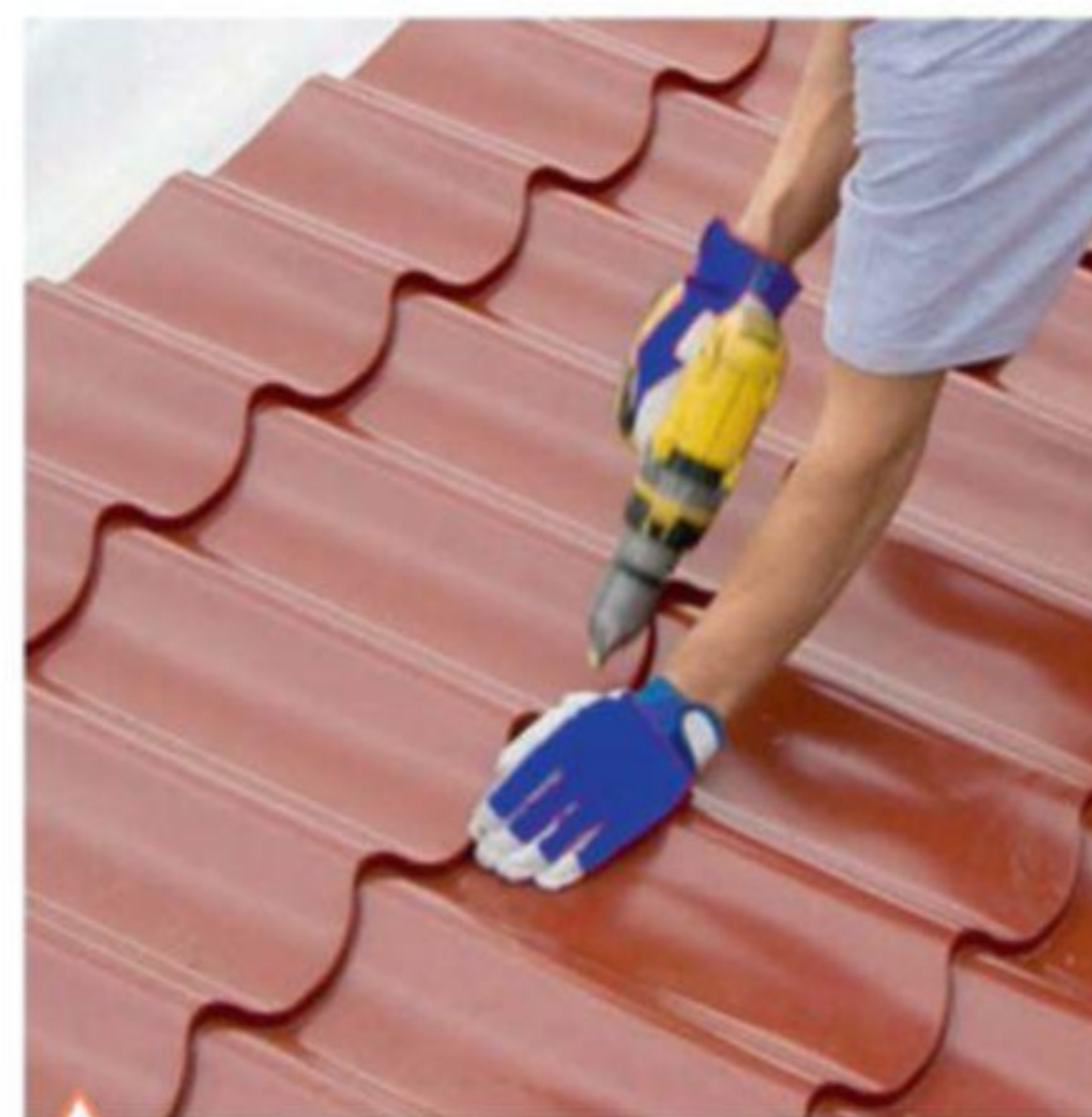
Укладка металлочерепицы
