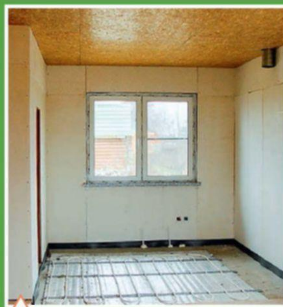
Монтаж системы кабельного обогрева в помещении кухни
