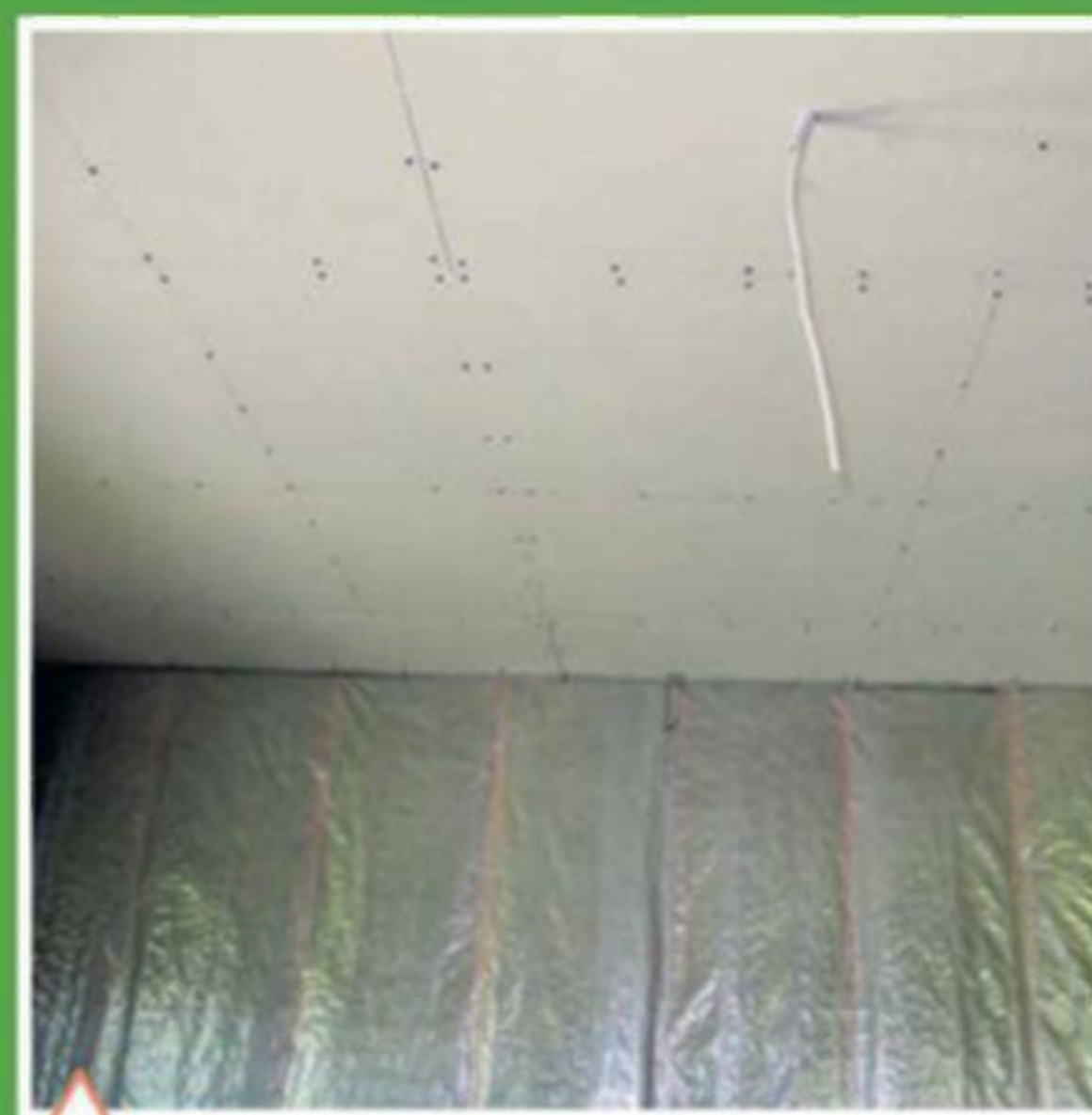
Обшивка потолка гипсокартонными листами
