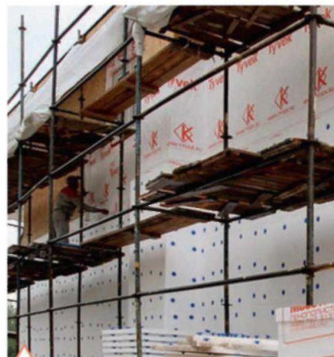
Утепление фасадов плитами из пенополистирола
