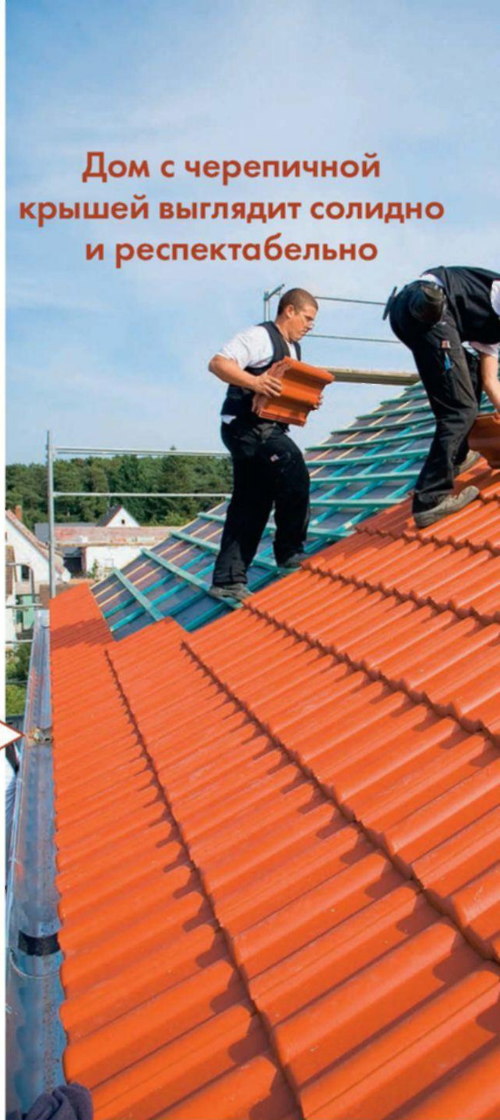
Монтаж кровельного покрытия – керамической черепицы Braas – на обрешетку
