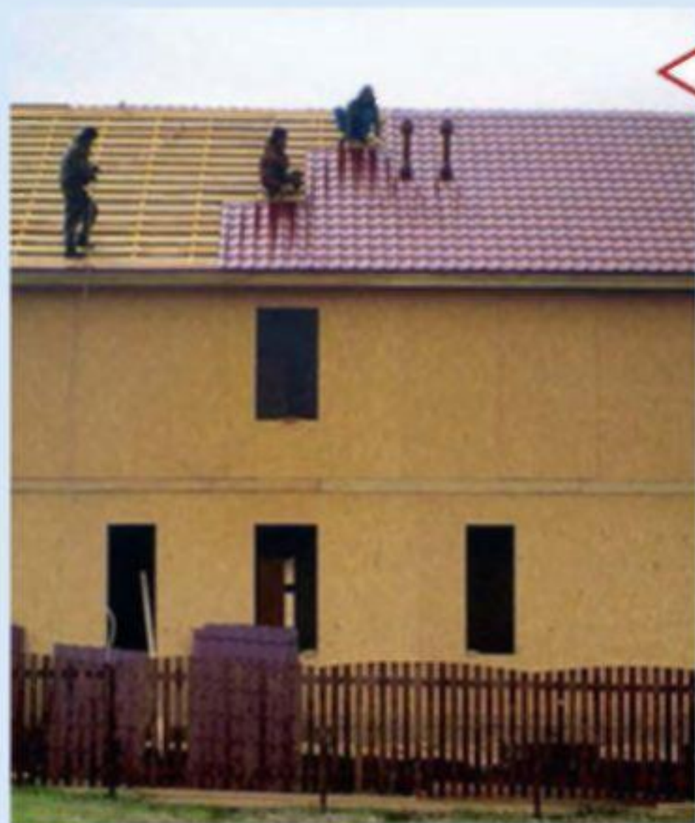
Монтаж металлочерепицы
