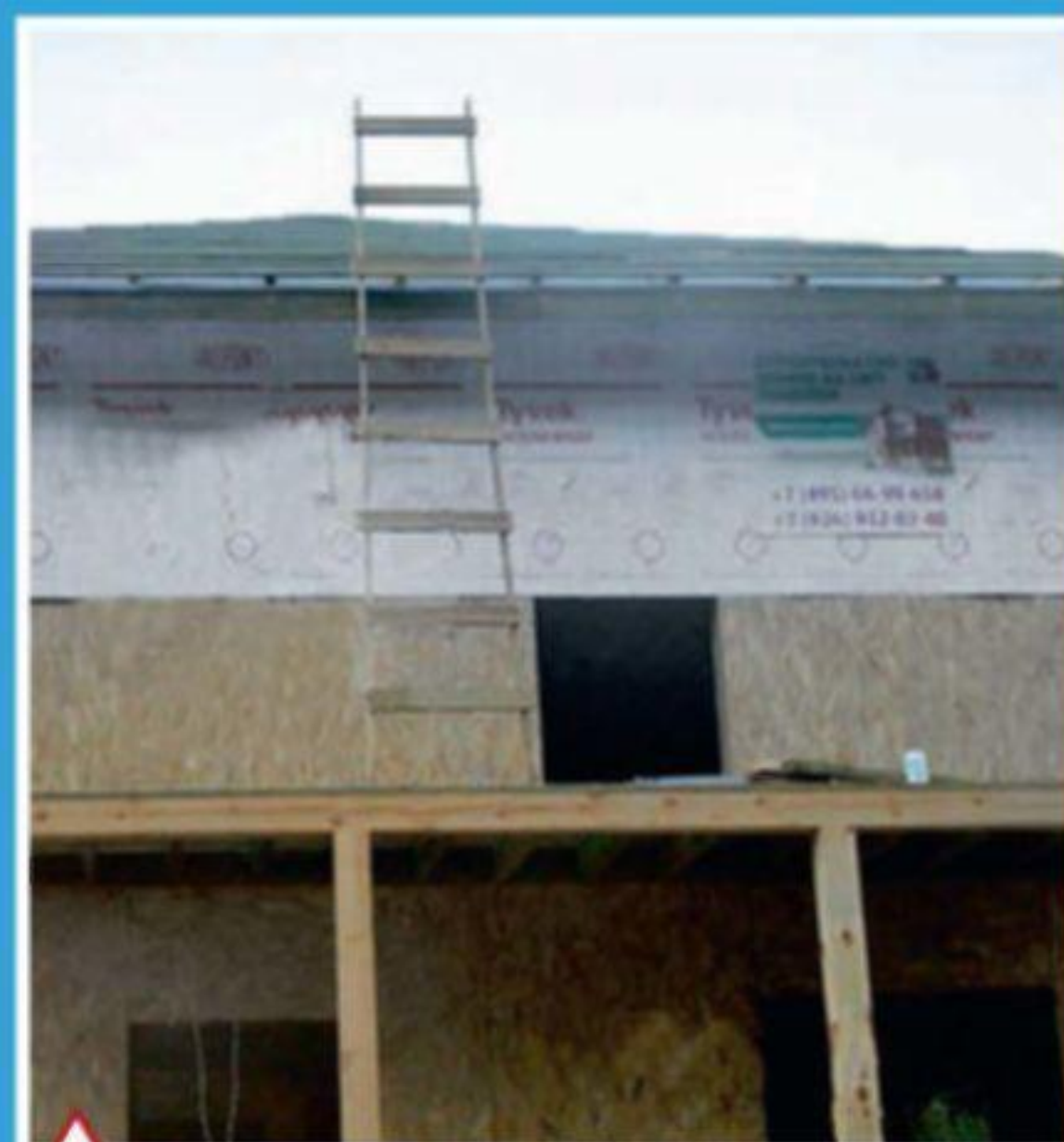
Монтаж гидроветрозащитной мембраны
