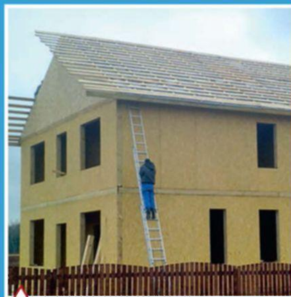
Обрешетка под кровельное покрытие из металлочерепицы
