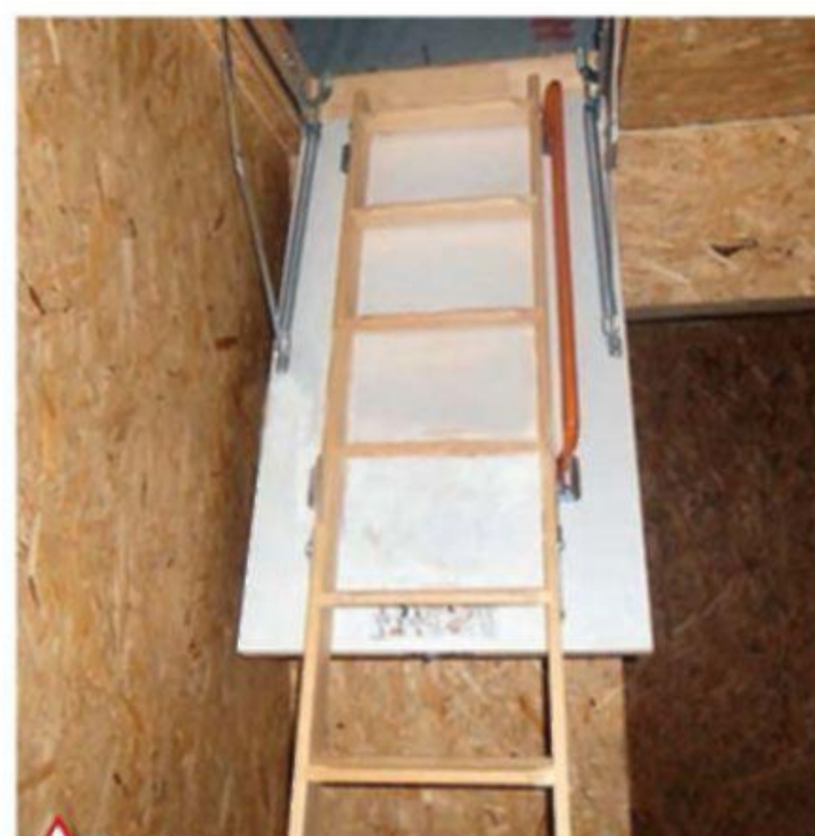
Чердачная лестница на чердачок, обустроенный у самого конька скатной крыши
