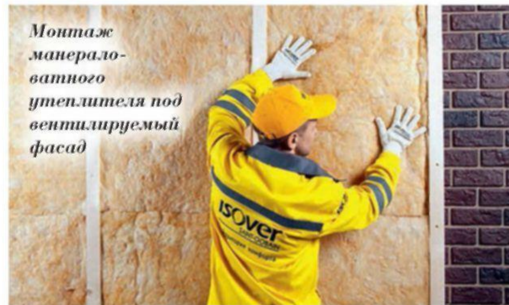
Между утеплителем и облицовкой оставляют вентиляционный зазор
