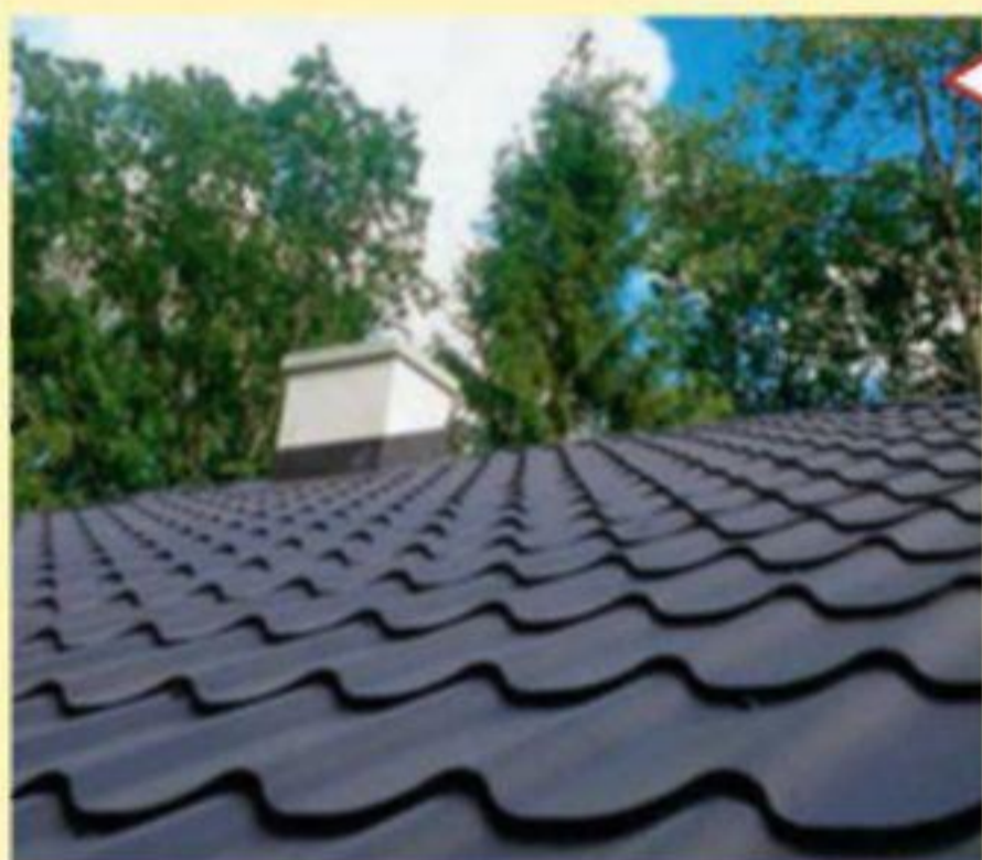
Вид кровельного покрытия из металлической черепицы
