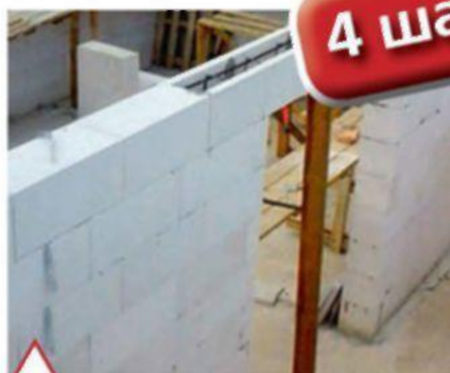
Армированная перемычка из фасонных блоков
