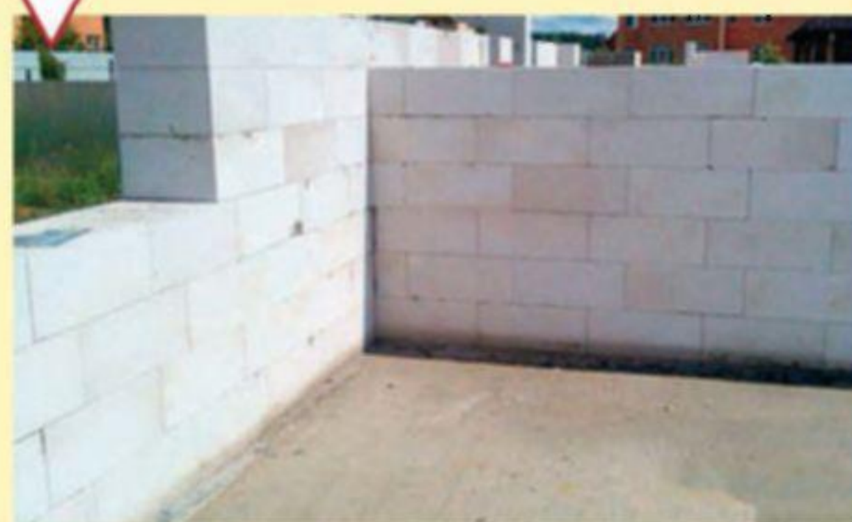
Первый ряд блочной кладки Вид стен изнутри
