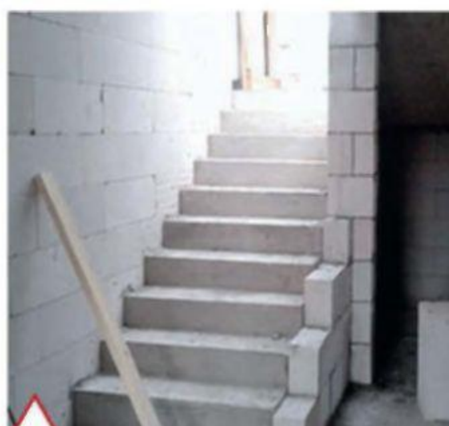
Внутренняя монолитная лестница
