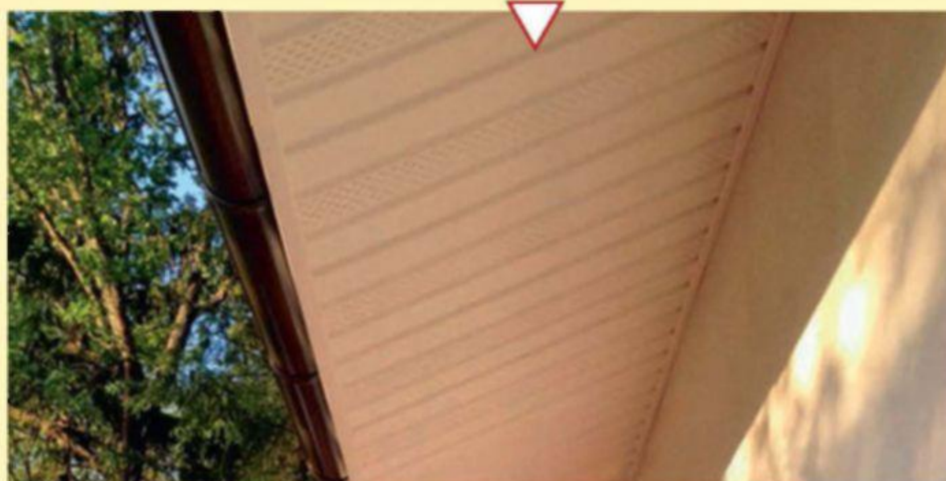
Подшитые профилированными софитами карнизные свесы
