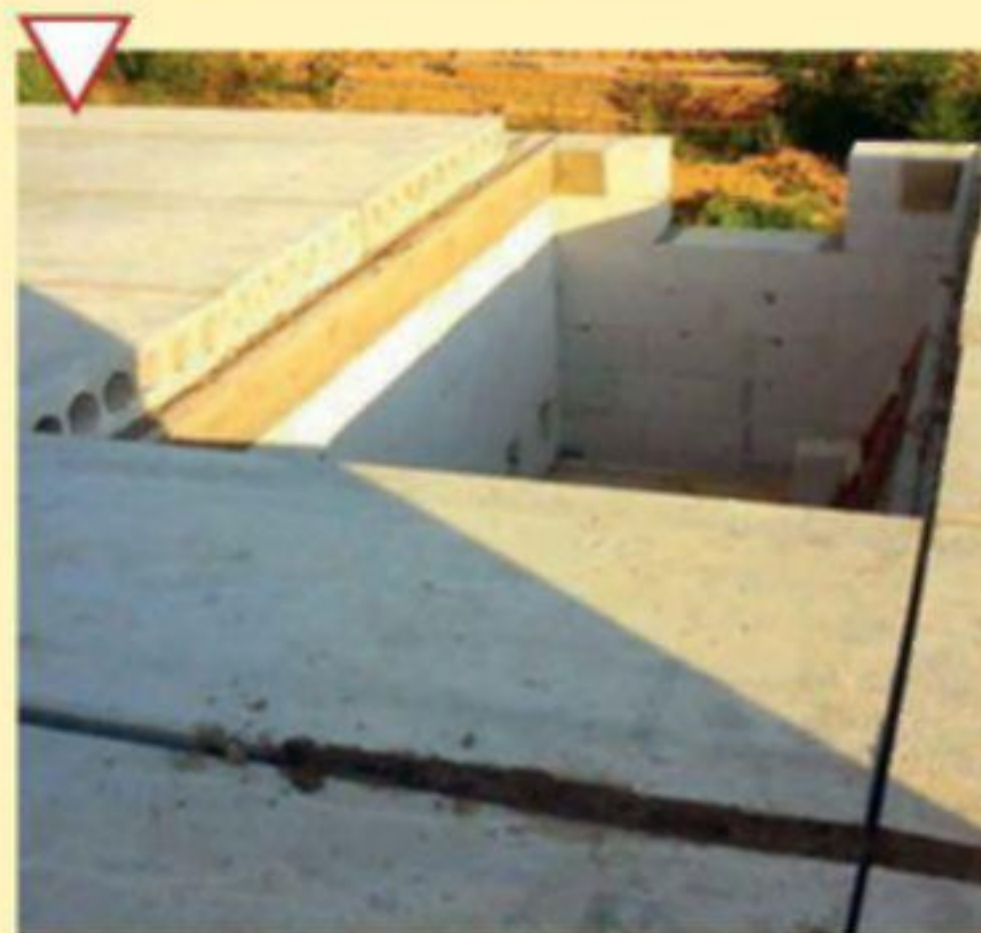
Перекрытие из сборных железобетонных плит
