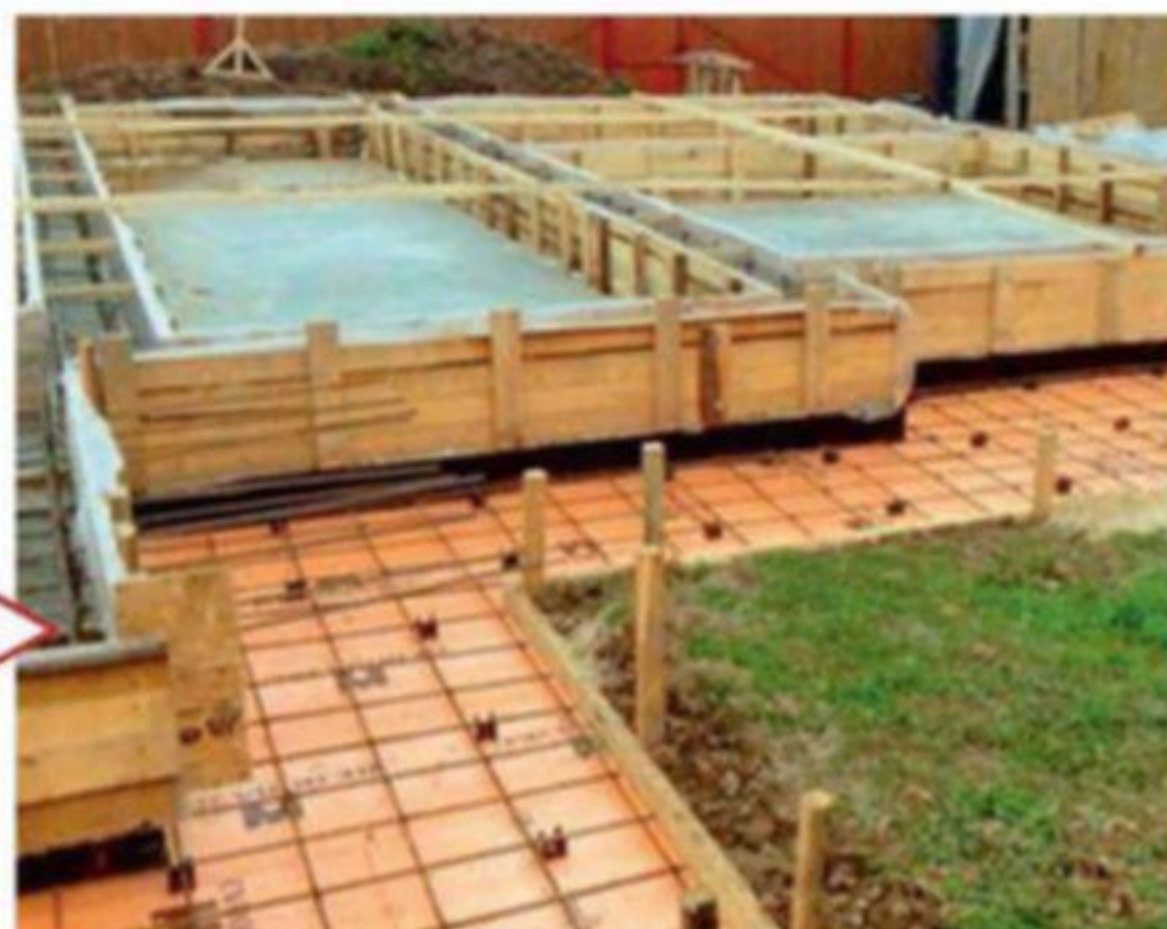
Опалубка цоколя с установленным арматурным каркасом
