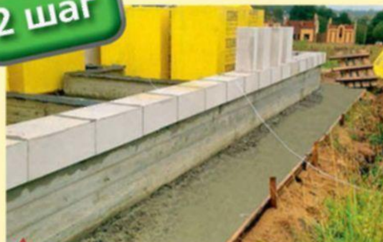
Первый ряд блочной кладки Вид стен изнутри
