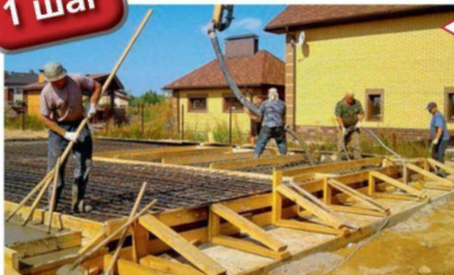
Бетонирование фундаментной плиты
