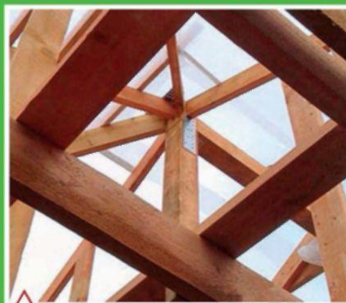
Опорный узел стропильной конструкции
