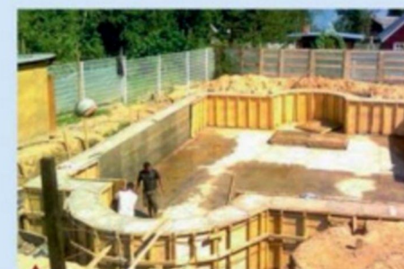
Распалубка монолитного фундамента
