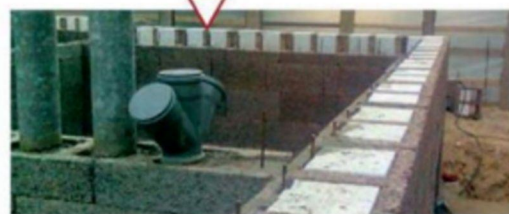
Инженерные коммуникации, встроены в блочную кладку
