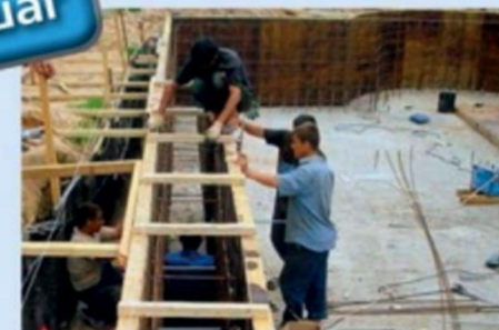
Монтаж арматурного каркаса и опалубки стен фундамента
