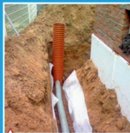
Устройство дренажного водопровода
