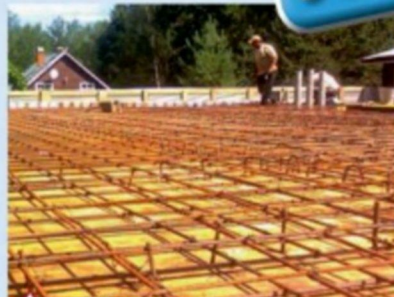
Монтаж арматурного каркаса монолитного перекрытия подвала
