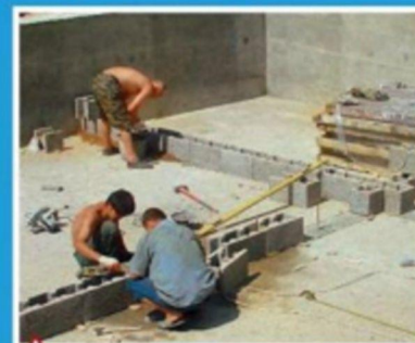
Закладка внутренних стен из блоков Durisol
