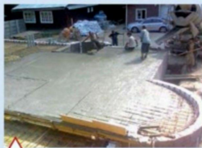
Бетонирование перекрытия подвала
