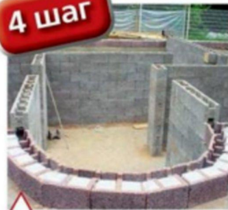
Первый ряд цоколя из блоков Durisol с пенополистирольными вставками
