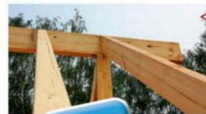
Стропильная конструкция крыши
