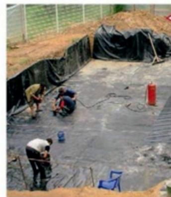
Устройство гидроизоляционной мембраны
