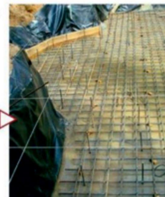
Устройство гидроизоляционной мембраны
