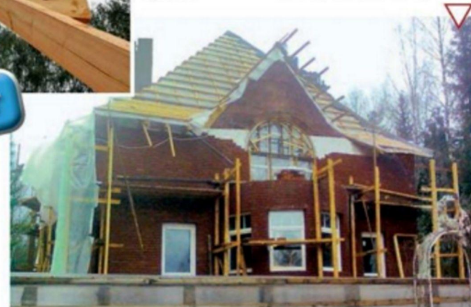
Стропильная конструкция крыши
