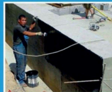
Нанесение праймера на наружную поверхность стен фундамента
