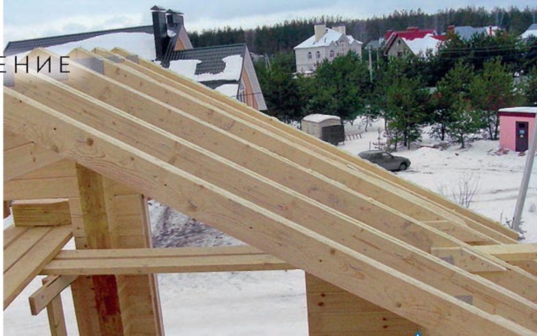
Монтаж кровли дома из клееного бруса
