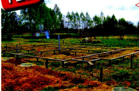
Монтаж балок нулевого перекрытия и обвязки под монтаж стеновых панелей первого этажа
