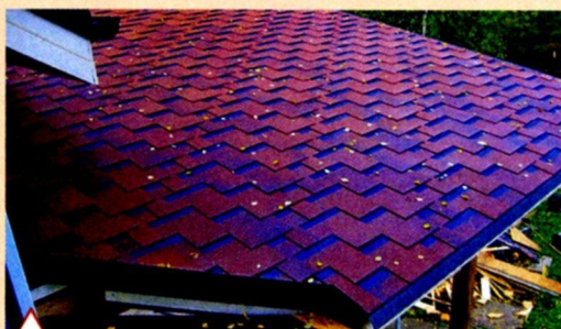
Вид готового покрытия
