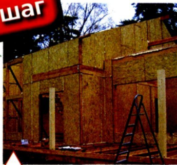
Монтаж стропильной конструкции скатной крыши
