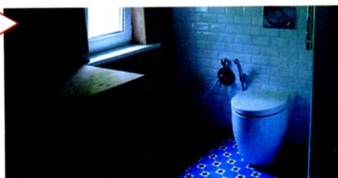
Напольный унитаз, смонтированный на скрытой под стеновой облицовкой системе инсталляции
