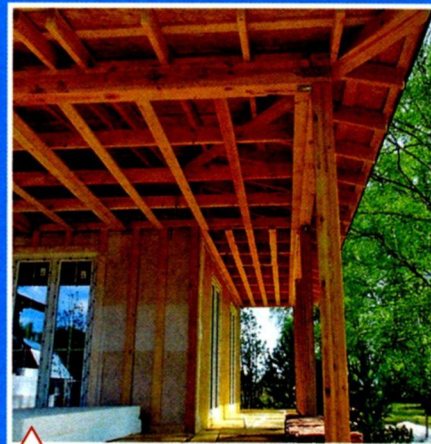
Монтаж гидроветрозащитной мембраны
