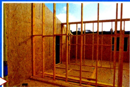
Монтаж перегородок в мансарде
