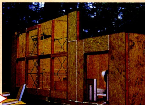
Монтаж первых стеновых панелей
