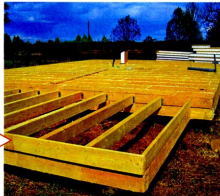
Монтаж балок нулевого перекрытия и обвязки под монтаж стеновых панелей первого этажа
