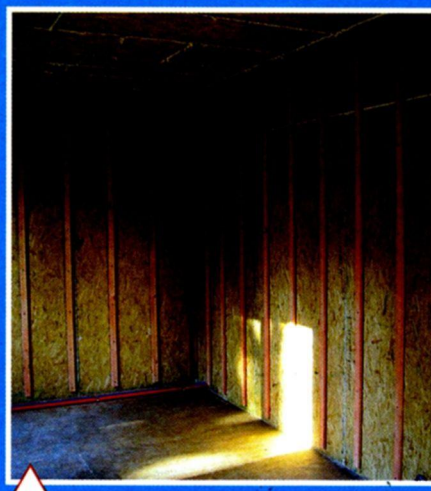
Обрешетка под декоративную обшивку стен
