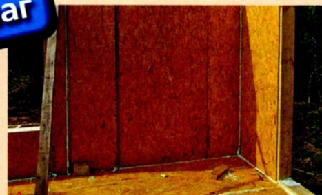
Монтаж первых стеновых панелей
