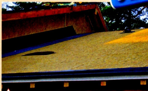
Укладка подкладочных материалов для кровли из битумной черепицы
