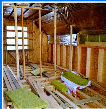
Монтаж подкровельной пароизоляции
