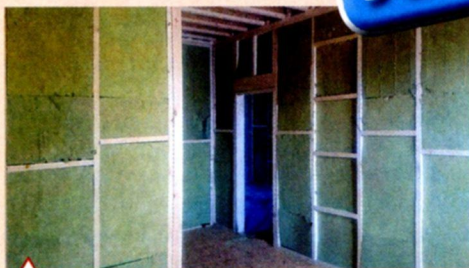
Заполнение каркаса стен теплоизоляционными минераловатными плитами
