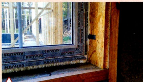
Установленное в каркасные стены окно из системного ПВХ-профиля
