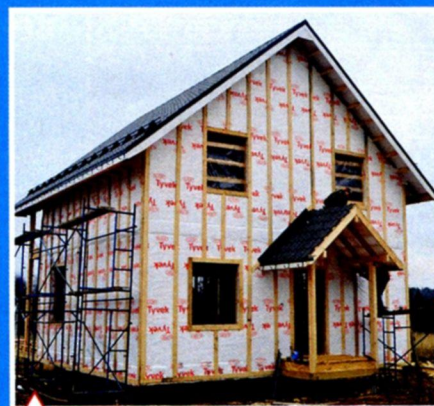
Фасад закрывают ветрозащитной гидроизоляционной мембраной
