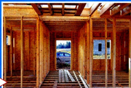
Вид пространственного каркаса первого этажа изнутри
