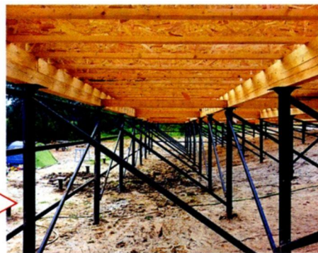
Возведенный фундамент на винтовых сваях
