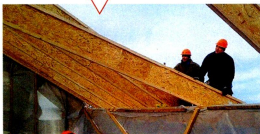
Стропильная конструкция готова к монтажу кровли
