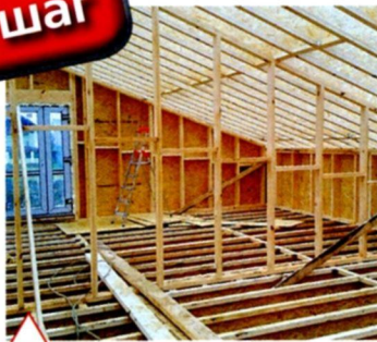
Монтаж стропил – наклонных двутавровых балок
