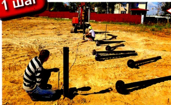
Подготовка к закручиванию винтовых свай
