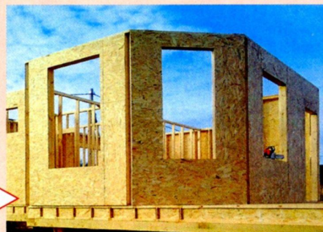
Монтаж каркаса первого этажа
