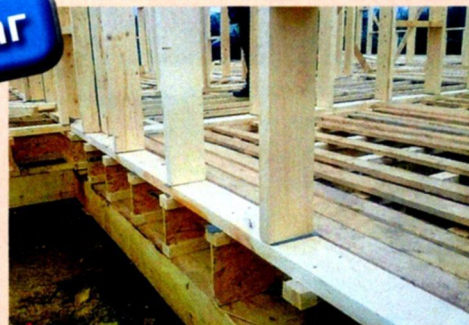
Монтаж каркаса первого этажа
