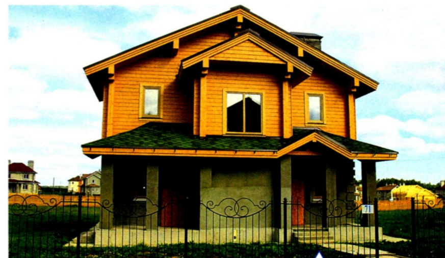
Первый этаж комбинированного дома построен из газобетонных блоков, второй — из клееного бруса
