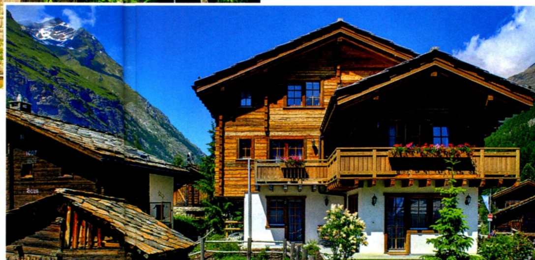
Первый этаж комбинированного дома построен из газобетонных блоков, второй — из клееного бруса
