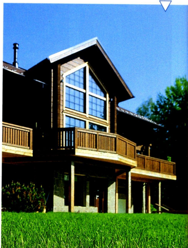
Верхние этажи дома выполнены из клееного бруса (Lumi Polar)
